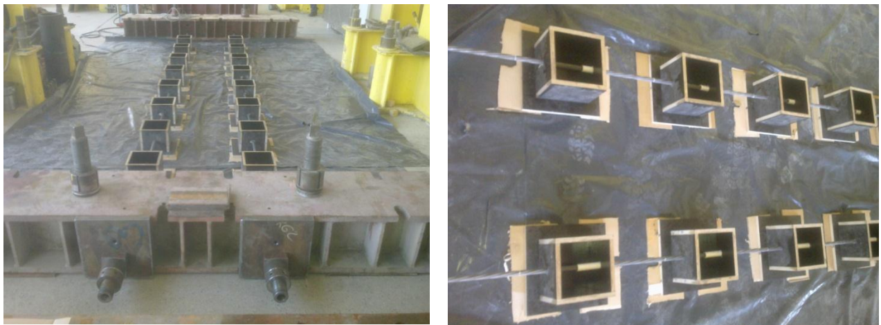
Rys. 7.32 Przygotowane formy do betonowania w fazie I
