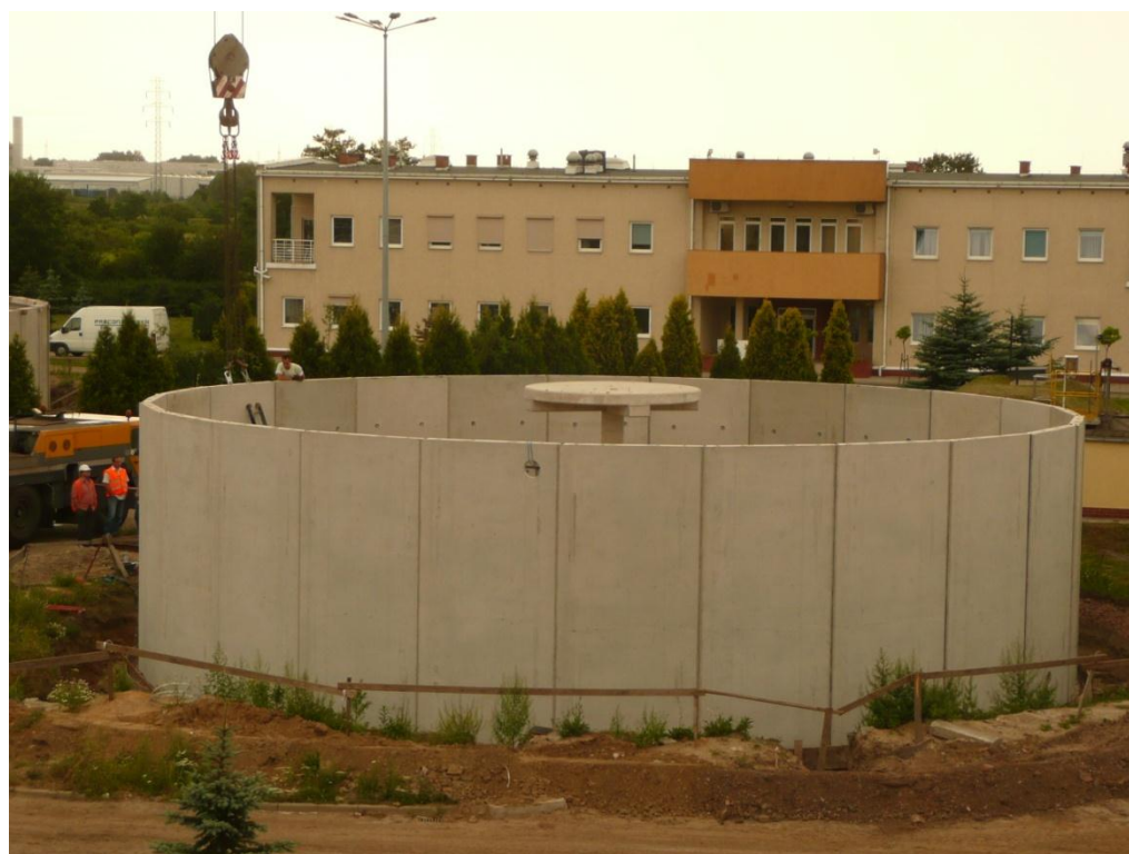
Rys. 6.3 Widok zbiornika w systemie C8 w trakcie realizacji
