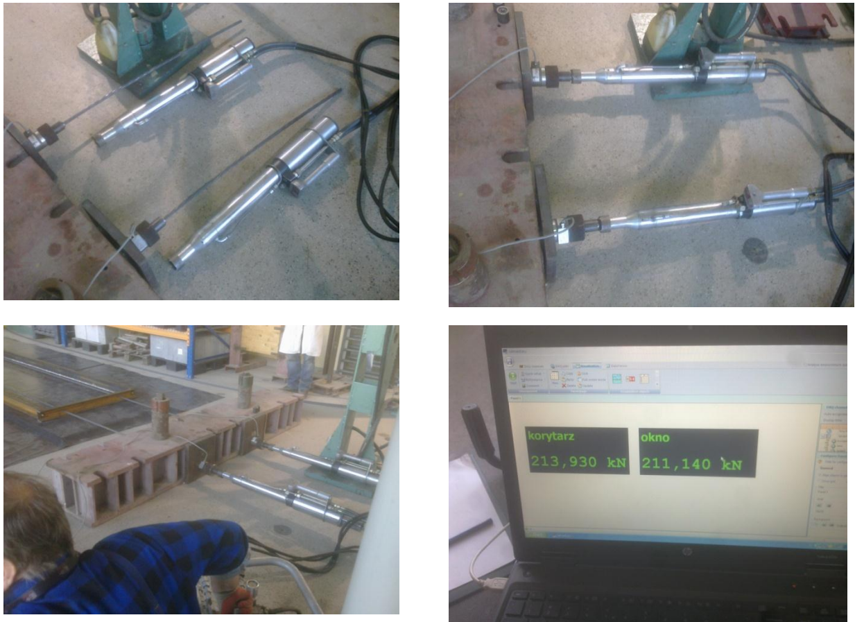
Rys. 9.34 Poszczególne etapy realizacji sprężenia
