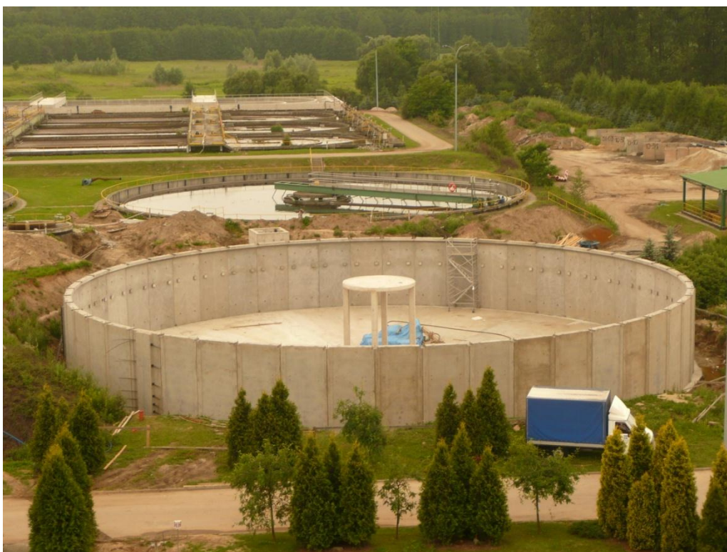
Rys. 6.2 Widok zbiornika w systemie C14 przed sprężeniem
