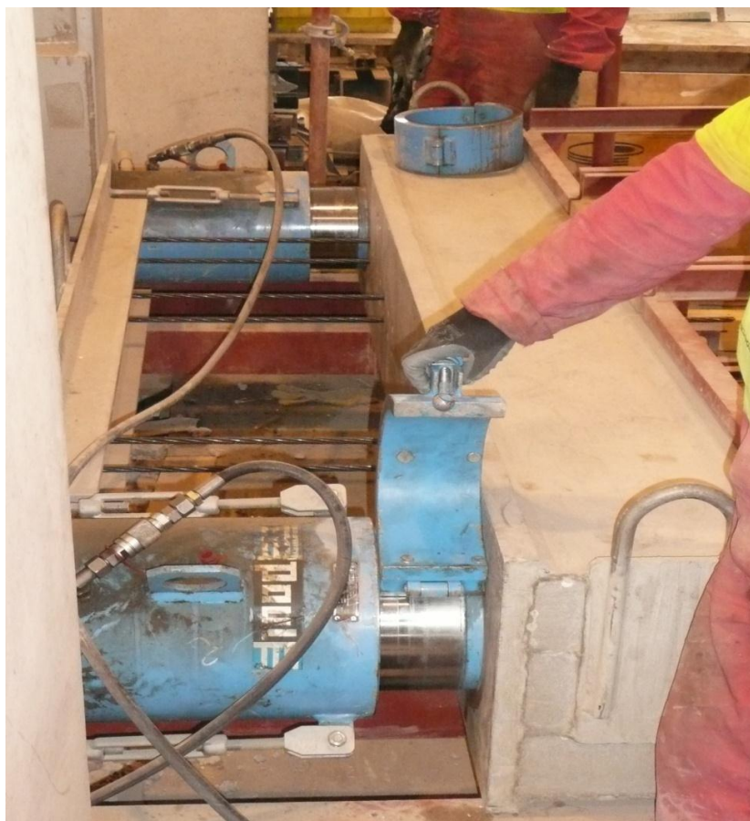
Rys. 9.4 Widok zakotwienia biernego przed zwolnieniem siły naciągowej
