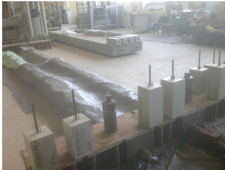
Rys. 7.34 Tor naciągowy po betonowaniu (na pierwszym planie i w głębi widać próbki przygotowane do badań)
