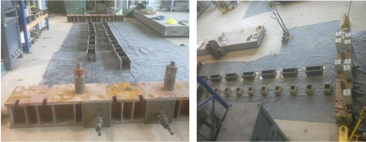
Rys. 7.33 Przygotowane formy do betonowania w fazie II
