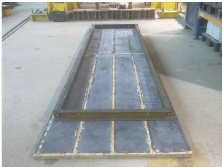
Rys. 9.32 Widok stalowych form usytuowanych na płytach OSB
