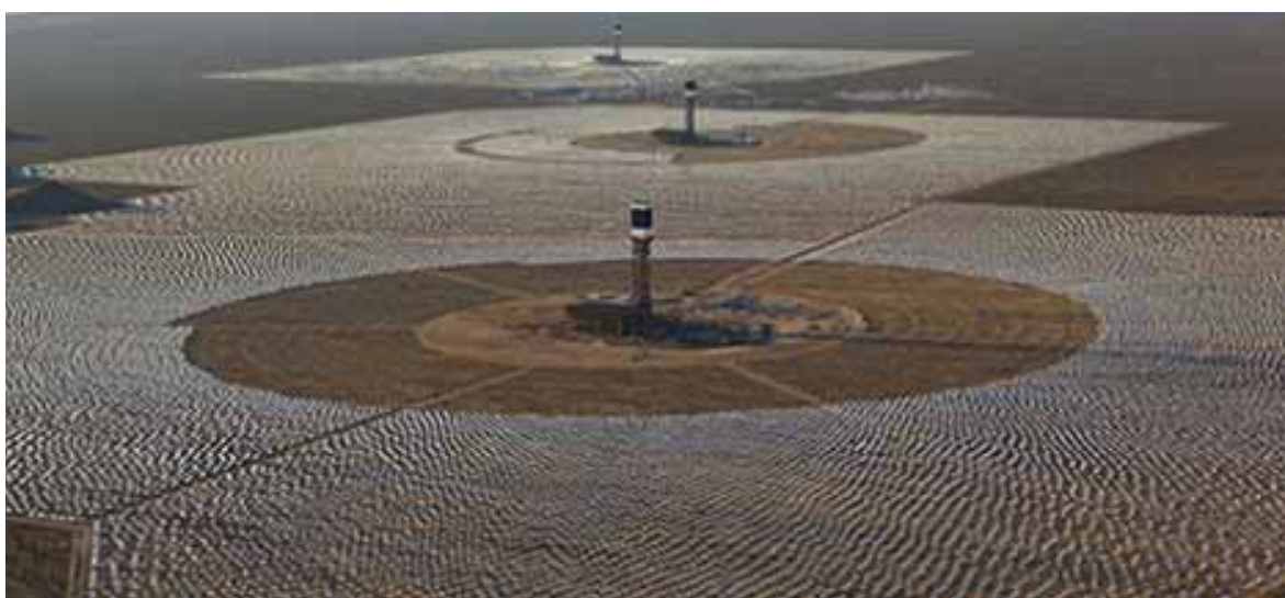
6.23. Elektrownia Ivanpah położona na granicy Nowady z Kalifornią oślepia pilotów komercyjnych linii lotniczych i spala przelatujące ptaki (fot.: ivanpahsolar.com, 2012)
