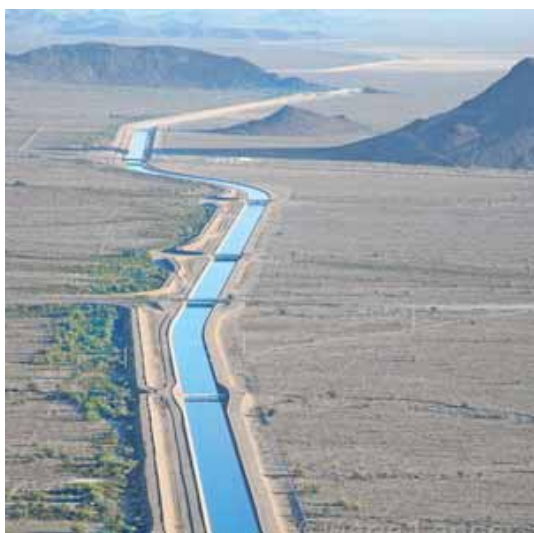
5.33. Kanał dostarczający wodę do miasta Phoenix z rzeki Kolorado, Central Arizona Project Canal (fot.: Flying M Photos, 2008)
