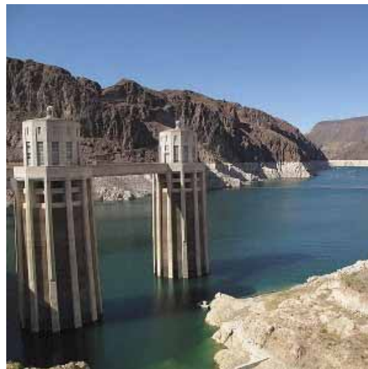
5.51. Wieże wlotowe na jeziorze Mead odsłonięte przy niskim poziomie wody, Newada (fot.: autorka, 2011)
