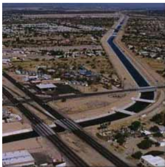
5.32. Kanał dostarczający wodę do miasta Phoenix z rzeki Kolorado (fot.: City of Tempe Water Services – Water Resources Plan Tempe Public Works Department Water Utilities Division, luty 2012)
