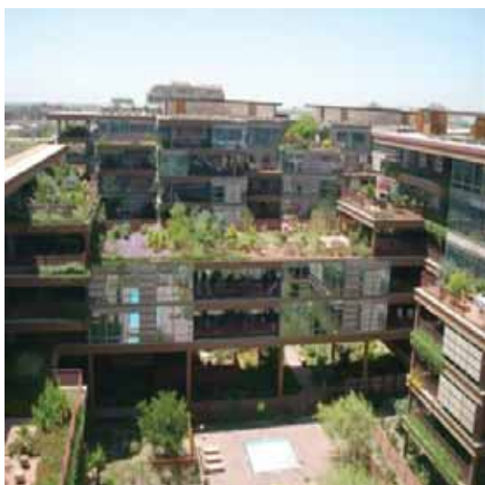
5.25. Nowa zabudowa wielorodzinna, Optima Camelview, Scottsdale, Arizona, 2011 (fot.: autorka)
