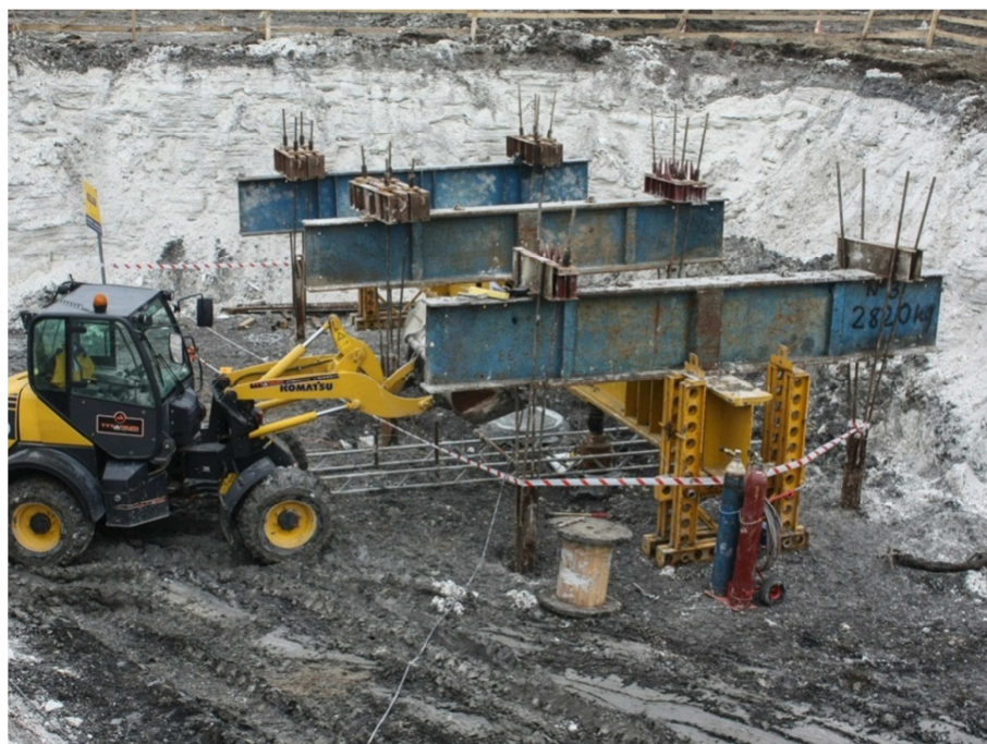
Fot. Z1.2. Poletko doświadczalne do badania pali wykonane przed rozpoczęciem projektowania posadowienia (fot. B. Czado)
