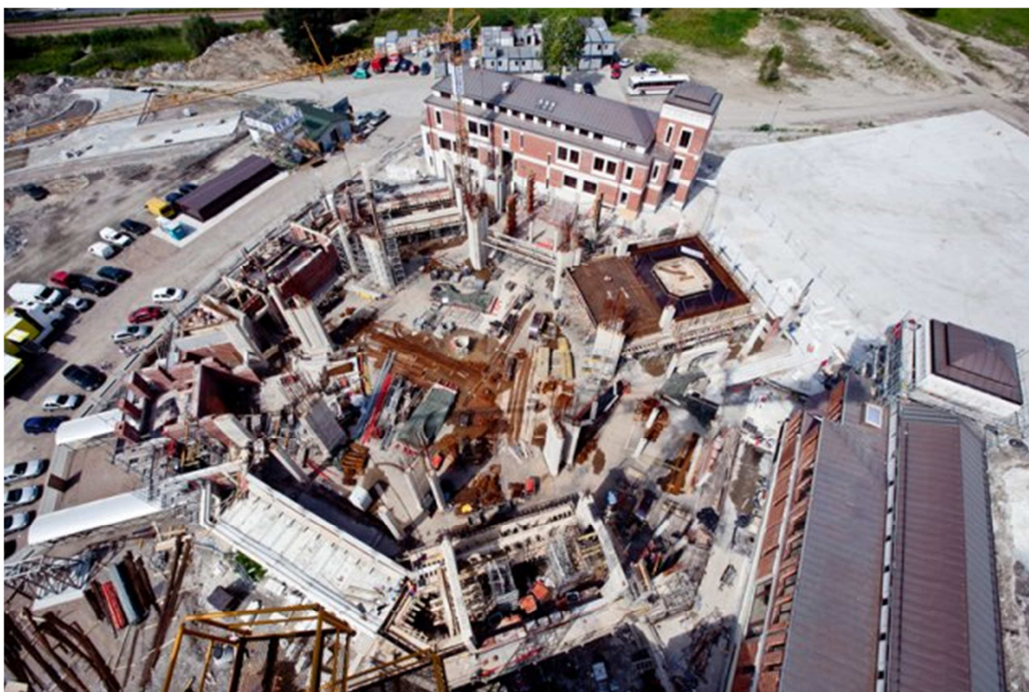
Fot. Z1.3. Budowa kościoła w ramach I etapu inwestycji Centrum Jana Pawła II, widok z lotu ptaka (Sionko, 2011)
