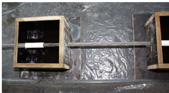
Rys. 7.13. Elementy typu I na torze przygotowane do betonowania
