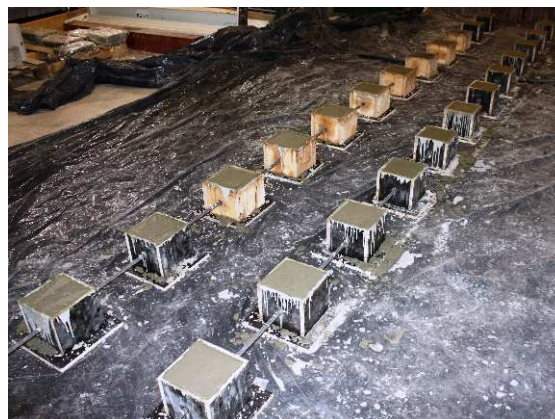
Rys. 7.15. Zabetonowane próbki na torze naciągowym
