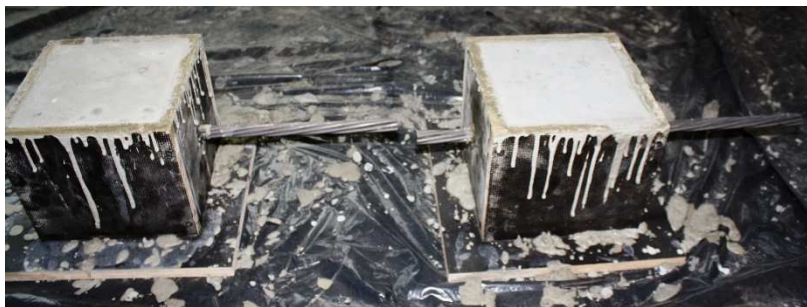
Rys. 7.20. Cięcia splotów na torze pomiędzy elementami kostkowymi po zwolnieniu siły naciągowej
