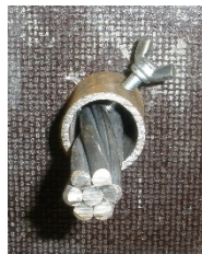
Rys. 7.6. Zabezpieczenie splotów przed przemieszczeniami podczas betonowania
