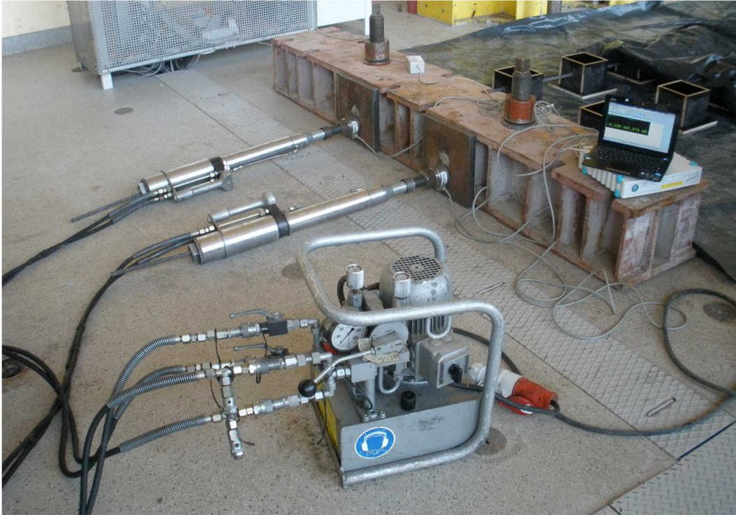
Rys. 7.11. Naciąg ciągien zestawem sprężającym (2 prasy, węże wysokociśnieniowe i agregat pom-powy) przy jednoczesnej rejestracji siły przetwornikami zamontowanymi pod zakotwieniem
