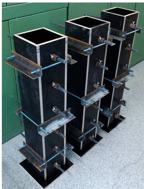
Rys. 7.7. Przygotowane formy z zamontowanymi splotami do betonowania
