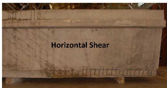
Rys. 3.11. Zniszczenie od rozerwania połączenia środka z dolną półką przy zniszczeniu strefy zakotwienia cięgien [96]
