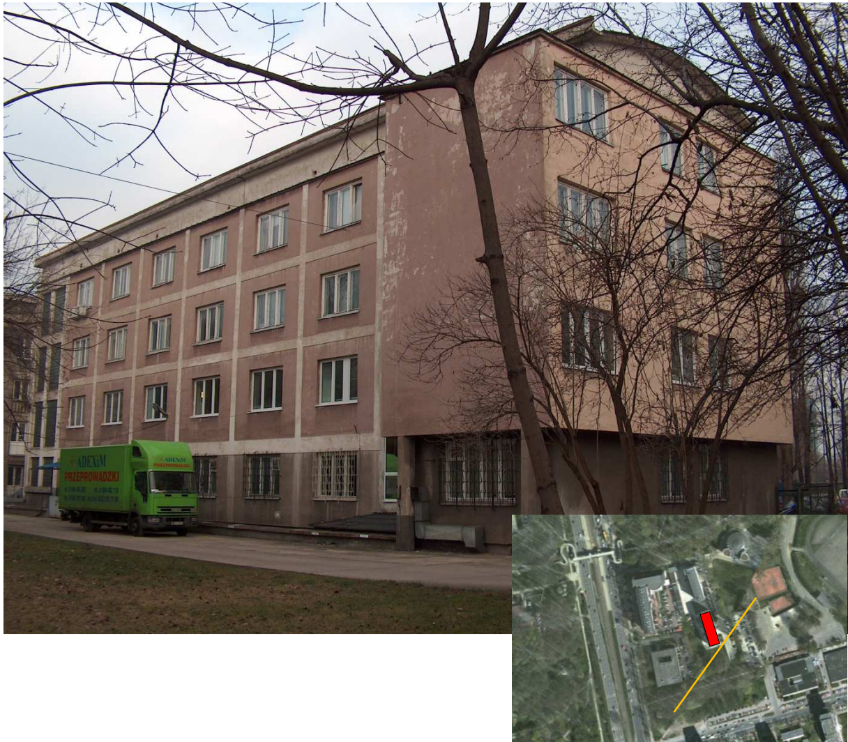
Rys. 3.8. Ogólny widok budynku N186 od strony alei Niepodległości. Kolorem czerwonym zaznaczono położenie budynku. Kolorem żółtym zaznaczono przebieg linii metra. Zamieszczona mapa pochodzi ze www.maps.google.pl
