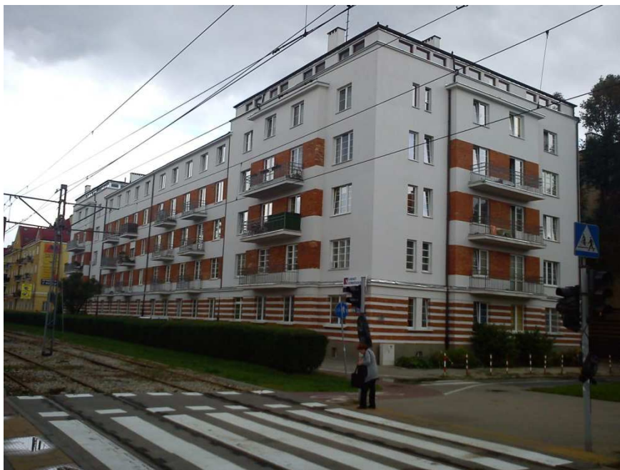
Rys. 4.1.8. Widok budynku przy ul. Słowackiego
