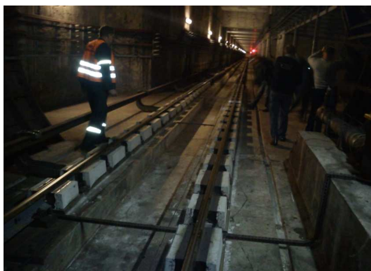
Rys. 4.1.9. Widok tunelu przy ul. Słowackiego w sąsiedztwie badanego budynku
