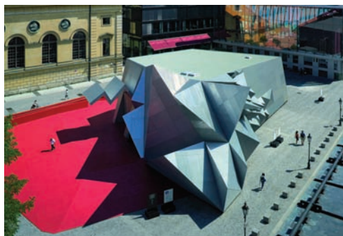
3.81. Forma zdarzenia 21 Mini Opera Space intrzyguje dynamiczną, „agresywną” geometrią oraz intensywną czerwienią połyskującą na świetle.
