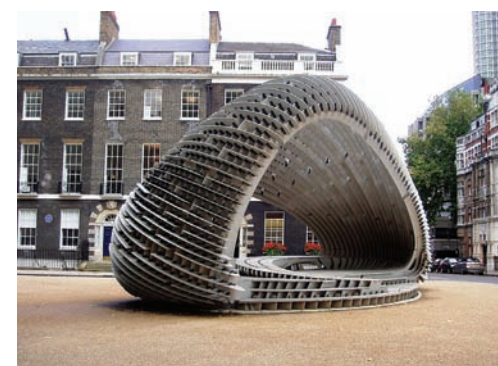
3.9. Zdarzenie [C] Space-DRL 10 skonstruowano z wykrzywionych profili. Każdy profil połączony jest z następnymi minimum trzema innymi ustawionymi poprzecznie w odległości 200 mm.
