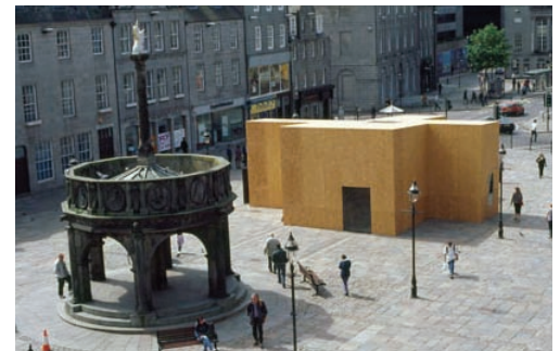
3.19. Monkey Puzzle posiada jedynie cztery otwory drzwiowe. Definiują go pełne przegrody zewnętrzne z płyt OSB.
