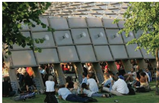
3.75. Obiekt do wysokości 1,35 m jest otwarty na przestrzeń parku umożliwiając zagłądanie do środka.
