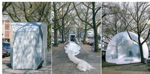
3.13. Montaż i demontaż Küchenmonument trwa zaledwie dwie godziny. I etap: pudełko; II etap: pudełko z rozwiniętą folią; III etap: pudełko z folią wypełnioną powietrzem.
