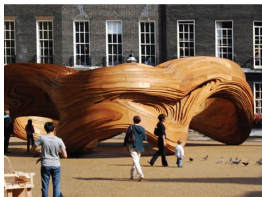
3.45. Forma Driftwood Pavilion zbudowana z dwudziestu-ośmiu warstw drewna, zachęca do dotykania i doświadczania obiektu.
