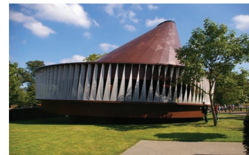
3.69. Forma pawilonu Serpentine Gallery 2007 zdefiniowana jest pełnymi przegrodami wewnętrznymi na planie okręgu. Obiekt jest symetryczny w rzucie i asymetryczny w elewacji.
