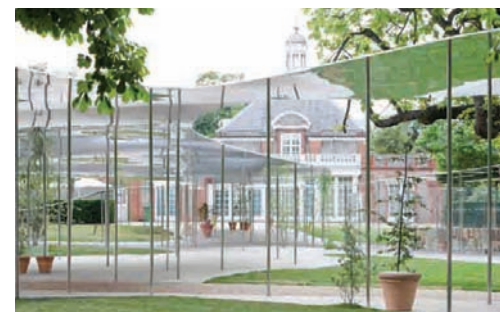
3.70. Płaszczyzna dachu wykonana została z 26 mm aluminium wspartego na 115 słupach ze stali nierdzewnej o przekroju 50 mm.
