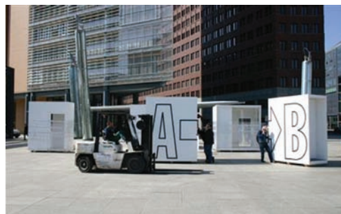
3.16. Mobile Studios. Lekkość użytego materiału i niewielka kubatura każdego elementu (10 m 2 ) umożliwiają łatwość montażu w kolejnych lokalizacjach.
