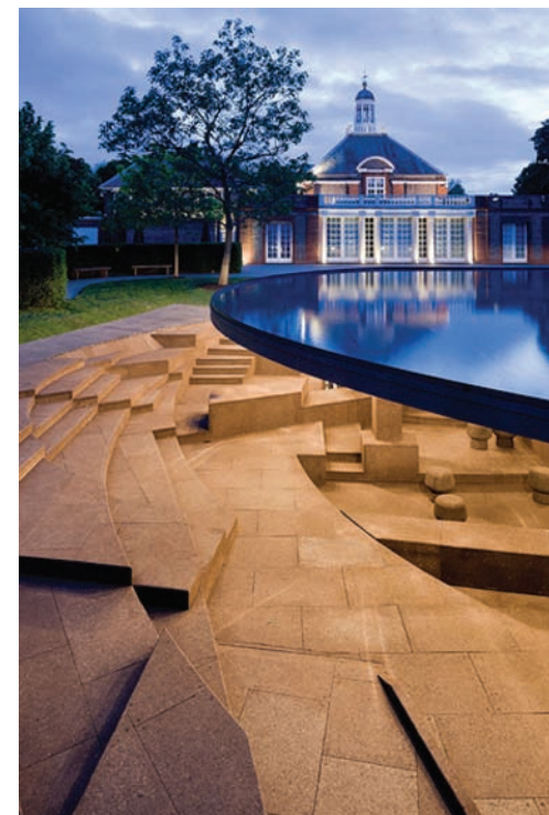
3.77. Zagłębienie formy Serpentine Gallery 2012 w ziemi (5 m) i lokalizacja płaszczyzny dachu na wysokości jedynie 1,5 m, pozwalają na zupełnie nowe - w stosunku do poprzednich realizacji - doświadczanie przestrzeni parku i zabytkowego obiektu galerii.
