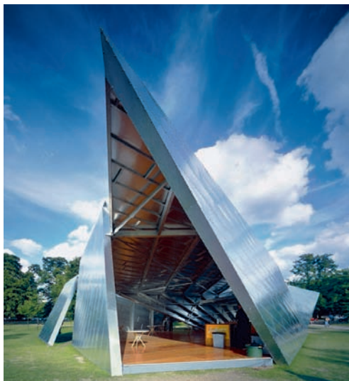
3.66. Forma pawilonu Serpentine Gallery 2001 zainspirowana została japońskimi origami. Śłada się z osiemnastu połączonych ze sobą płaszczyzn, o dynamicznej, „ostrej” geometrii.
