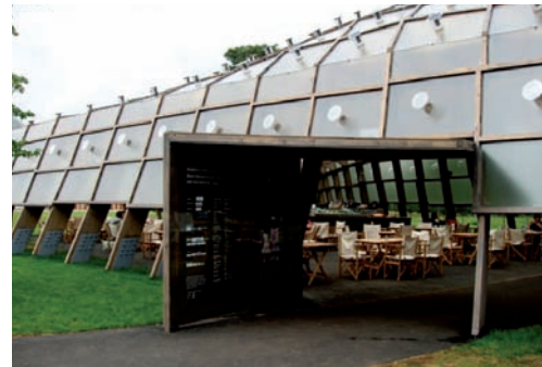
3.76. Na zdjęciu widoczny jeden z otworów drzwiowych, zlokalizowanych na śladzie istniejącej ścieżki.
