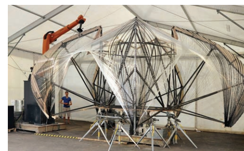
3.10. ICD/ITKE Research Pavilion 2012 w trakcie procesu realizacyjnego, wykorzystującego roboty i najnowocześniejsze technologie.
