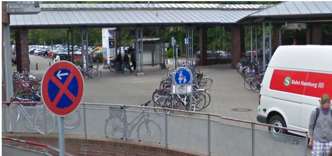
Rys.4.6 Parking rowerowy przy parkingu Park&Ride, w sąsiedztwie przystanku kolejowego Nettelnborg w Hamburgu [103].
