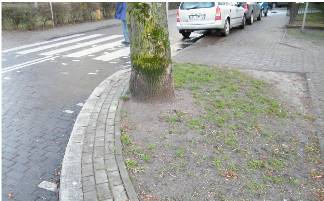
RYC. 43. JESION WYNIOSŁY ( FRAXINUS EXCELSIOR ) NR 129, TRUDNA SYTUACJA PRZESTRZENNA DRZEWA, SYSTEM KORZENIOWY ZOSTAŁ NARUSZONY I PRZYSYPANY PODCZAS PRZEBUDOWY NAWIERZCHNI, 2006, FOT. W. BOBEK
