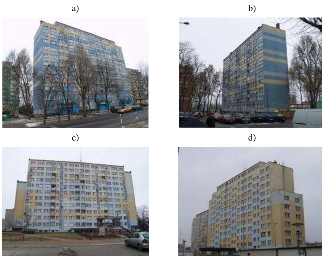
Rys. 4.1. Budynki prefabrykowane systemu WWP: (a, b) bez wzmocnień, (c, d) z dodatkowymi przęsłami (fot. autora)
