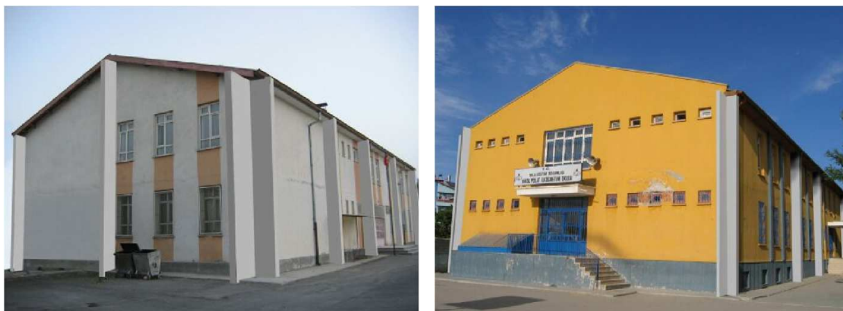
Rys. 1.6. Przykładowe wzmocnienia szkół żelbetowymi tarczami ściennymi [36]
