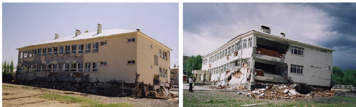
Rys. 1.5. Zniszczenia budynków żelbetowych szkół spowodowane trzęsieniem ziemi w Turcji [36]
