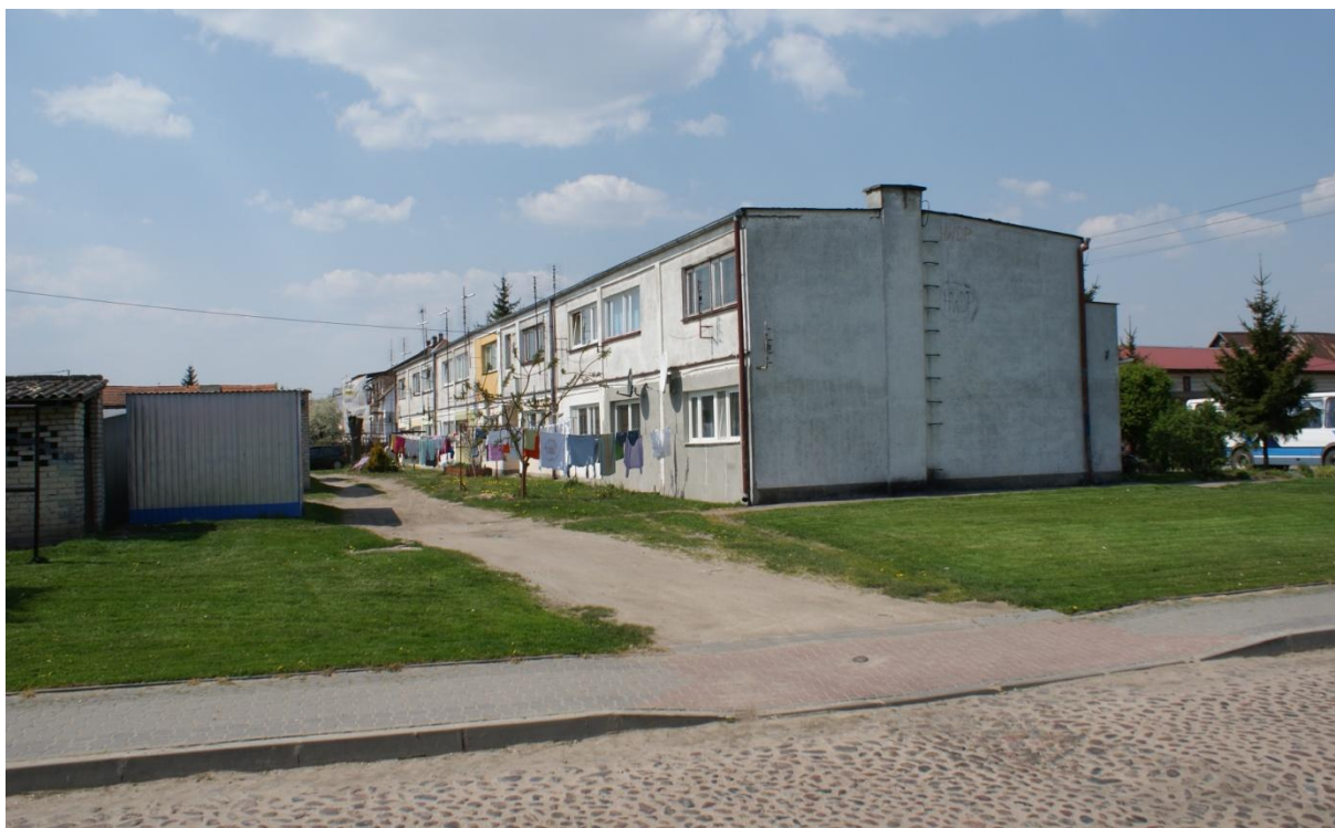
Ilustracja 35. Zabudowa z lat 70. XX w. przy ul. Bernardyńskiej, fot. autor 2009.
