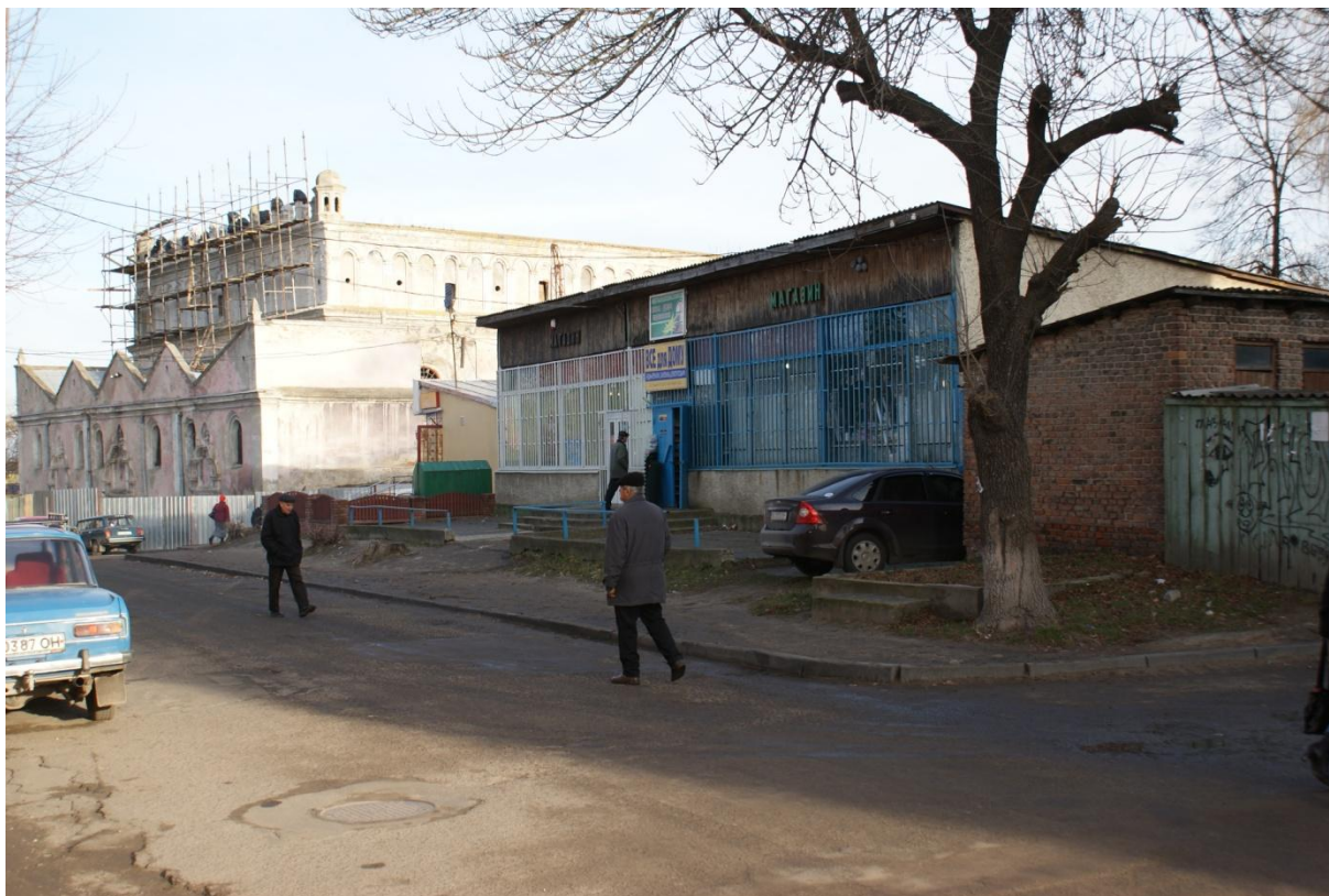
Ilustracja 56. Synagoga z wtórną zabudową w sąsiedztwie, fot. autor 2008.
