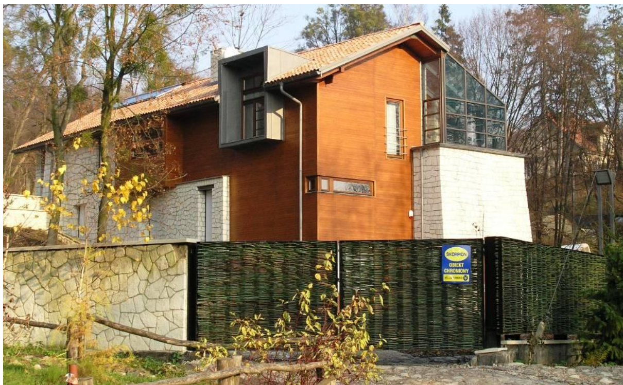
Ilustracja 113. Budynek jednorodzinny przy u. Szkolnej wzniesiony wg proj. S. Kuryłowicza na pocz. XXI wieku, fot. autor, 2008.
