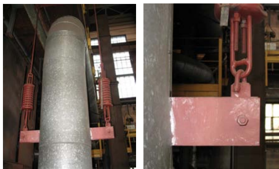
Rys. 6.1. Zawieszenie pionowo usytuowanego rurociągu parowego \phi 193,7 \times 20 mm (widok ogólny i przybliżenie fragmentu półobejmy wystających ponad izolację rurociągu)
