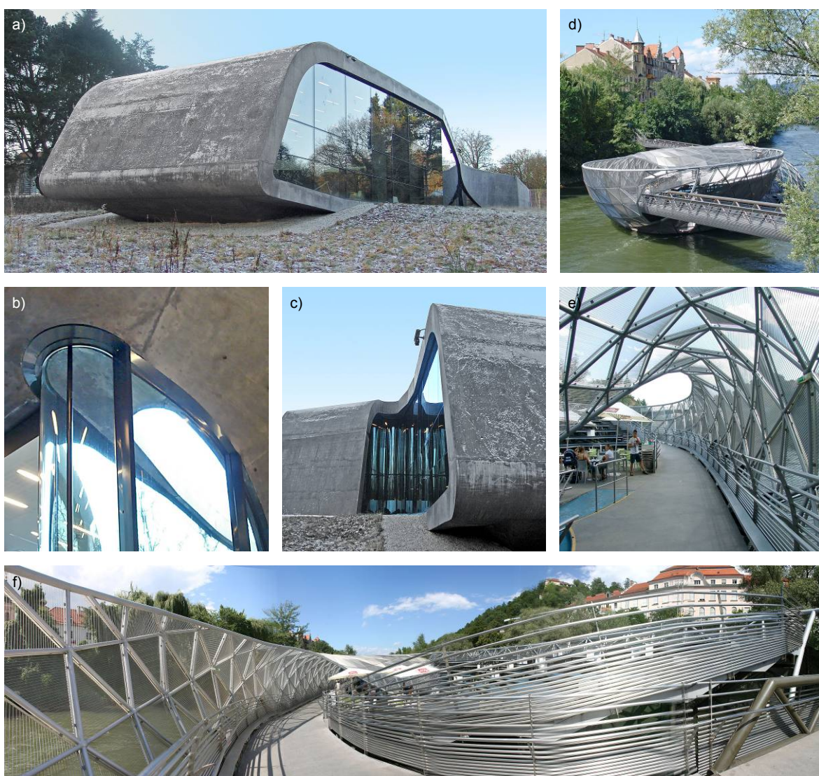
Ryc. 20. Łączenie przestrzeni i zacieranie granic formalnych w wybranych współczesnych realizacjach architektonicznych: a) Rozbudowa Muzeum Ordrupgaard w Kopenhadze, proj. Zaha Hadid, 2001-2005 – charakterystyczny widok bryły; b) – zawinięcie przestrzeni zewnętrznej do wnętrza obiektu; c) – widok tej fałdy od zewnątrz; d) Wyspa na rzece Mur (Murinsel) w Grazu (Austria), proj. Vito Acconci, 2003 – widok ogólny założenia; e) – widok z centralnej części obiektu, przy małym amfiteatrze; f) – spiralne zawinięcie formy w widoku panoramicznym z kładki pieszej. Źródło: fot. autora (2006:Graz, 2008:Kopenhaga)
