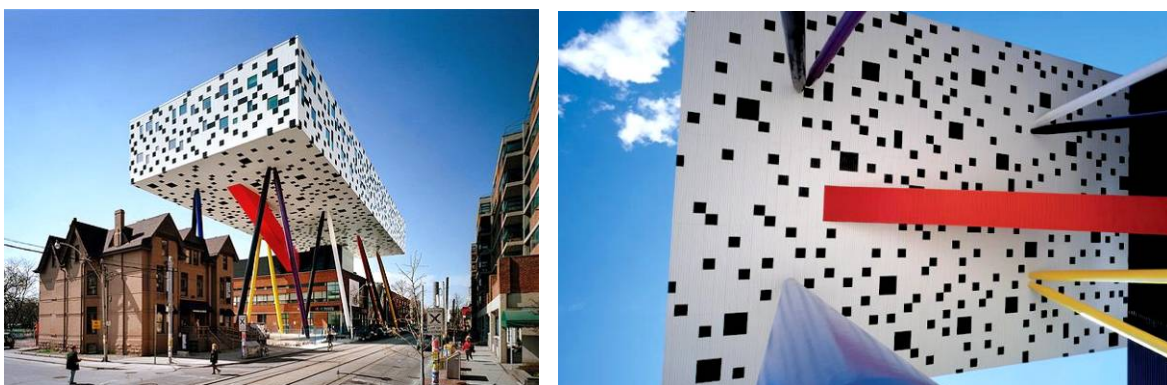
Ryc. 28. Budynek Wyższej Szkoły Sztuki i Projektowania w Toronto jako przykład formy rozproszonej statycznej; (Ontario College of Art & Design: OCAD – Sharp Centre for Design), proj. SMC Alsop Architects (arch. William Alsop), 2004. Rozproszenie uwidacznia się tu w sposobie zaprojektowania powierzchni obiektu. Charakterystyczny wzór uzyskany jest poprzez zastosowanie czarnych i białych paneli z blachy falistej oraz losowe rozmieszczenie otworów okiennych. Źródło: Alsop Architects (fot. Johnson, Arban)
