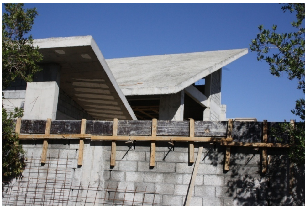
fot. 43. Budowa domu P. Nayefa. Technologia.
