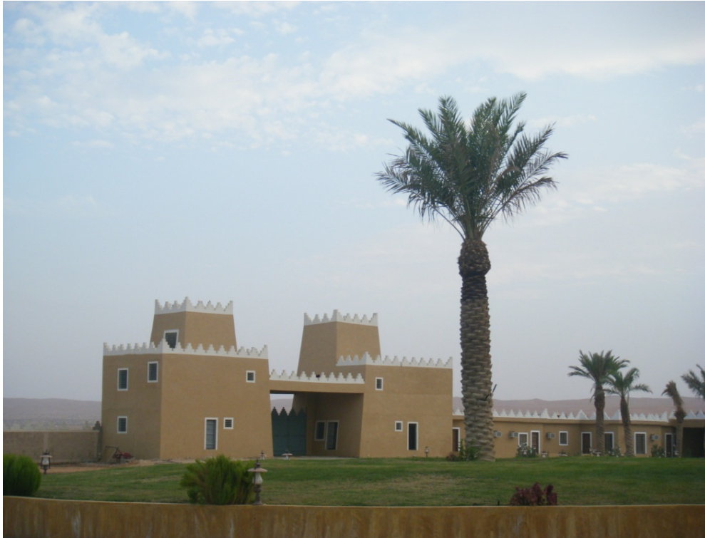
fot. 137. Rewiwalizm – podmiejska rezydencja na pustyni. Brama wjazdowa, dziedziniec.
