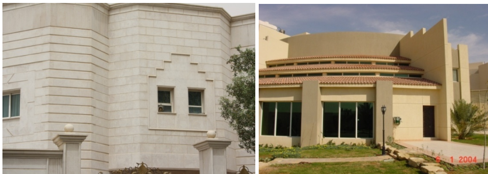
fot. 92, fot. 93. Detal, formy eklektyczne i modernistyczne.
