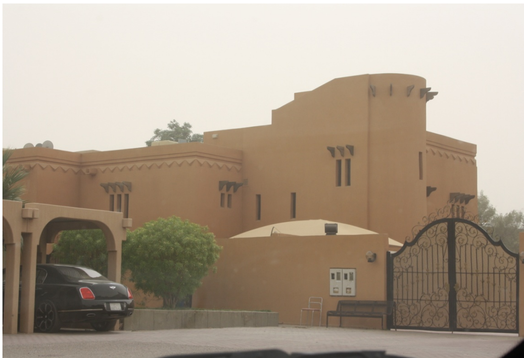
fot. 126. Regionalizm krytyczny, początek lat 90-tych XX wieku.
