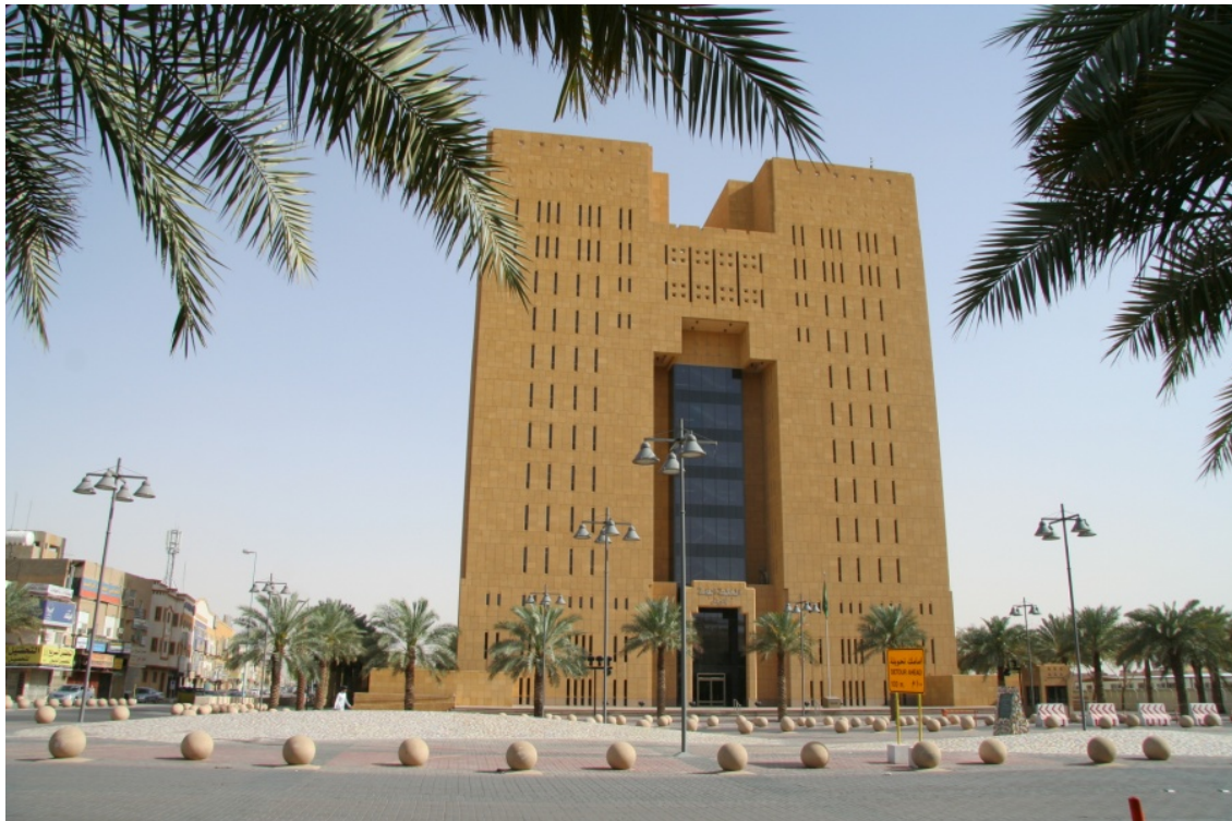
fot. 108. Budynek Ministerstwa Sprawiedliwości, Diriyah.
