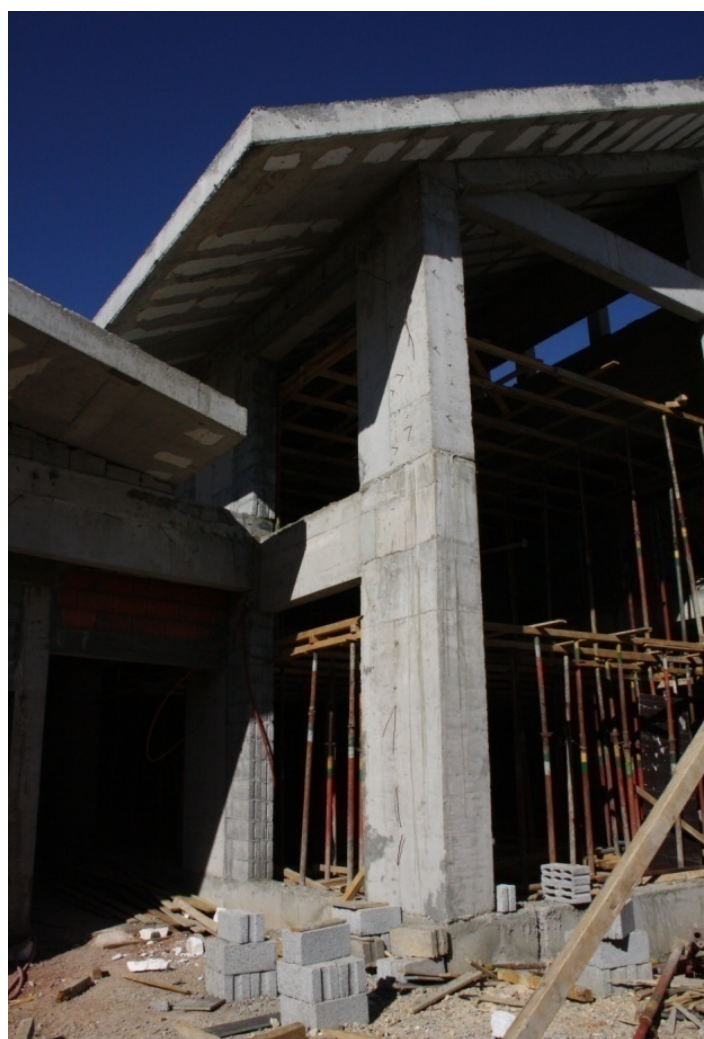
fot. 45. Technologia budowy domu jednorodzinnego, budowa domu P.Nayefa.
