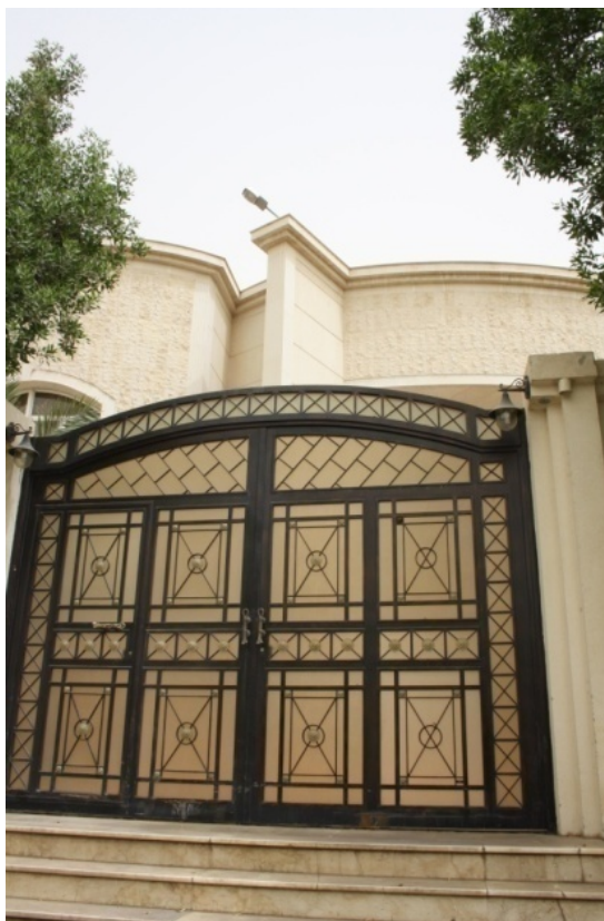
fot. 94. Wejście na teren posesji. Detal, ogrodzenia, bramy.
