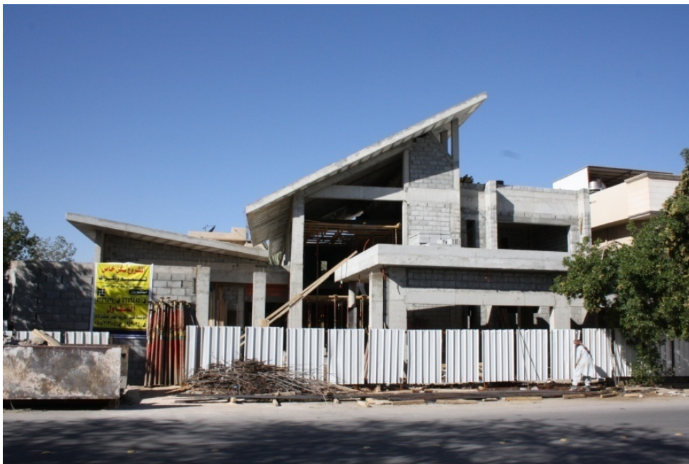
fot. 42. Budowa domu P. Nayefa. Technologia.
