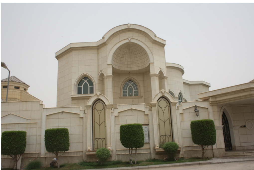
fot. 119. Formy zwieńczeń attykowych domów eklektycznych.
