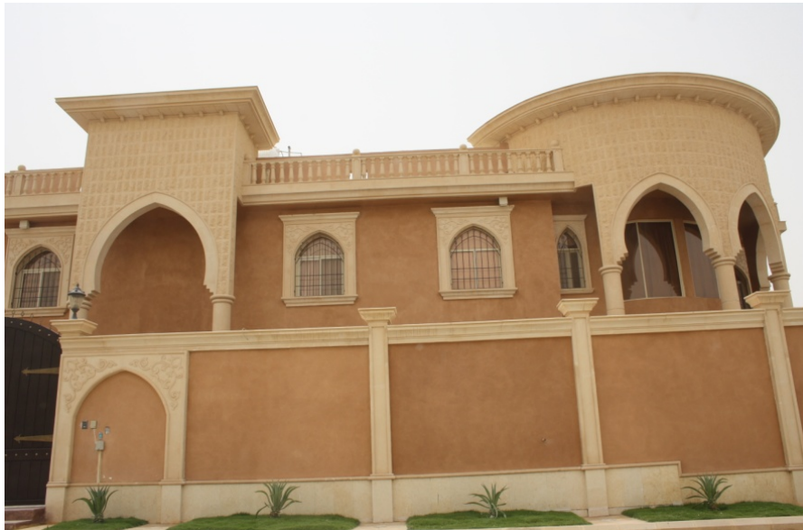
fot. 116. Formy zwieńczeń attykowych domów eklektycznych.
