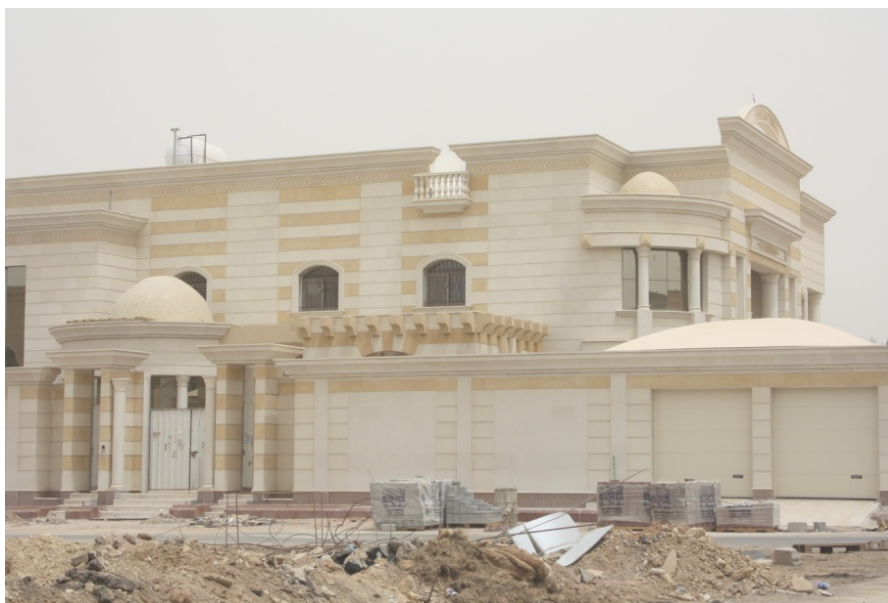
fot. 117. Formy zwieńczeń attykowych domów eklektycznych.
