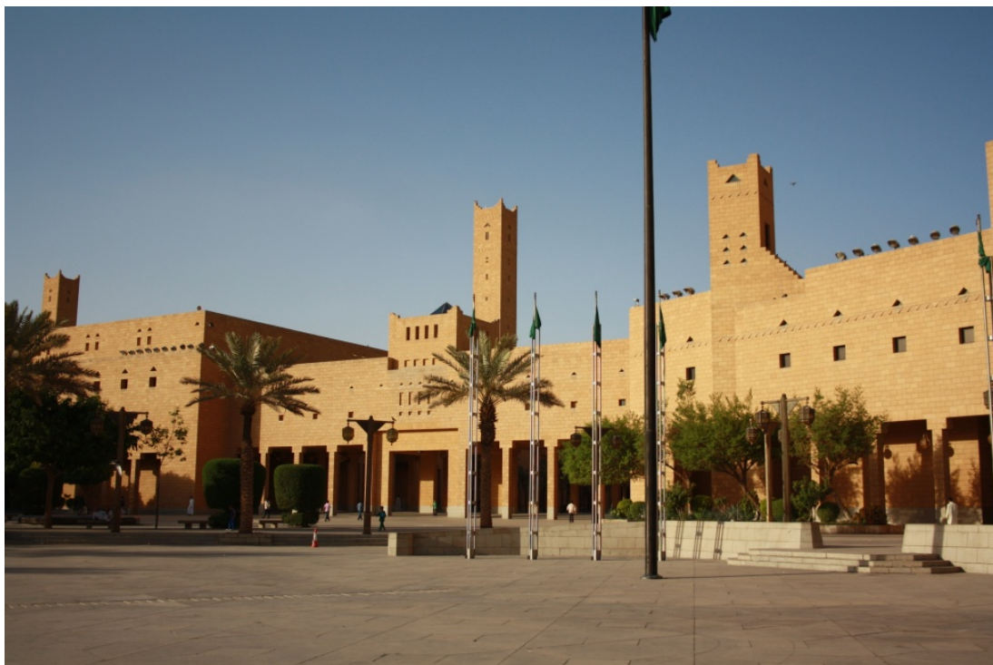
fot. 123. Przykład regionalizmu krytycznego w budynkach użyteczności publicznej. Wielki meczet w Diriyah.
