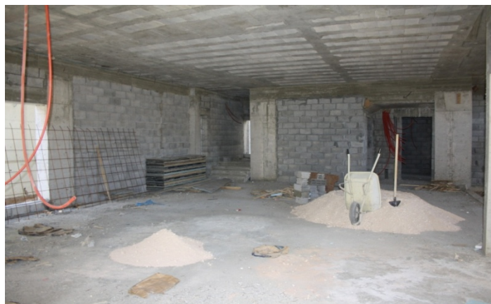
fot. 44. Technologia budowy domu jednorodzinnego, budowa domu P.Nayefa.
