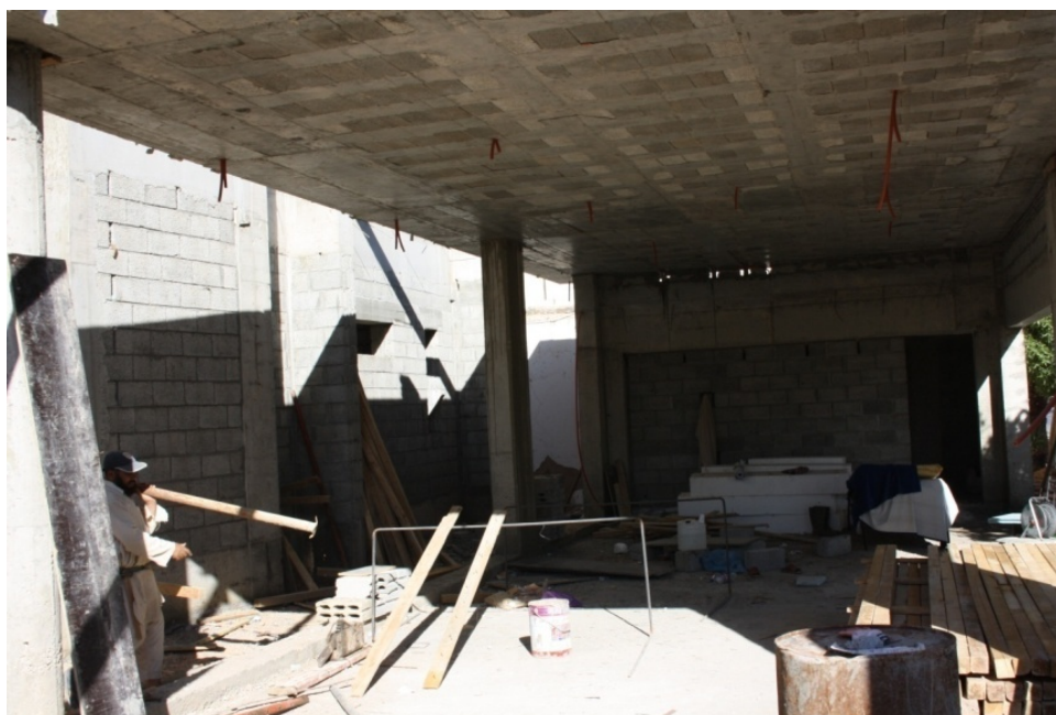
fot. 41. Budowa domu P. Nayefa. Technologia.
