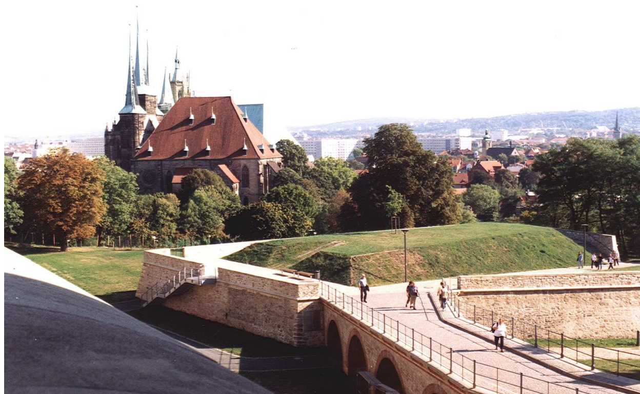
Ilustracja 69. Widok z bastionu Leonhard poprzez rawelin Peter w kierunku wzgórza katedralnego i kościoła św. Sewera w Erfurcie, fot. A. Skrzyńska, 2003
