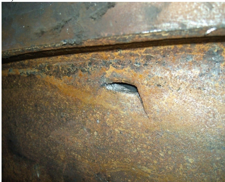
Rys.5.2.9a-c. Zdjęcia uszkodzeń bieżni kół jezdnych suwnicowych
