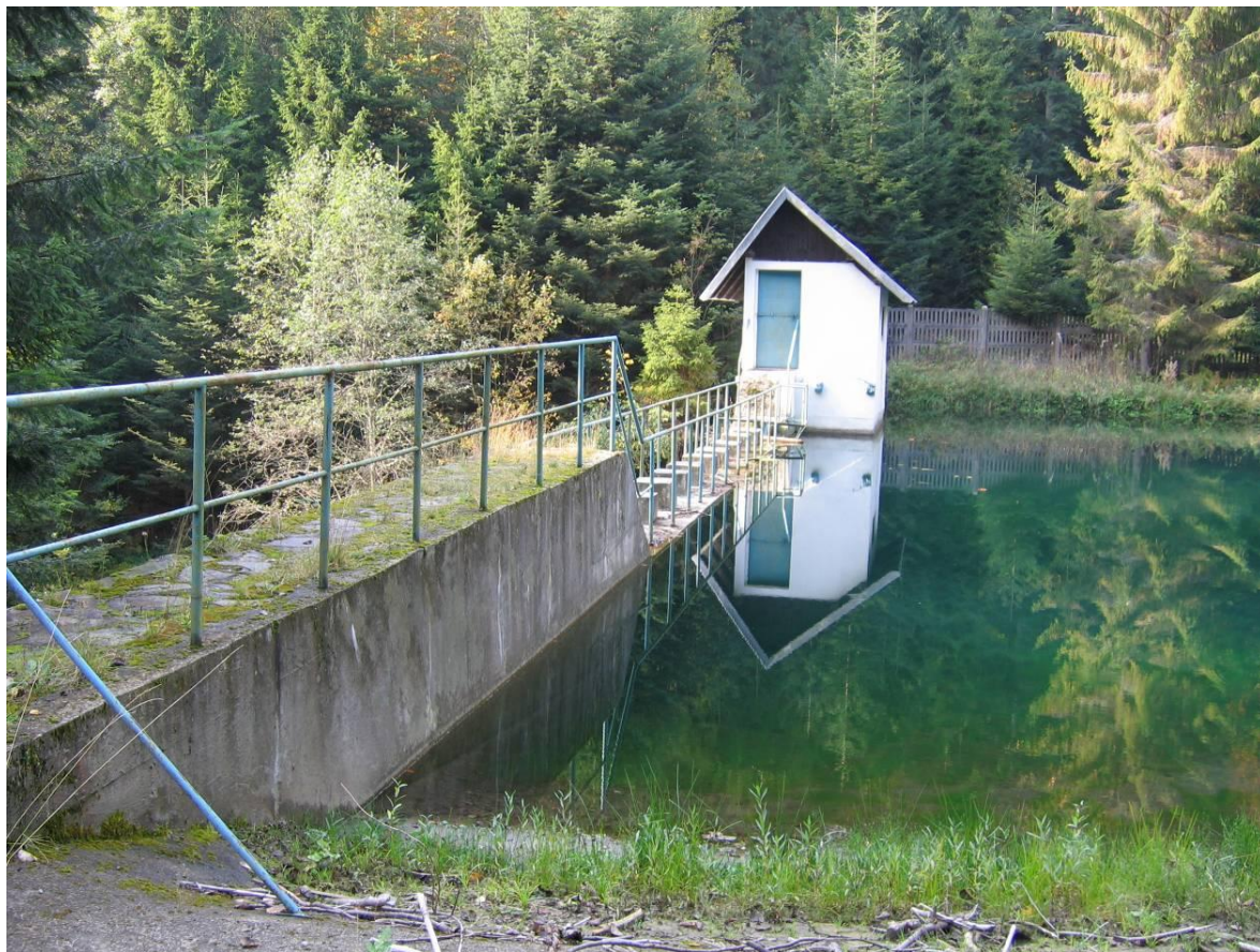
Rys. 12.36. Ujęcie wody „Pokrzywy” z potoku Sopotnickiego dla miasta Szczawnica
