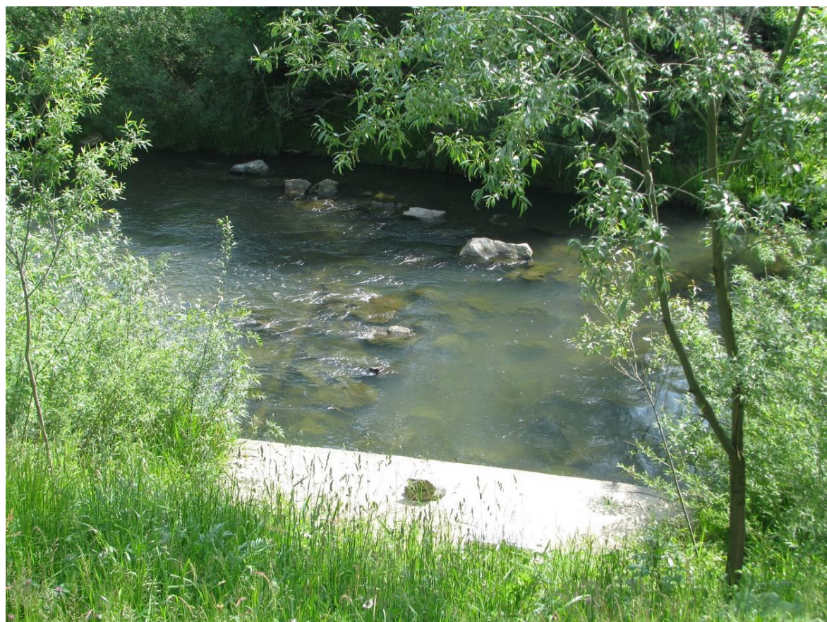
Rys. 12.31. Ujęcie wody z rzeki Stradomki dla gminy Łapanów
