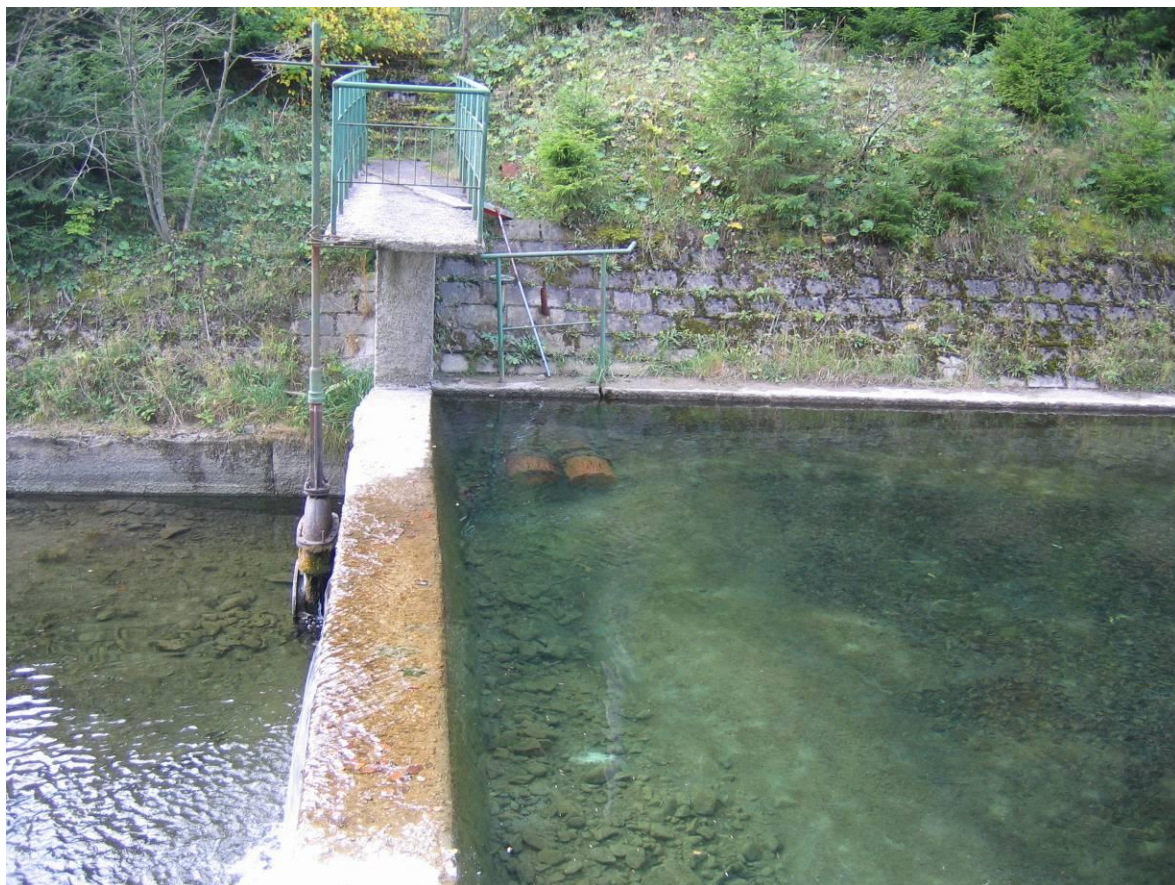
Rys. 12.37. Ujęcie wody „Sewerynówka” z potoku Sopotnickiego dla miasta Szczawnica
