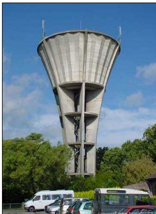
Ryc. 5.2. Zbiornik wieżowy w Belgii
