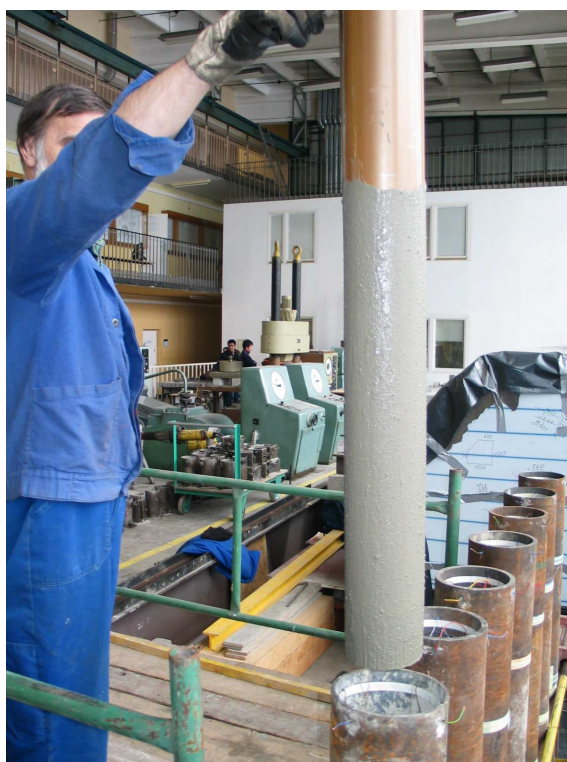
Rys. Z2.3. Wypełnianie rur mieszanką betonową.
