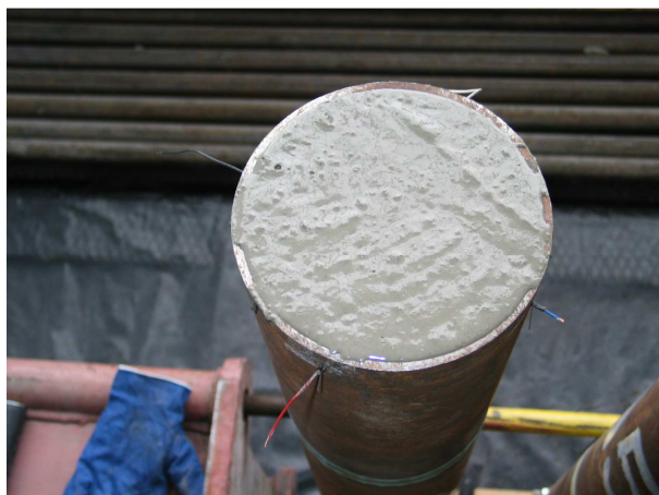
Z2.5. Rura wypełniona świeżym betonem.
