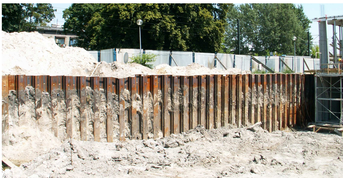
Rys. 93 Rejon przekrojów pomiarowych – końcowy etap wykonywania wykopu.
