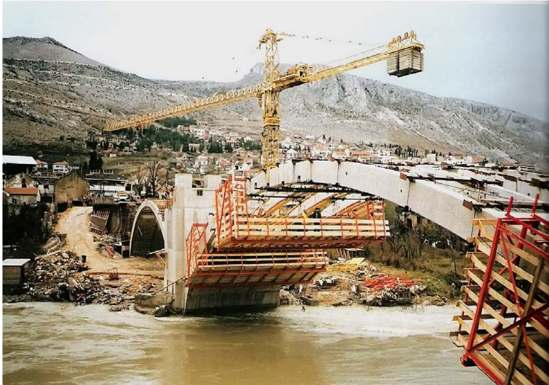
Rys. 5.5. Przykład realizacji przesuwnych rusztowań (Most Carinski, Mostar, Bośnia i Hercegowina)
