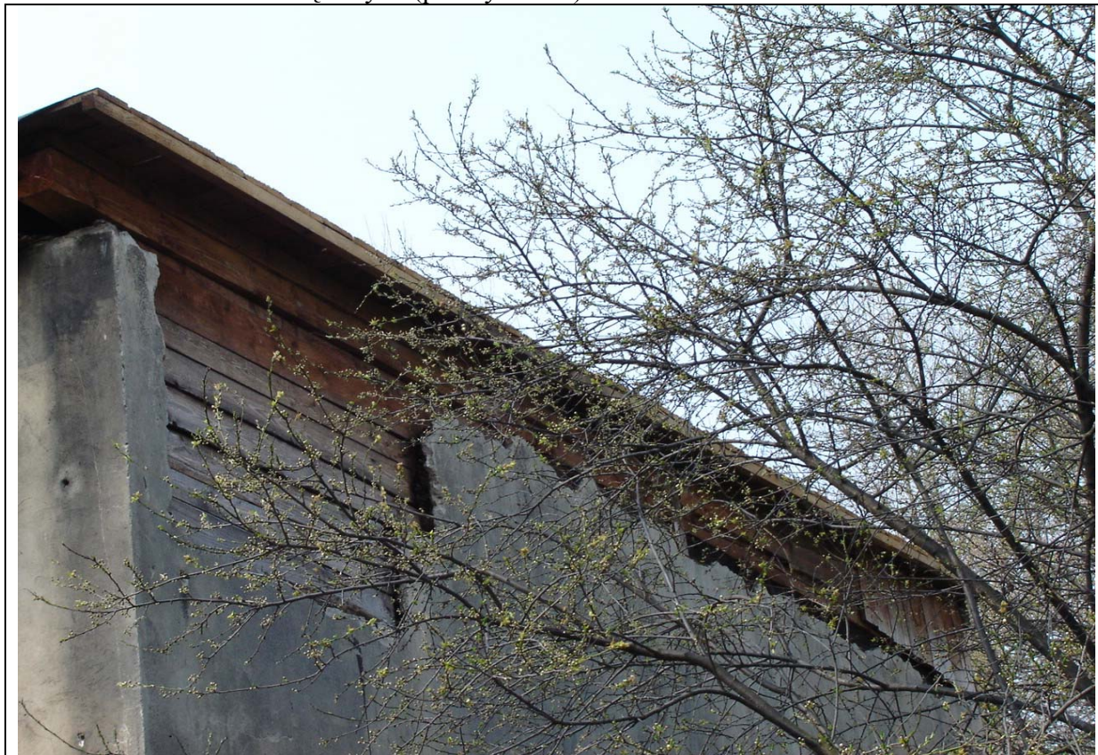
Fot. 5.14. Widok ściany zewnętrznej budynku typu A.
