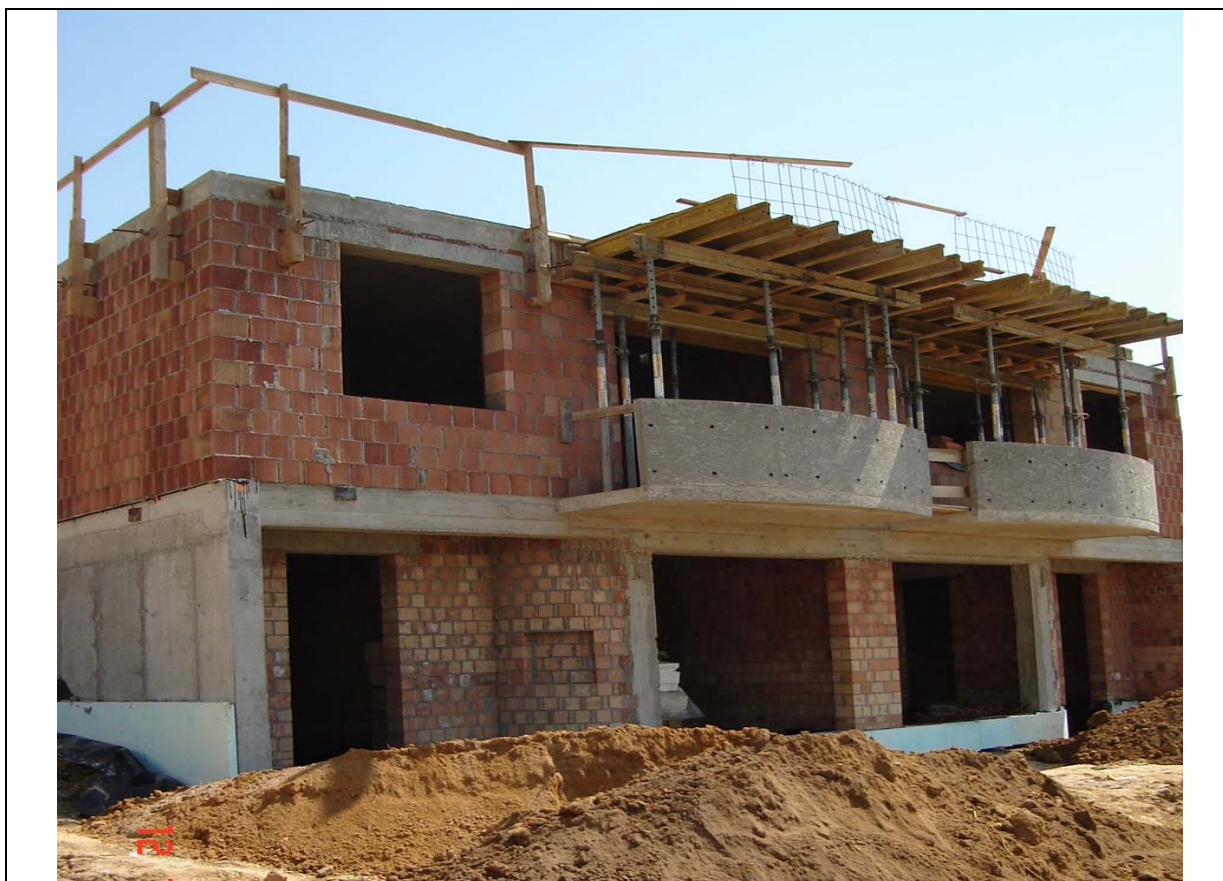
Rys. 7.5. Widok budynku C1 podczas pierwszego etapu pomiarów.
