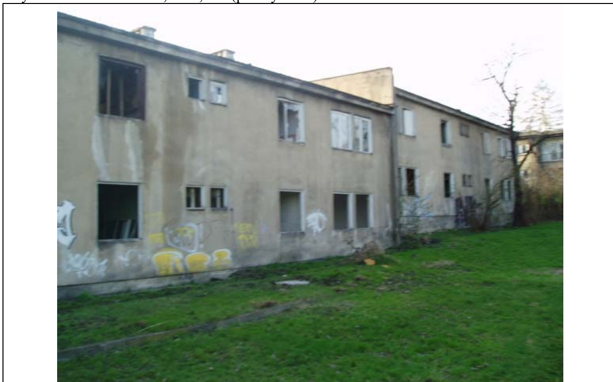
Rys. 5.2. Widok budynków typu A- elewacja wschodnia
