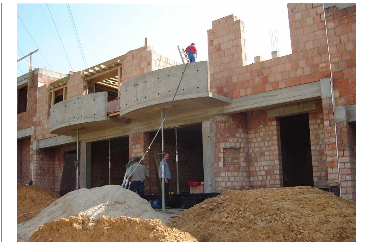
Rys.7.6. Widok budynku C2 podczas pierwszego etapu pomiarów.
