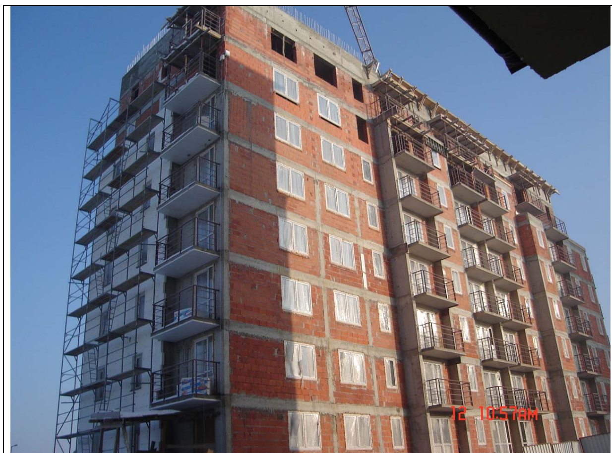
Rys. 6.1. Widok budynku B1.
