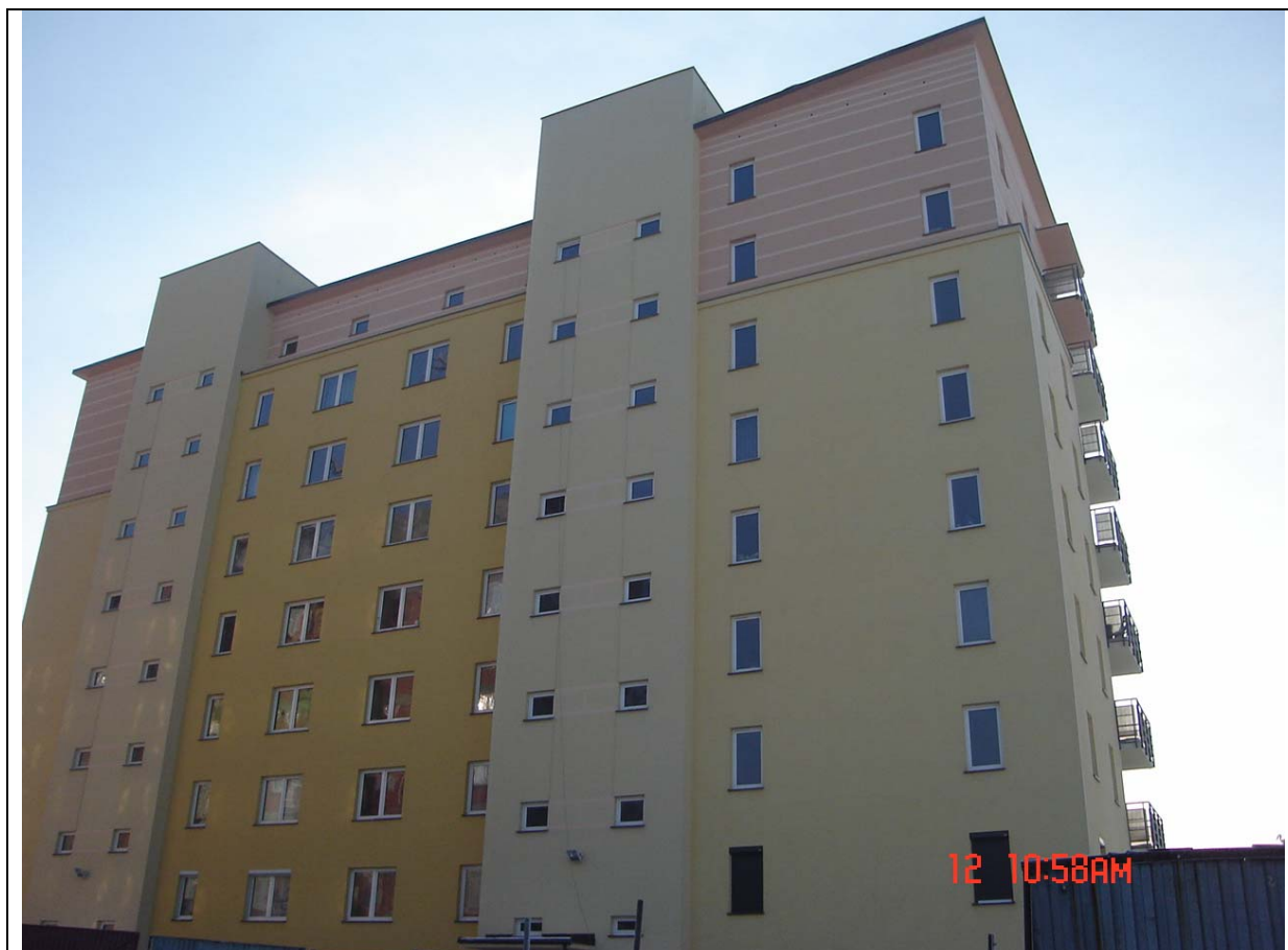
Rys. 6.2. Widok budynku B2.
