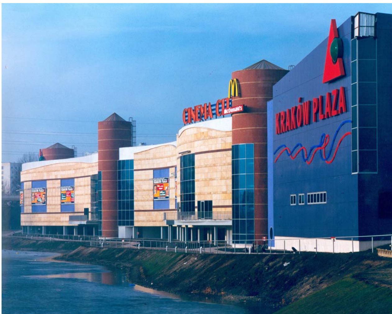
Ilustracja 27: Centrum handlowe Plaza Kraków Widok elewacji południowej Autorzy: Marek Borkowski, Witold Gilewicz, Andrzej Lipski
