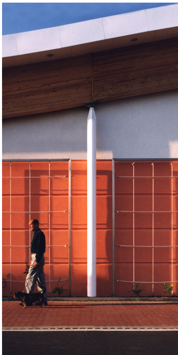
Ilustracja 66: Hipermarket Auchan w Sosnowcu Fragment elewacji południowej Autorzy: Stanisław Deńko, Robert Kuzianik Koordynacja projektu: Marek Kamiński
