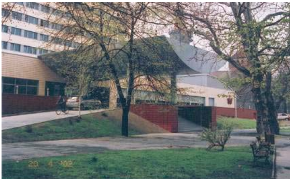
Ilustracja 58: Modernizacja Hotelu CUPRUM w Legnicy Zadaszenie wejścia po przebudowie Autor: Zbigniew Paszkowski
