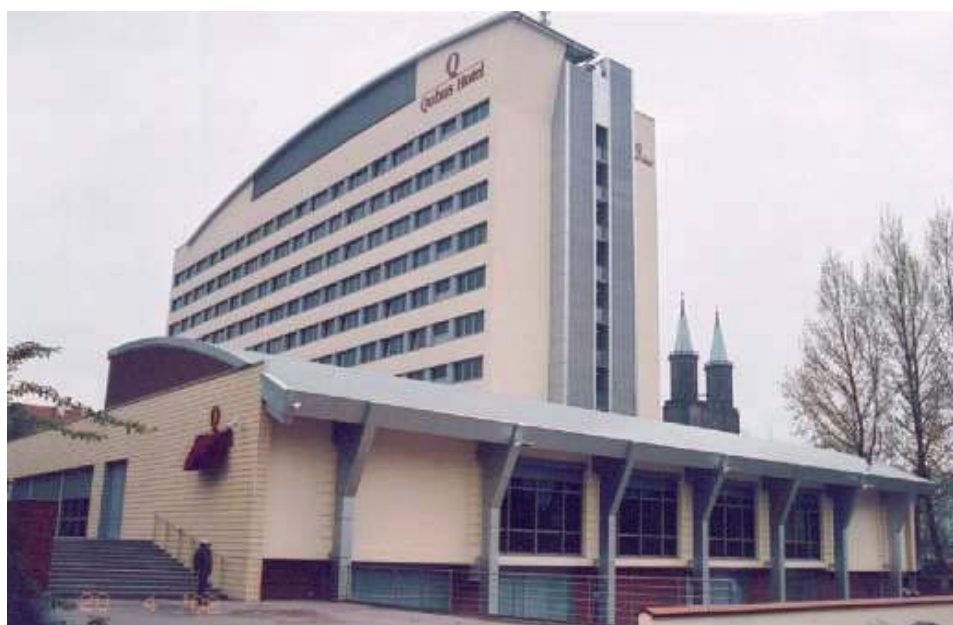
Ilustracja 57: Modernizacja Hotelu CUPRUM w Legnicy Widok elewacji po przebudowie Autor: Zbigniew Paszkowski, współpraca autorska: Barbara Paszkowska, Grzegorz Drażewski, Janusz Nierzwicki
