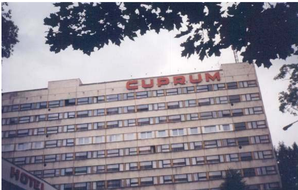
Ilustracja 54: Modernizacja Hotelu CUPRUM w Legnicy Widok elewacji przed modernizacją Autor: Zbigniew Paszkowski, współpraca autorska: Barbara Paszkowska, Grzegorz Drażewski, Janusz Nierzwicki
