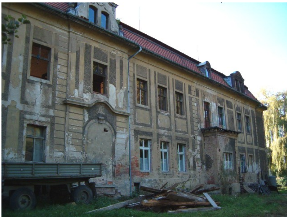
Fot. 48. Elewacja wschodnia (ogrodowa).
