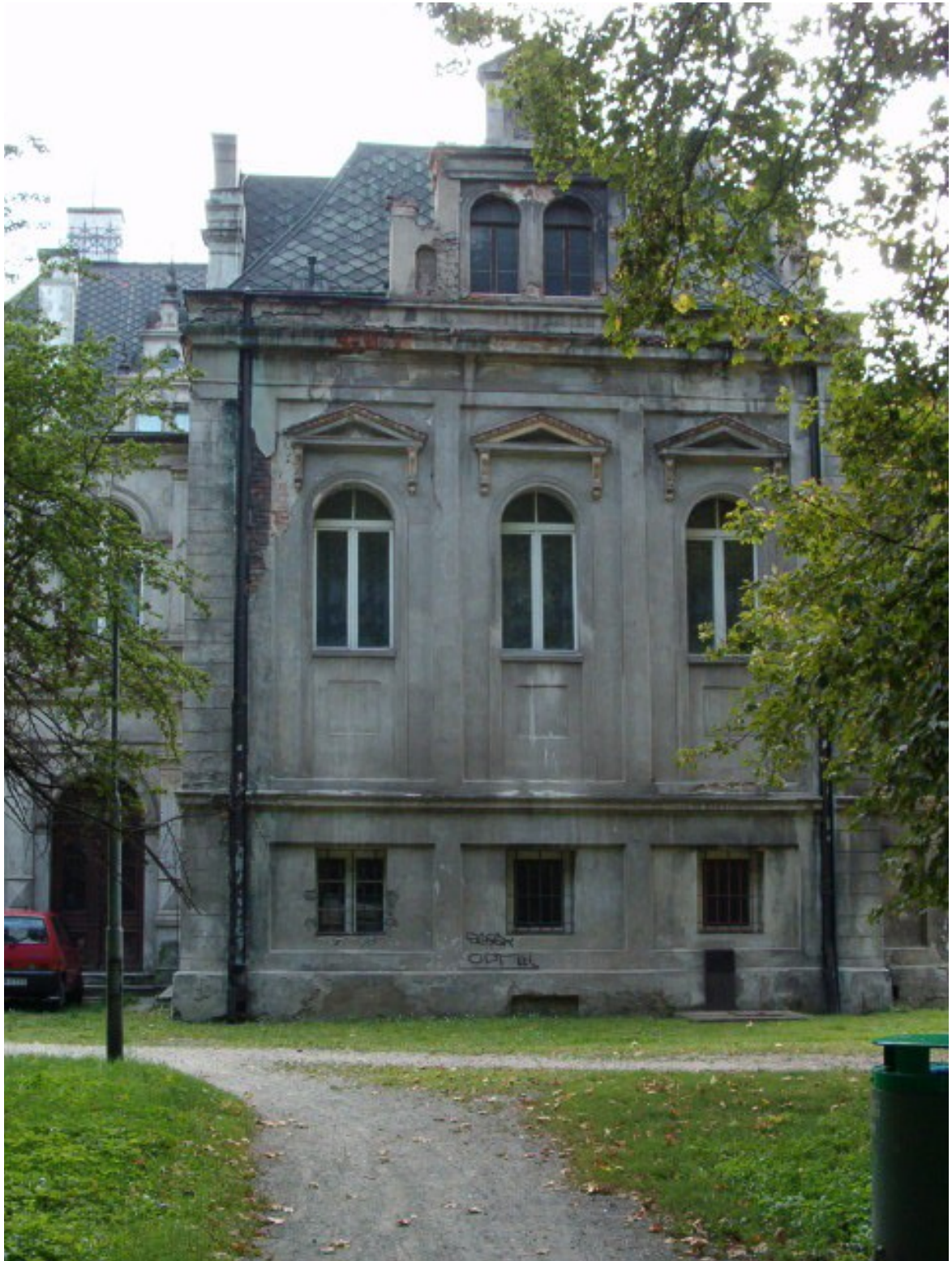
Fot. 117. Elewacja północna skrzydła północno-zachodniego.
