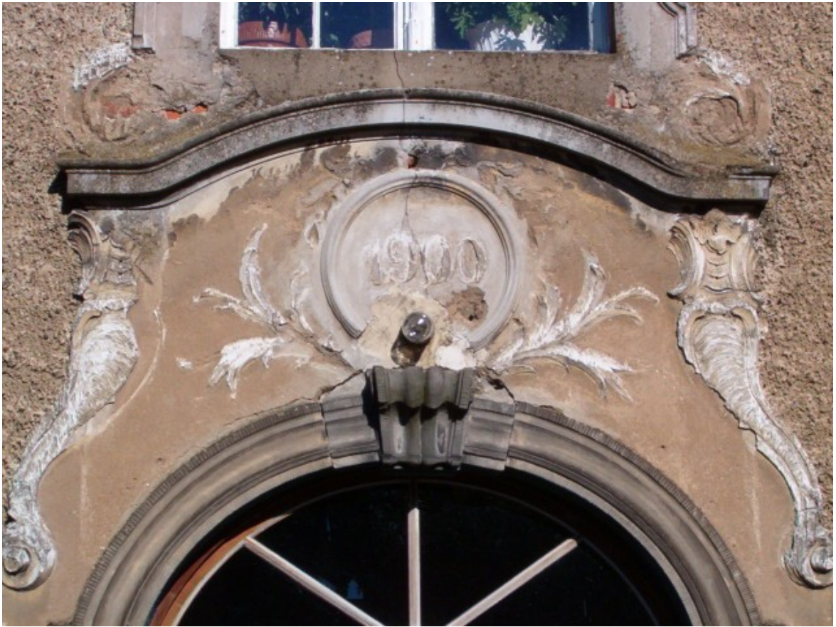
Fot. 45. Detal dekoracji portalu bocznego elewacji zachodniej skrzydła północnego.
