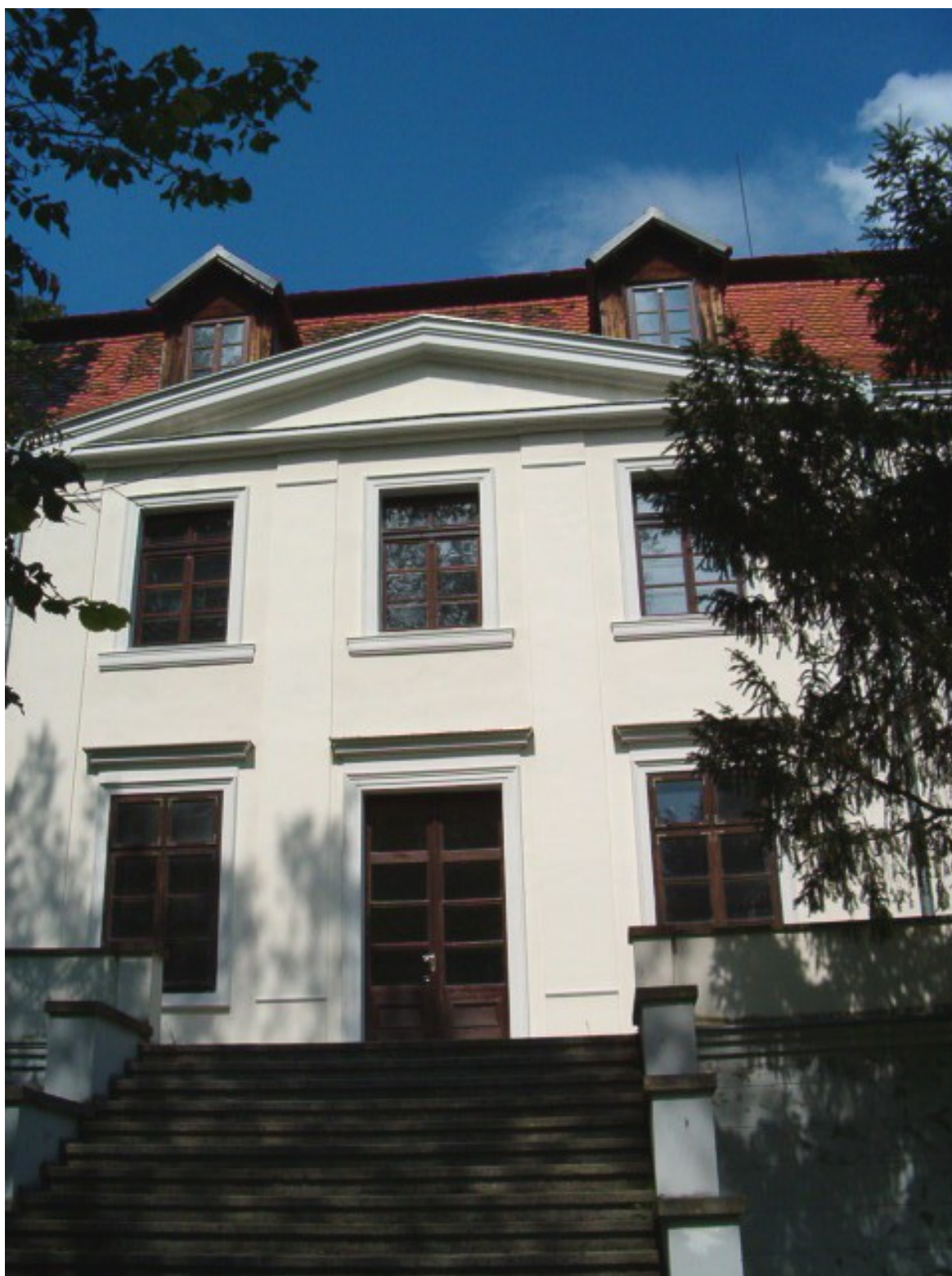
Fot. 139. Środkowy ryzalit elewacji południowo-zachodniej (ogrodowej).
