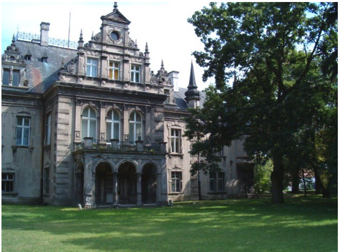
Fot. 112. Środkowy ryzalit z arkadowym portykiem elewacji zachodniej (ogrodowej).
