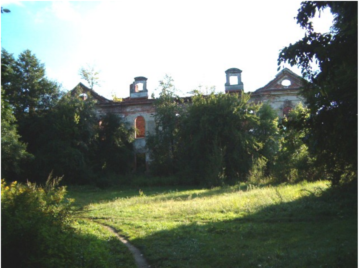
Fot. 89. Elewacja ogrodowa pałacu (korpus główny). Widok z terenu dawnego ogrodu barokowego.
