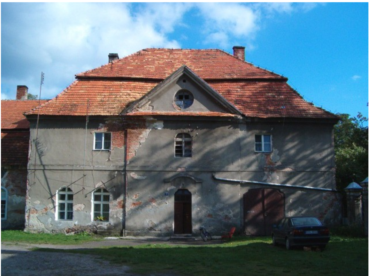
Fot. 81. Oficyna 4 skrzydła południowego.
