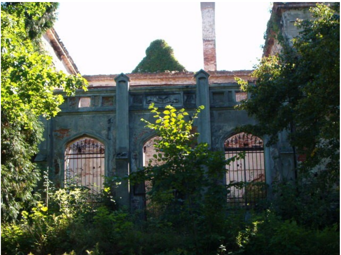
Fot. 14. Elewacja północna (neogotycka elewacja sali balowej).
