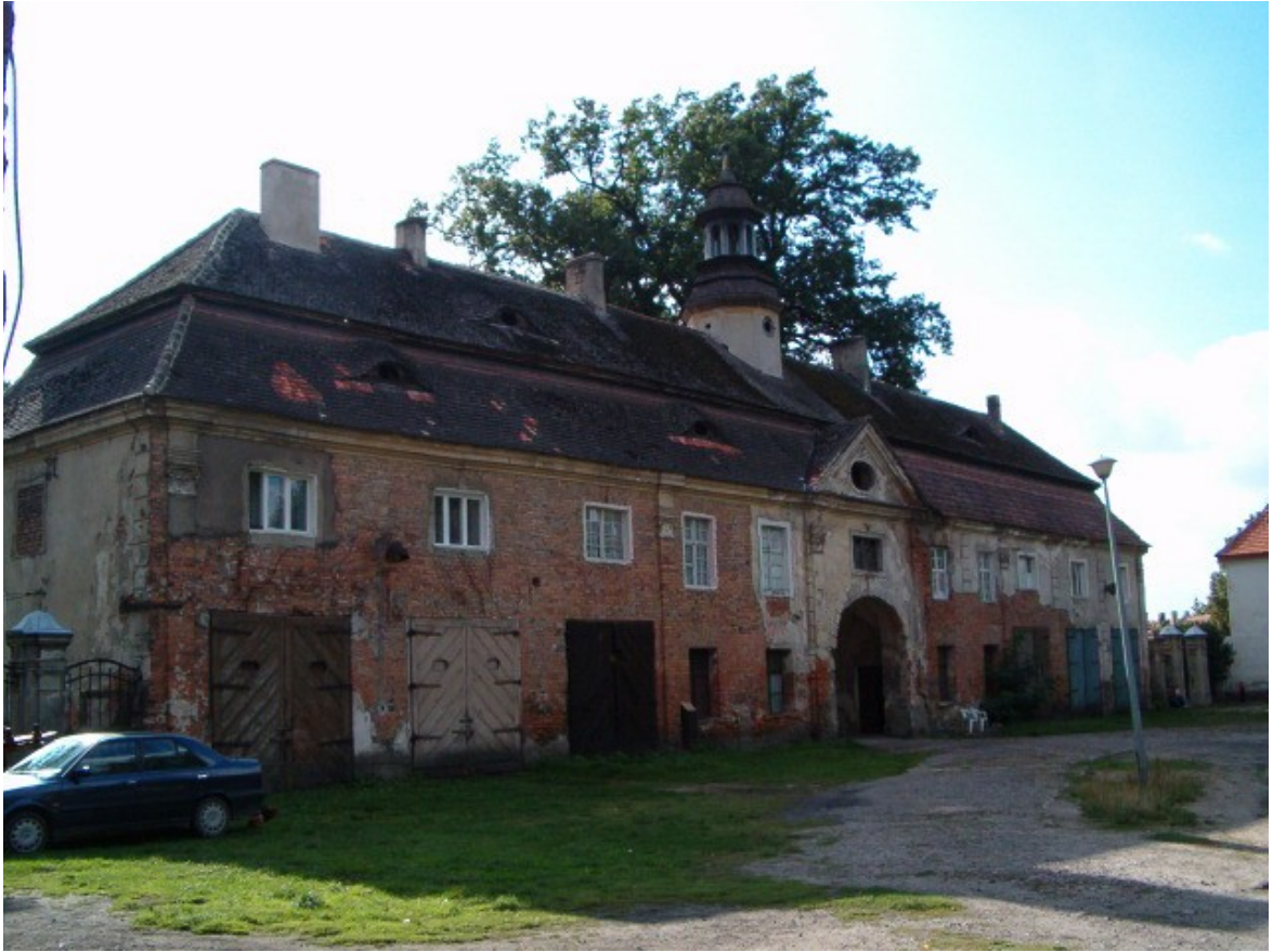
Fot. 84. Budynek bramny (wozownia) z głównym wjazdem na dziedziniec pałacowy.
