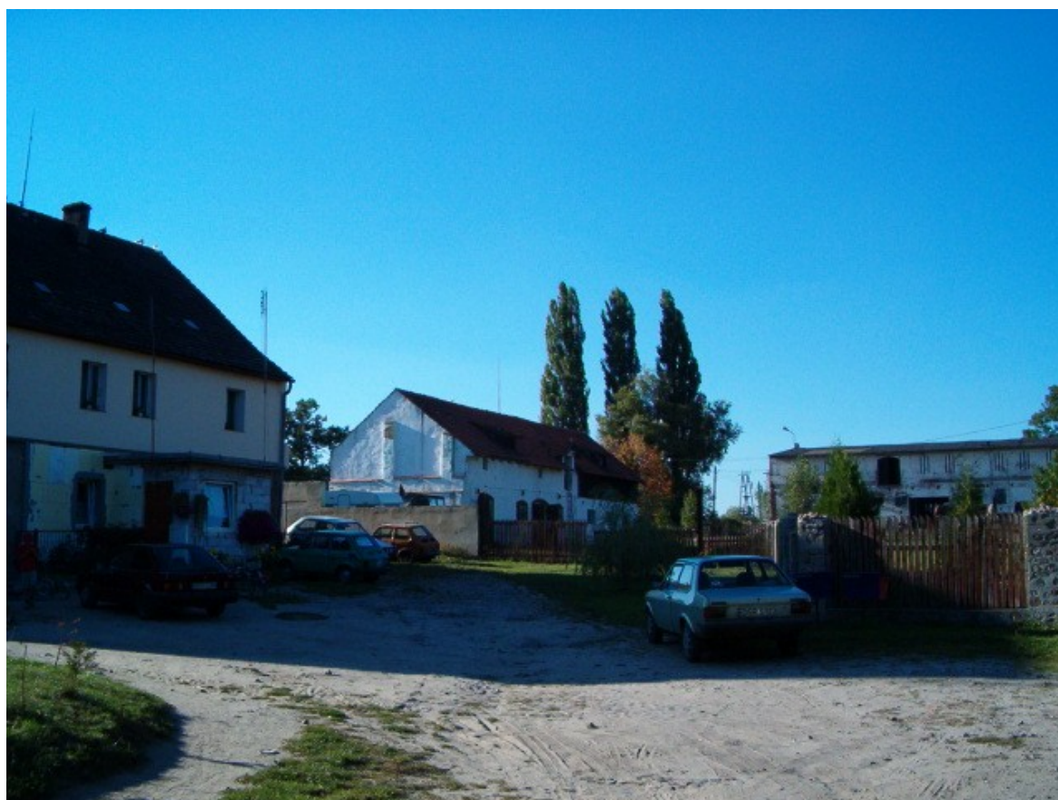
Fot. 56. Zabudowa folwarczna. Widok od strony wjazdu.
