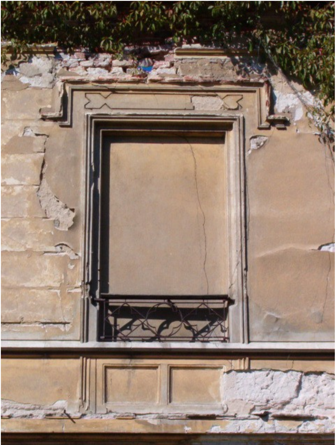
Fot. 23. Detal dekoracji okiennej w południowej elewacji korpusu głównego (blenda w II osi od lewej).
