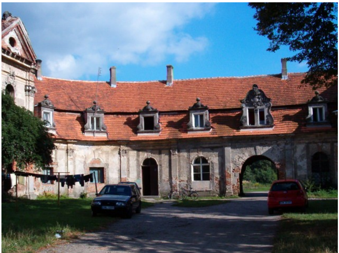
Fot. 74. Oficyna 1 skrzydła południowego.
