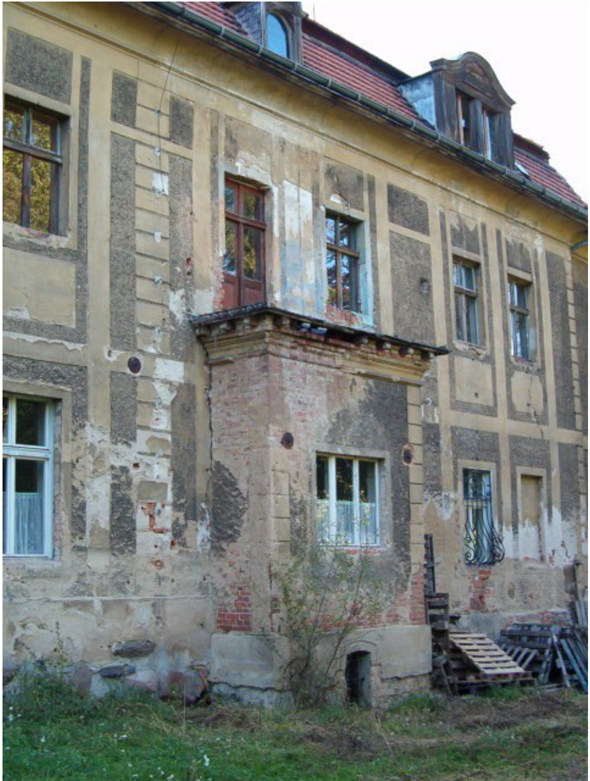
Fot. 49. Aneks z balkonem w północnej części elewacji wschodniej (ogrodowej).
