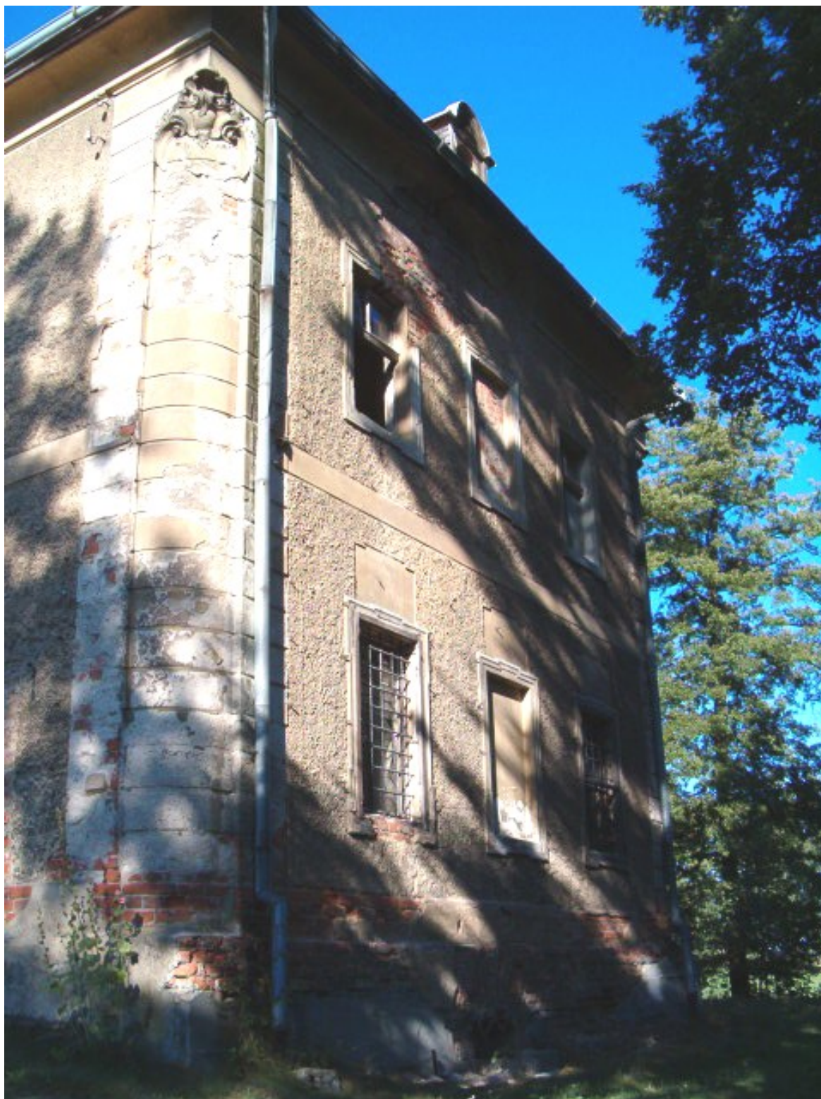
Fot. 51. Elewacja południowa skrzydła wschodniego.
