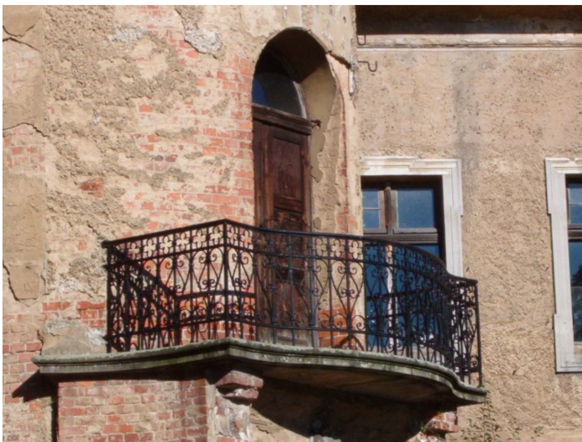
Fot. 42. Balkon nad wejściem głównym.
