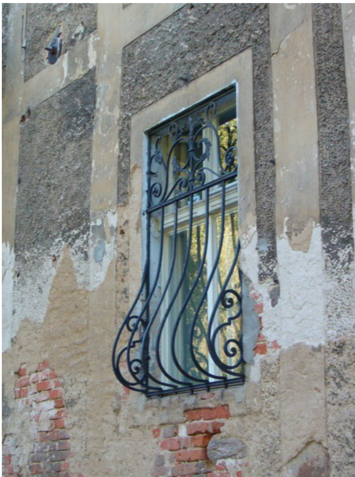
Fot. 50. Jedno z okien elewacji wschodniej (oś II od prawej).
