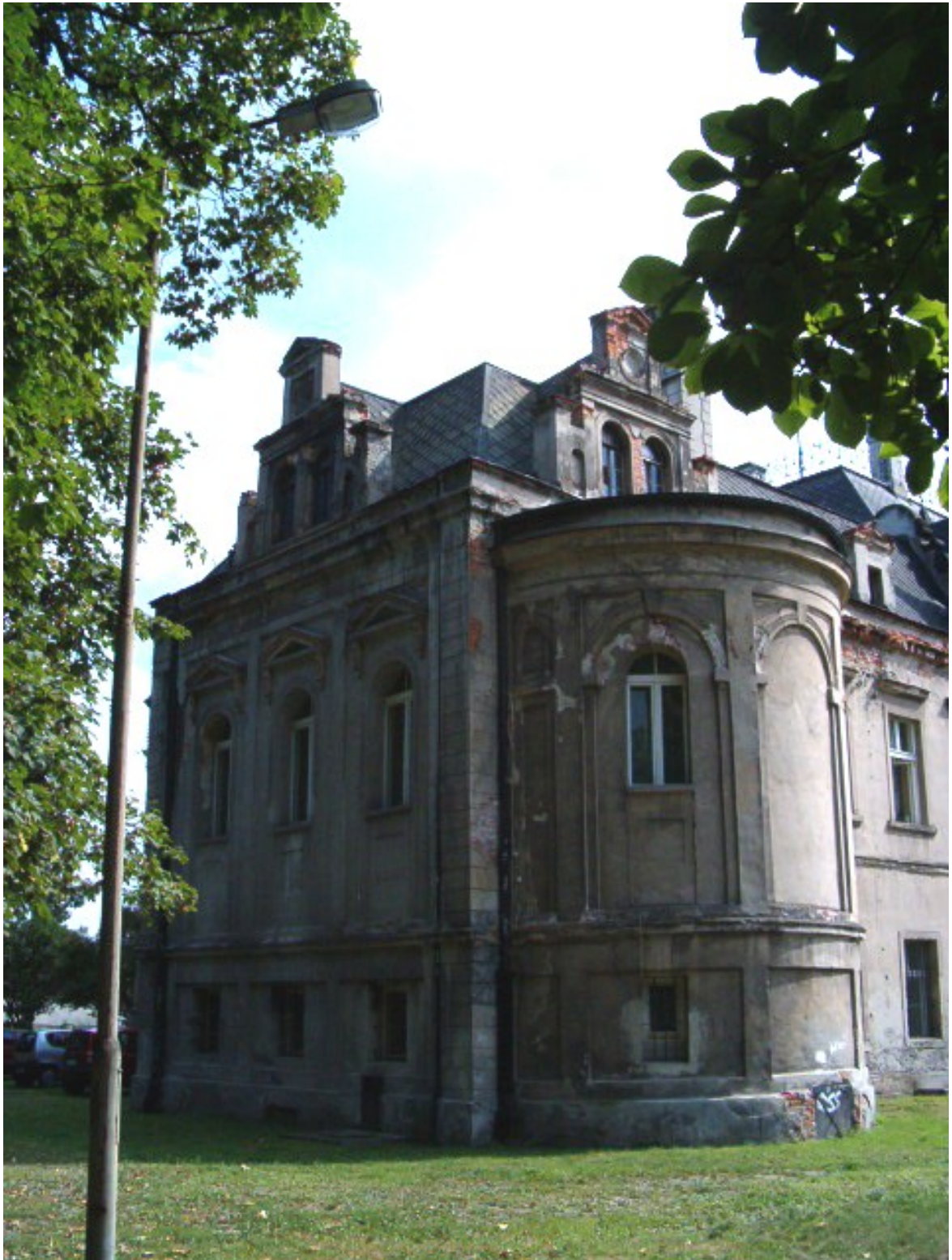
Fot. 116. Północno-zachodnie skrzydło pałacu.
