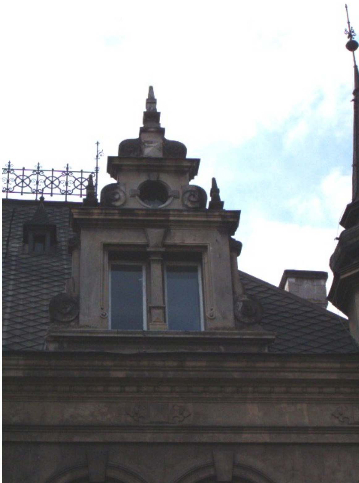
Fot. 110. Dwuosiowa facjata elewacji frontowej.
