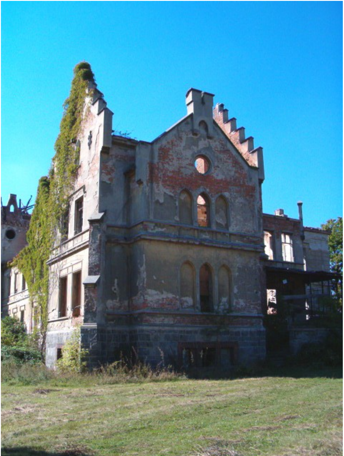
Fot. 19. Elewacja wschodnia południowo-wschodniej wieży.
