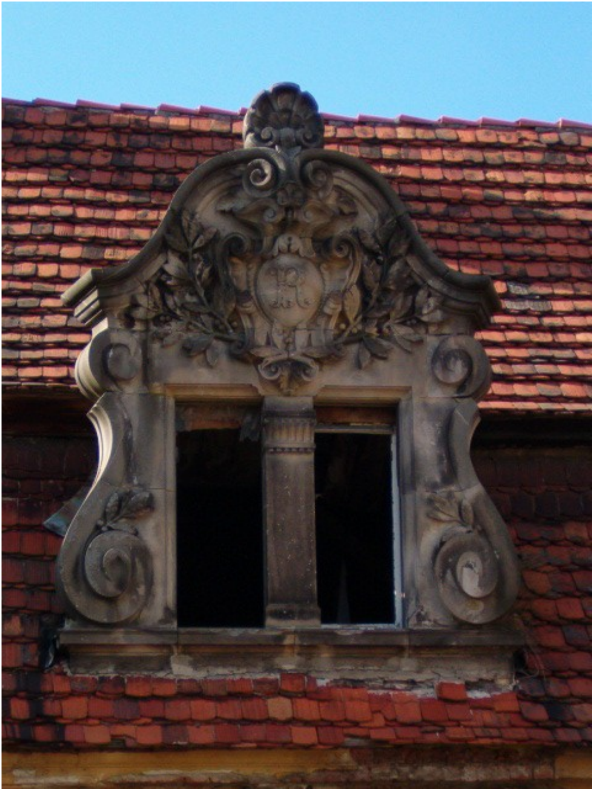
Fot. 75. Fajata występująca nad bocznymi bramami przejazdowymi od strony dziedzińca.
