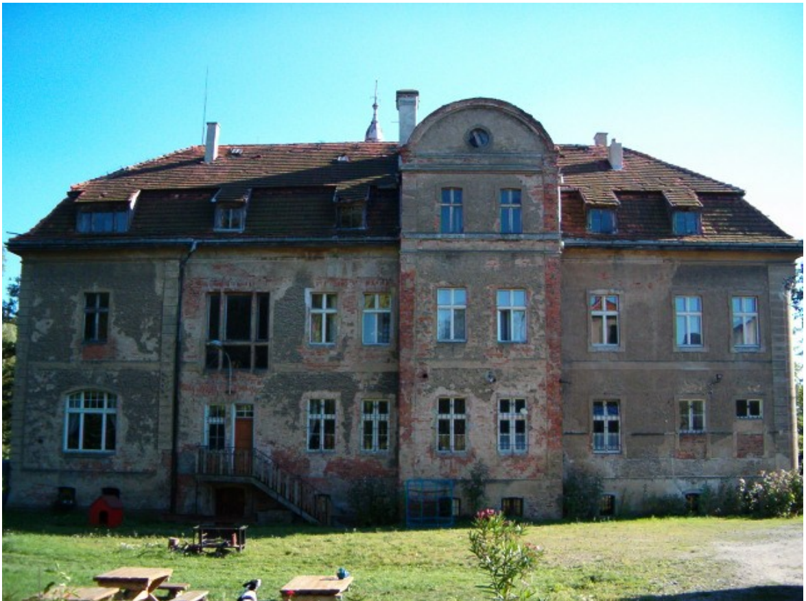
Fot. 46. Elewacja północna.
