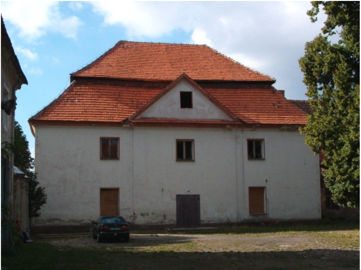
Fot. 82. Ujeżdżalnia (oficyna 4) w skrzydle północnym.
