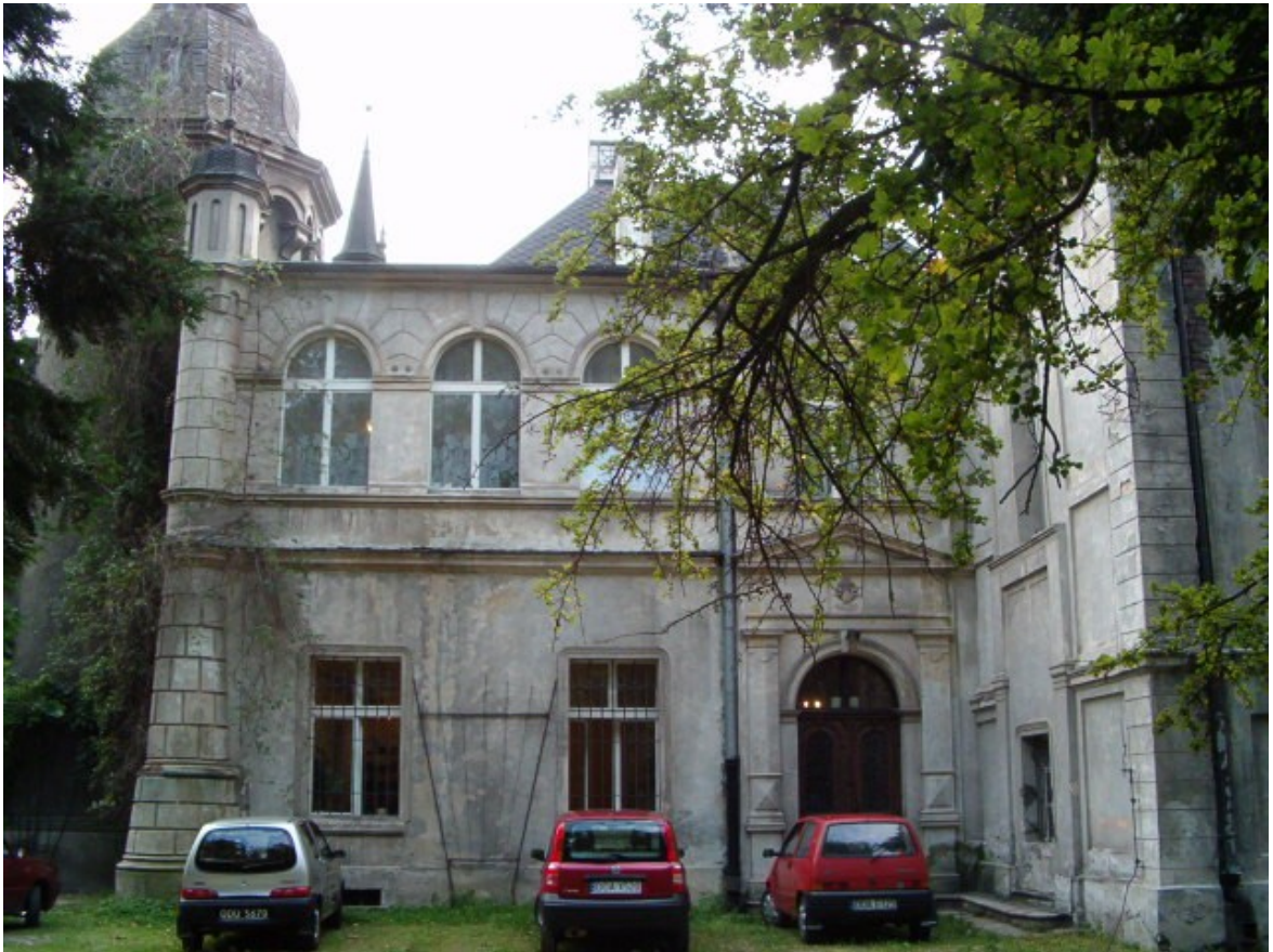
Fot. 118. Elewacja północna.
