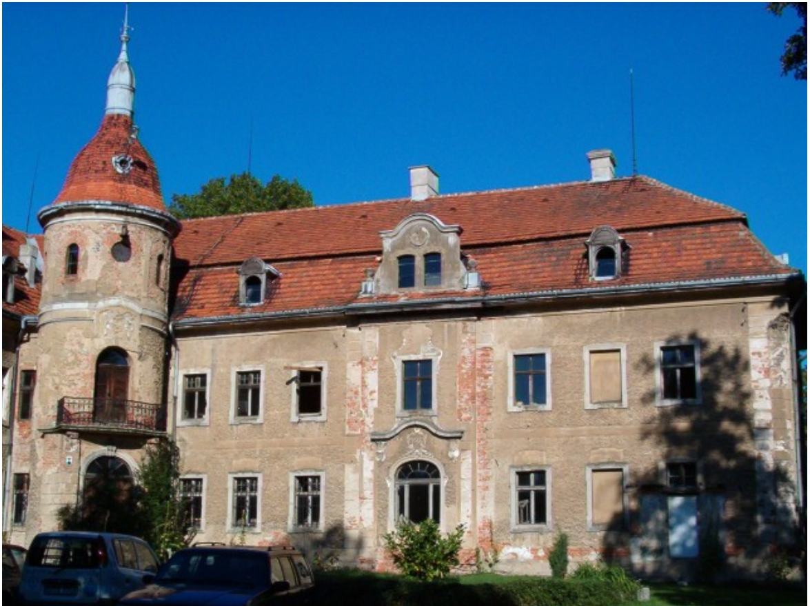
Fot. 39. Elewacja zachodnia (frontowa) skrzydła wschodniego.
