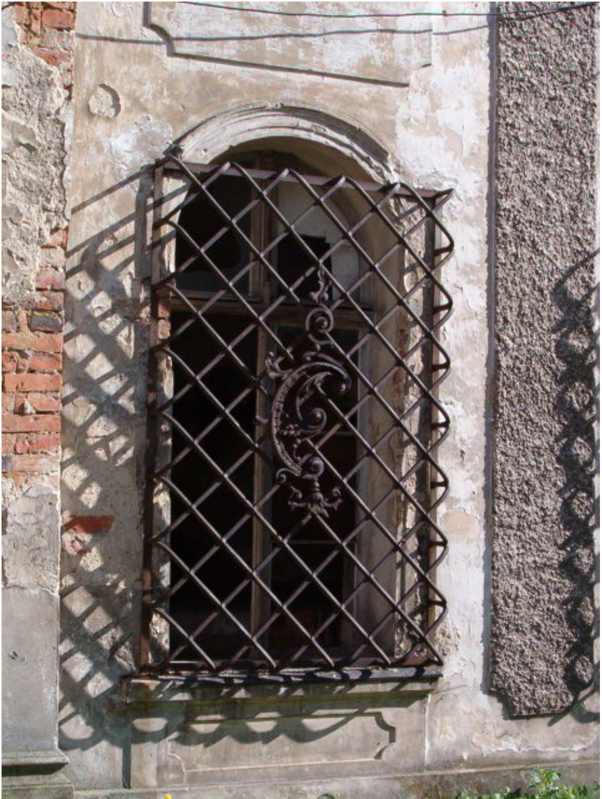
Fot. 79. Okno przyziemia domu gościnnego w skrzydle południowym.
