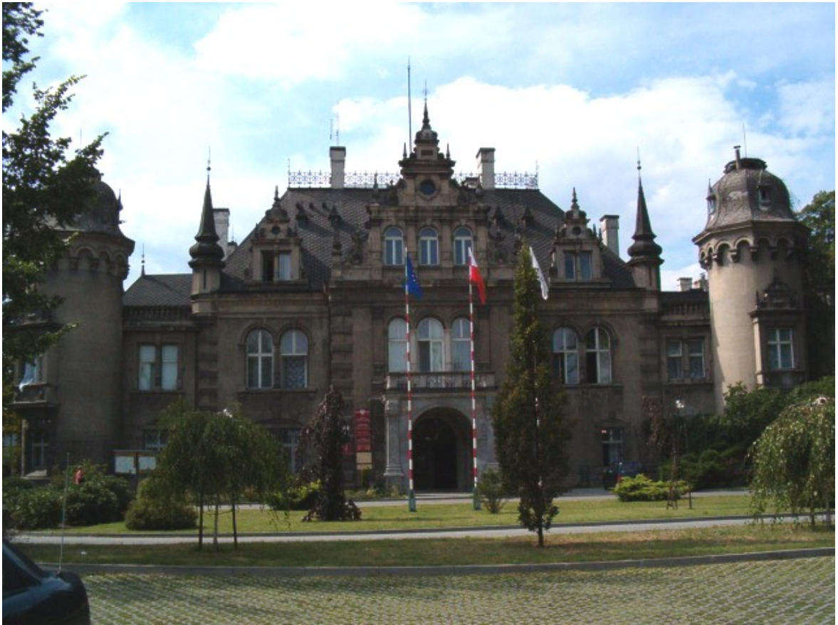
Fot. 107. Elewacja południowo-wschodnia (frontowa).
