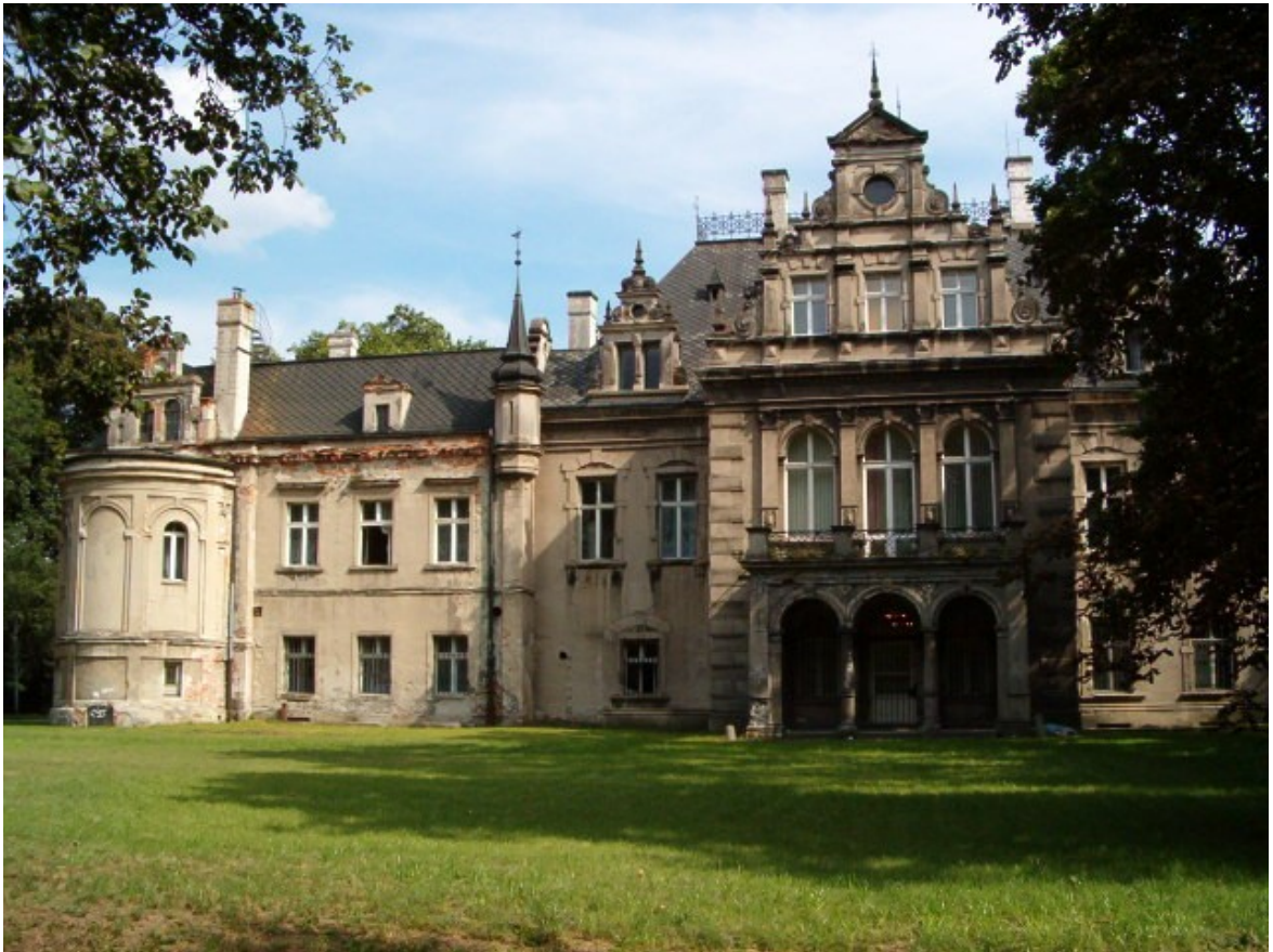
Fot. 111. Elewacja zachodnia (ogrodowa).
