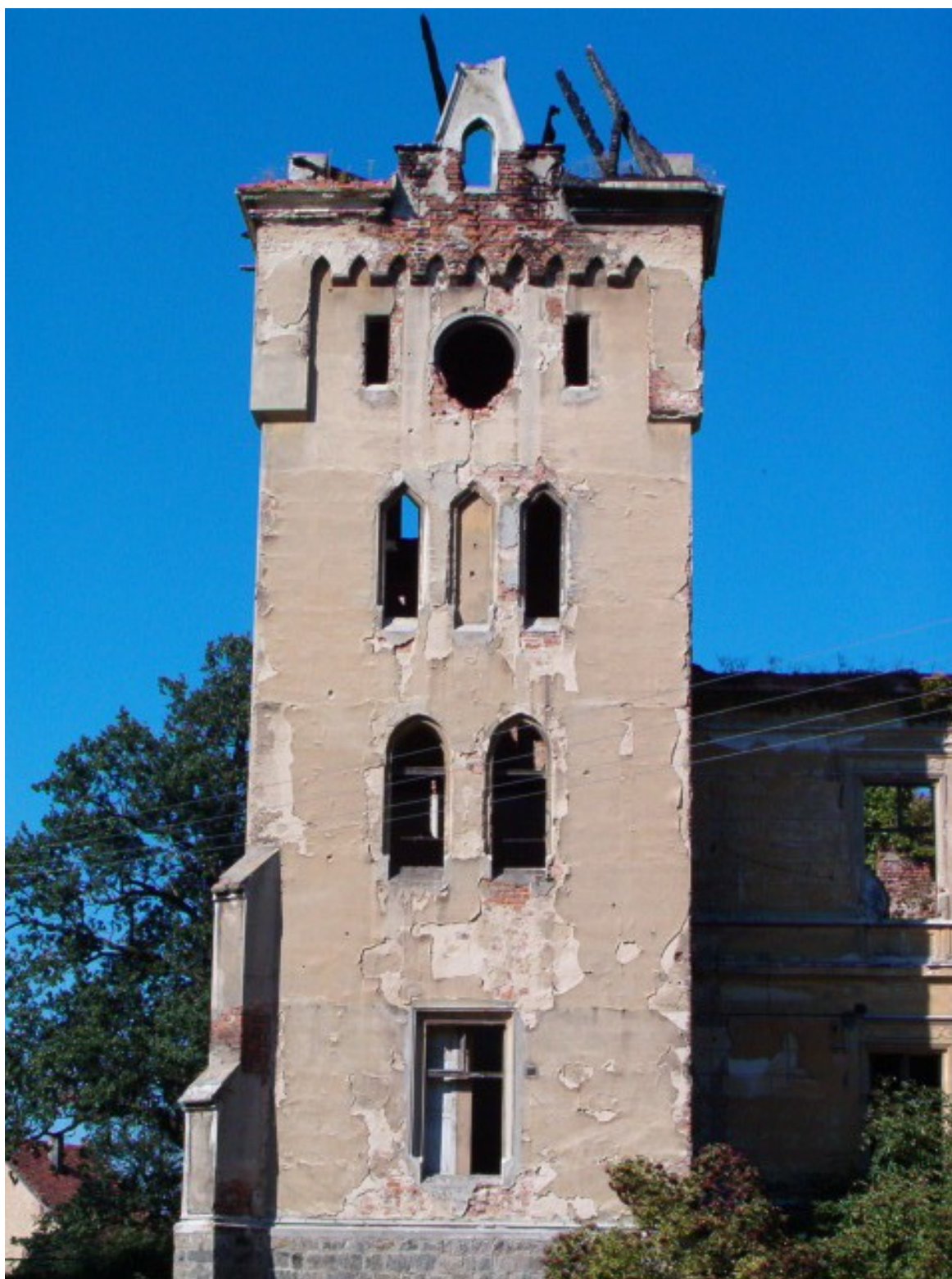
Fot. 24. Elewacja południowa południowo-zachodniej wieży.
