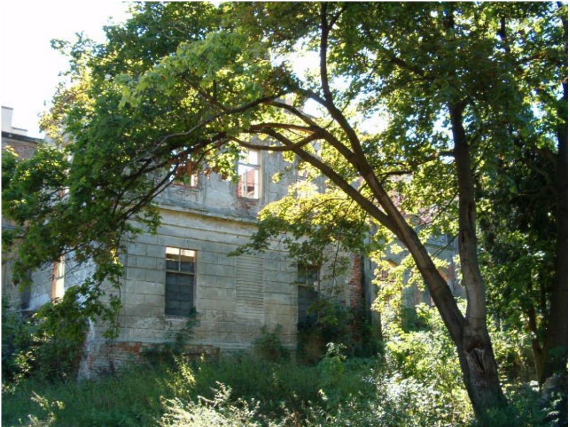
Fot. 15. Elewacja północna (wschodnia 3-osiowa partia boczna).
