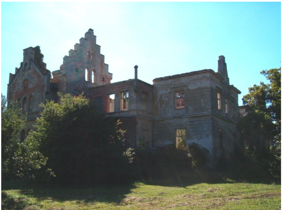
Fot. 16. Korpus główny z przybudówką i południowo-wschodnią wieżą.
