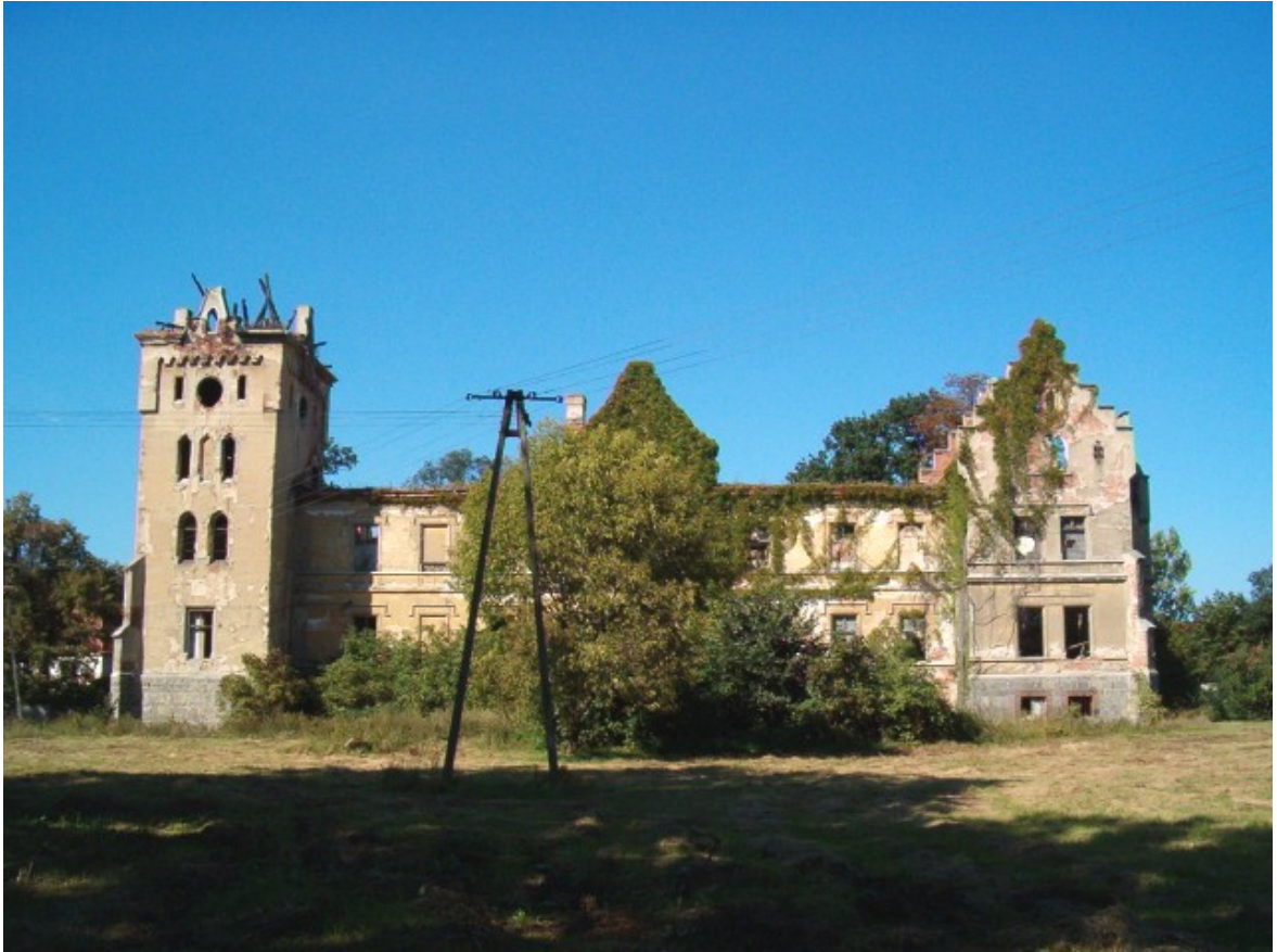
Fot. 21. Elewacja południowa.
