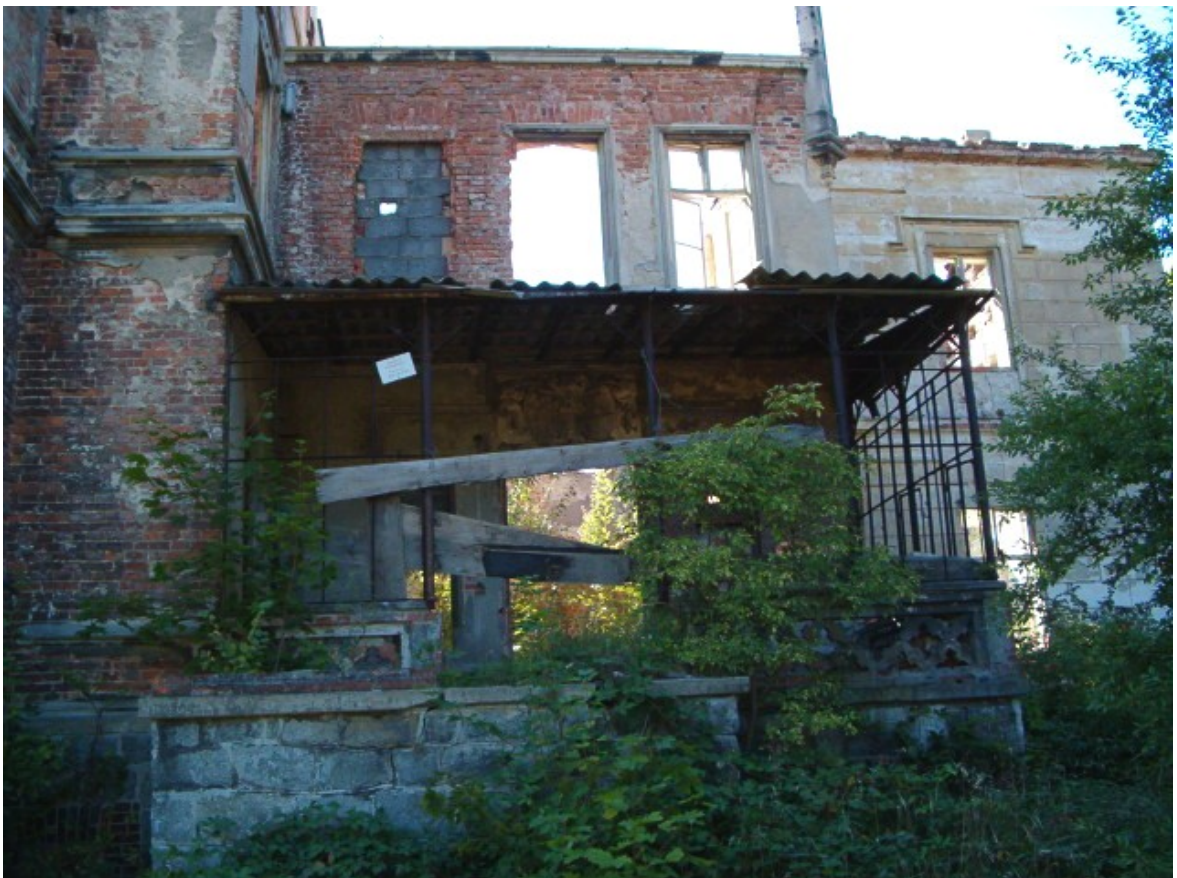
Fot. 18. Przybudówka z weranda we wschodniej elewacji pałacu.
