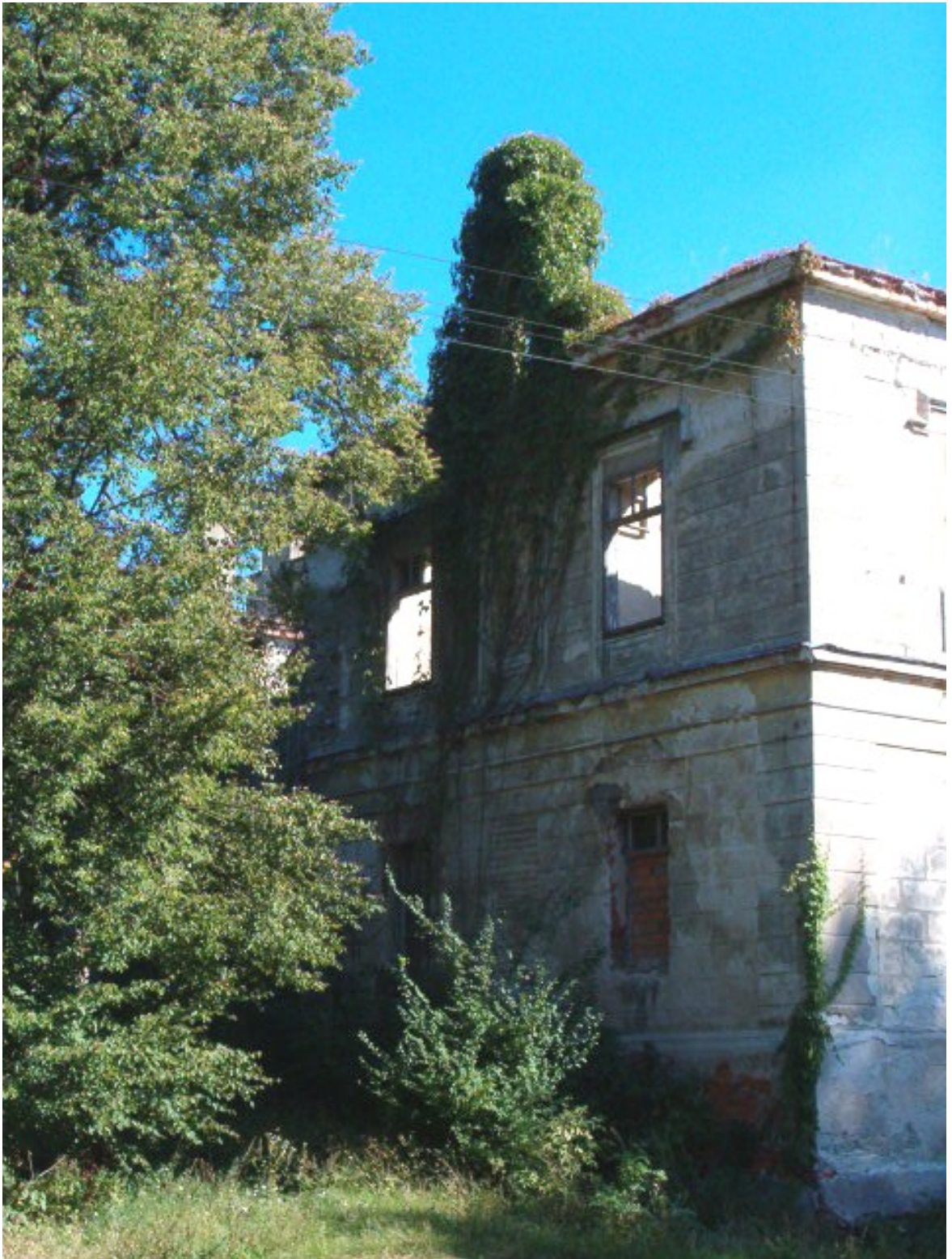
Fot. 12. Elewacja północna (zachodnia 3-osiowa partia boczna).
