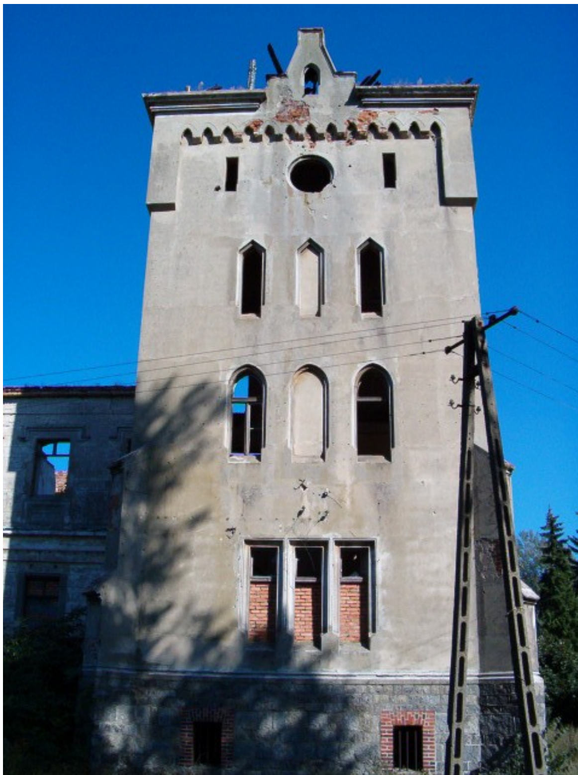
Fot. 25. Elewacja zachodnia południowo-zachodniej wieży.
