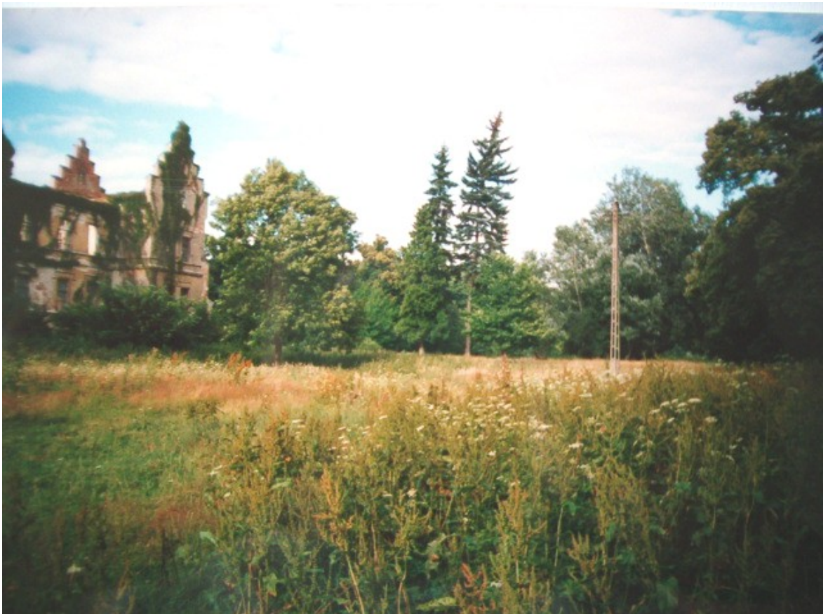
Fot. 6. Polana przy południowej elewacji pałacu.
