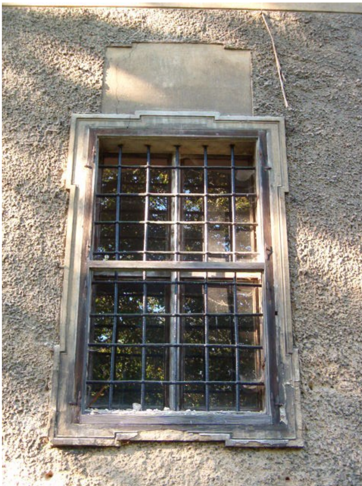
Fot. 52. Obramienia okienne w południowej elewacji skrzydła wschodniego.
