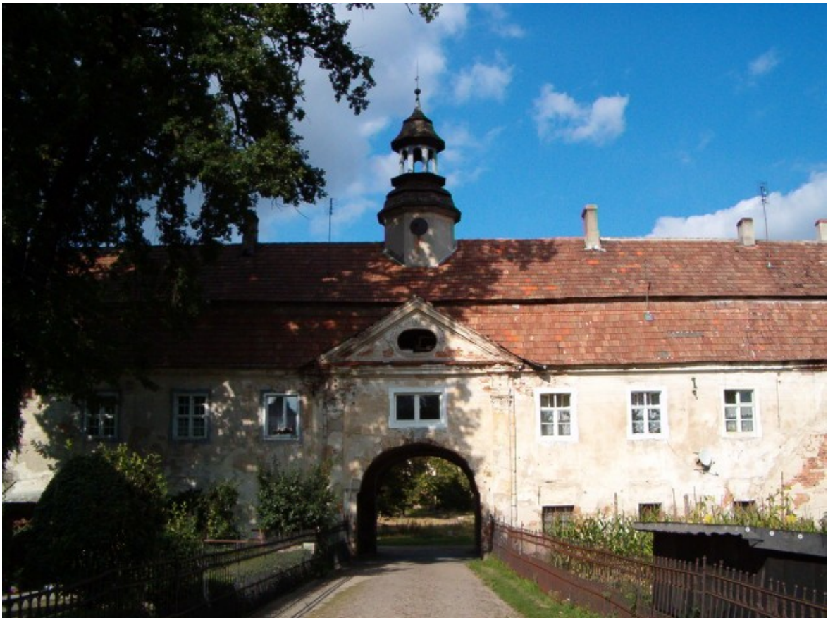
Fot. 85. Elewacja frontowa budynku bramnego – główny wjazd na teren założenia.
