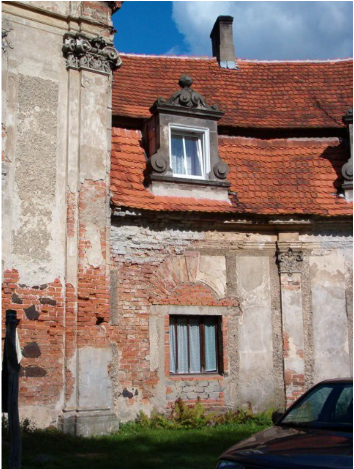
Fot. 76. Skrzydło południowe przy korpusie głównym pałacu.
