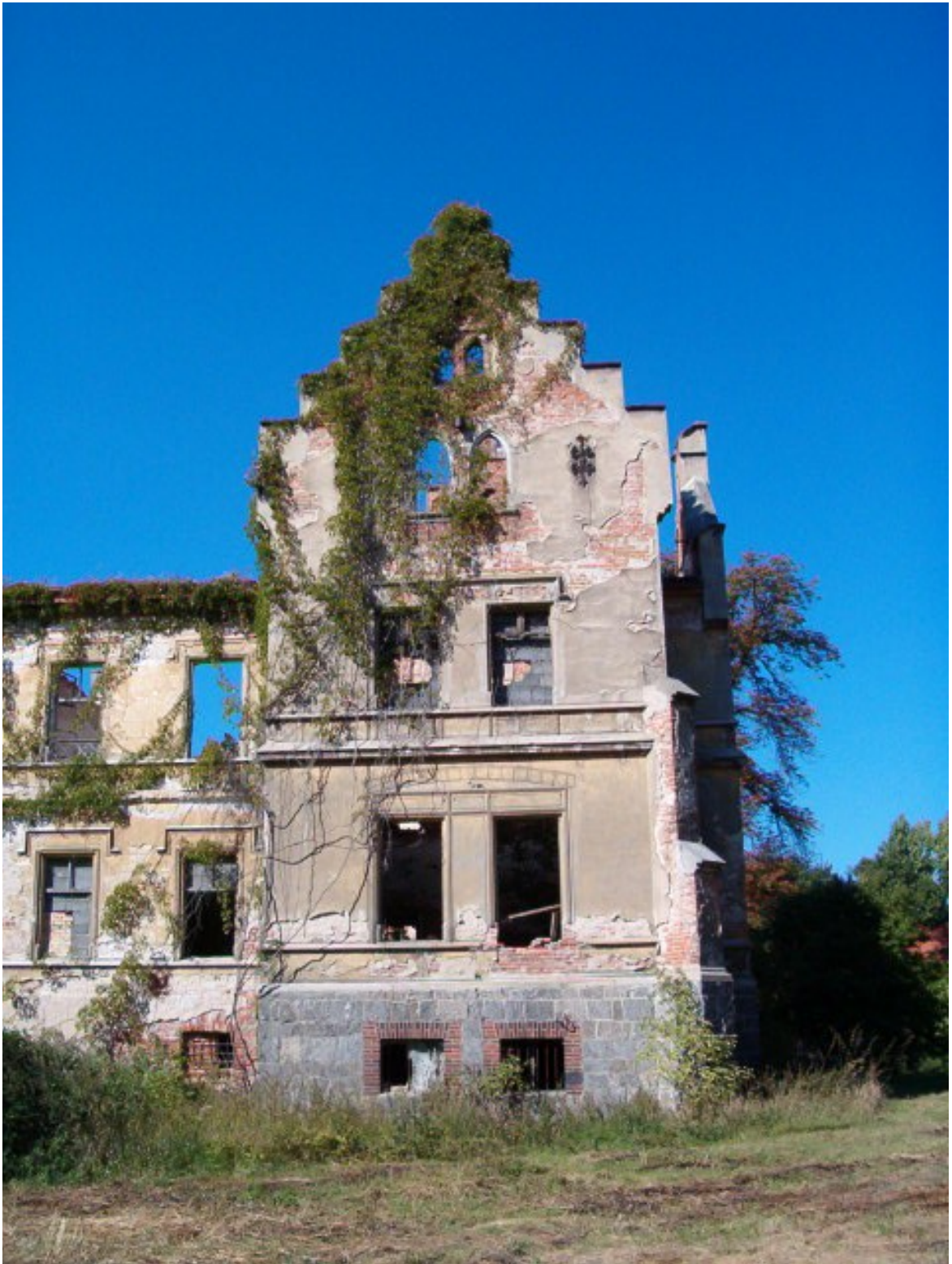
Fot. 20. Elewacja południowa południowo-wschodniej wieży.
