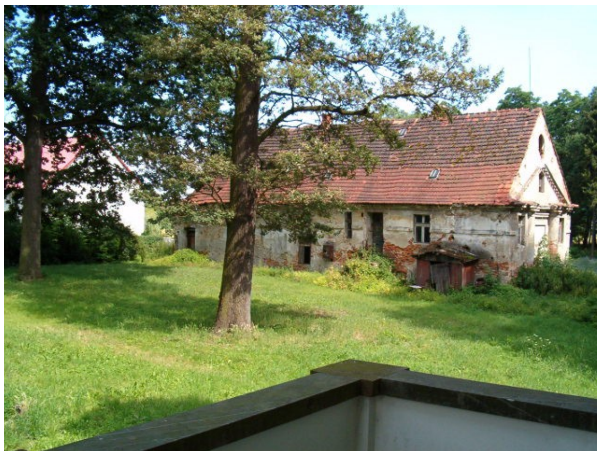
Fot. 148. Zabudowa folwarczna przy południowo-wschodnim narożniku dziedzińca folwarcznego.
