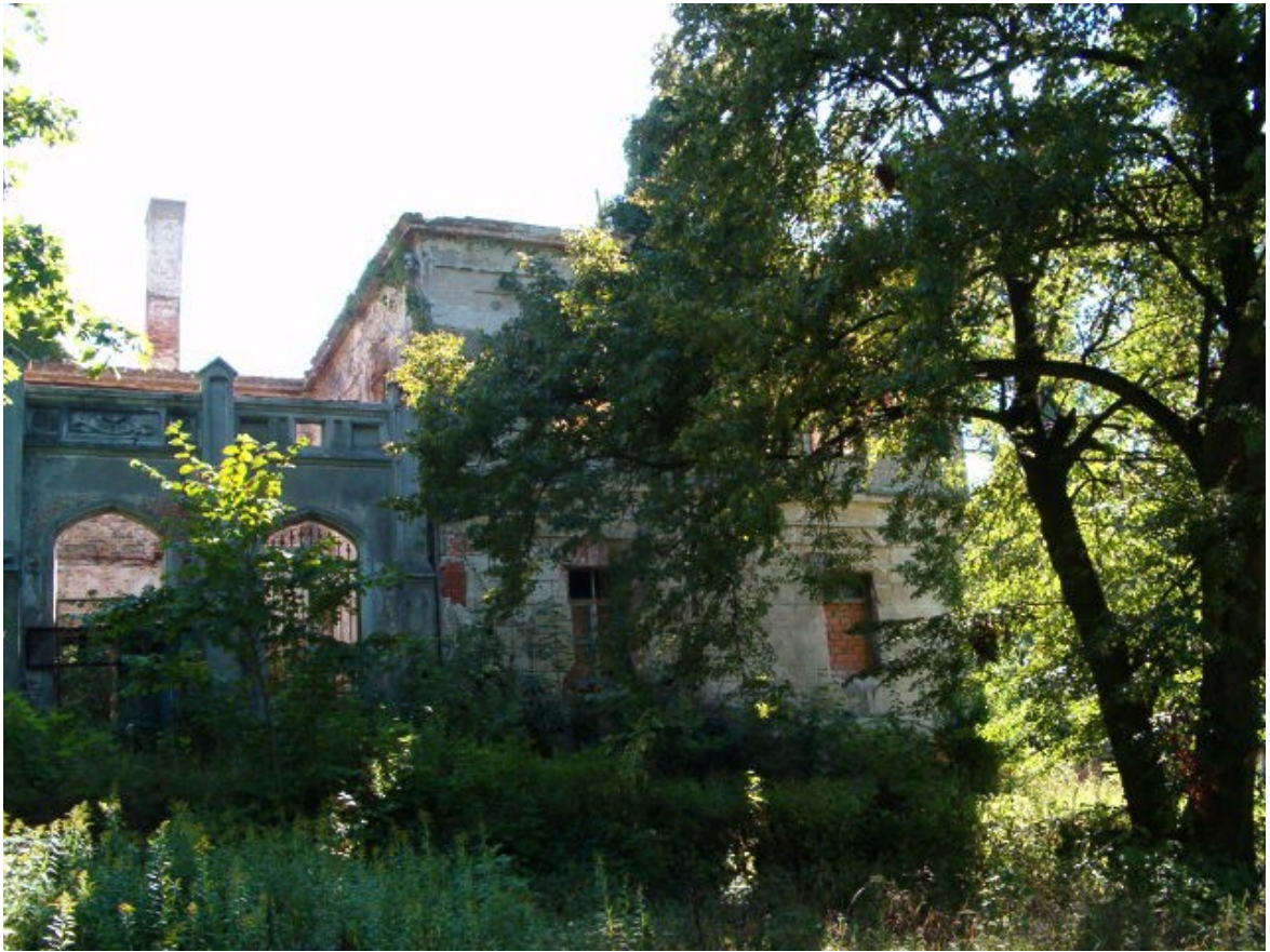
Fot. 13. Elewacja północna.
