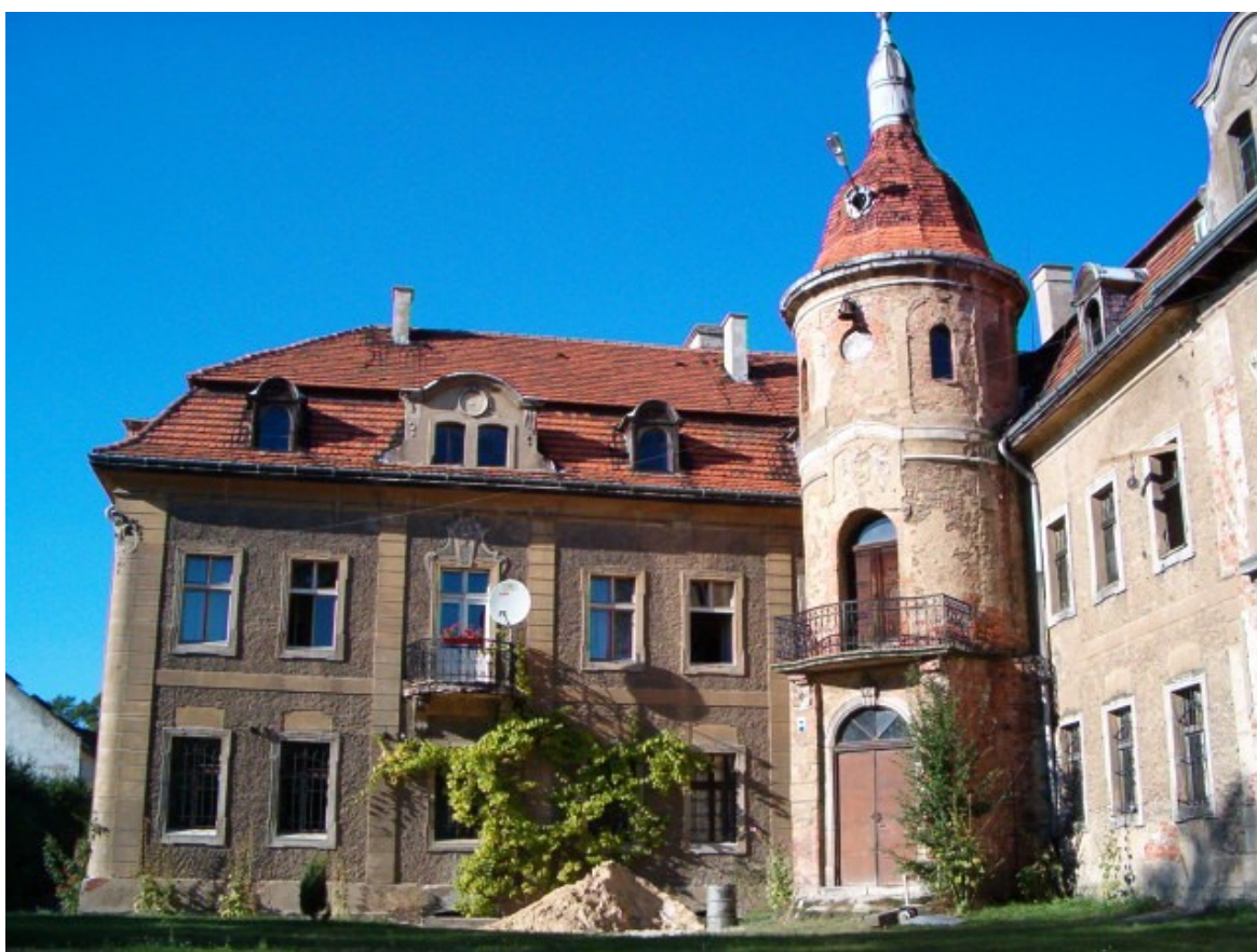
Fot. 43. Elewacja południowa (frontowa) skrzydła północnego.
