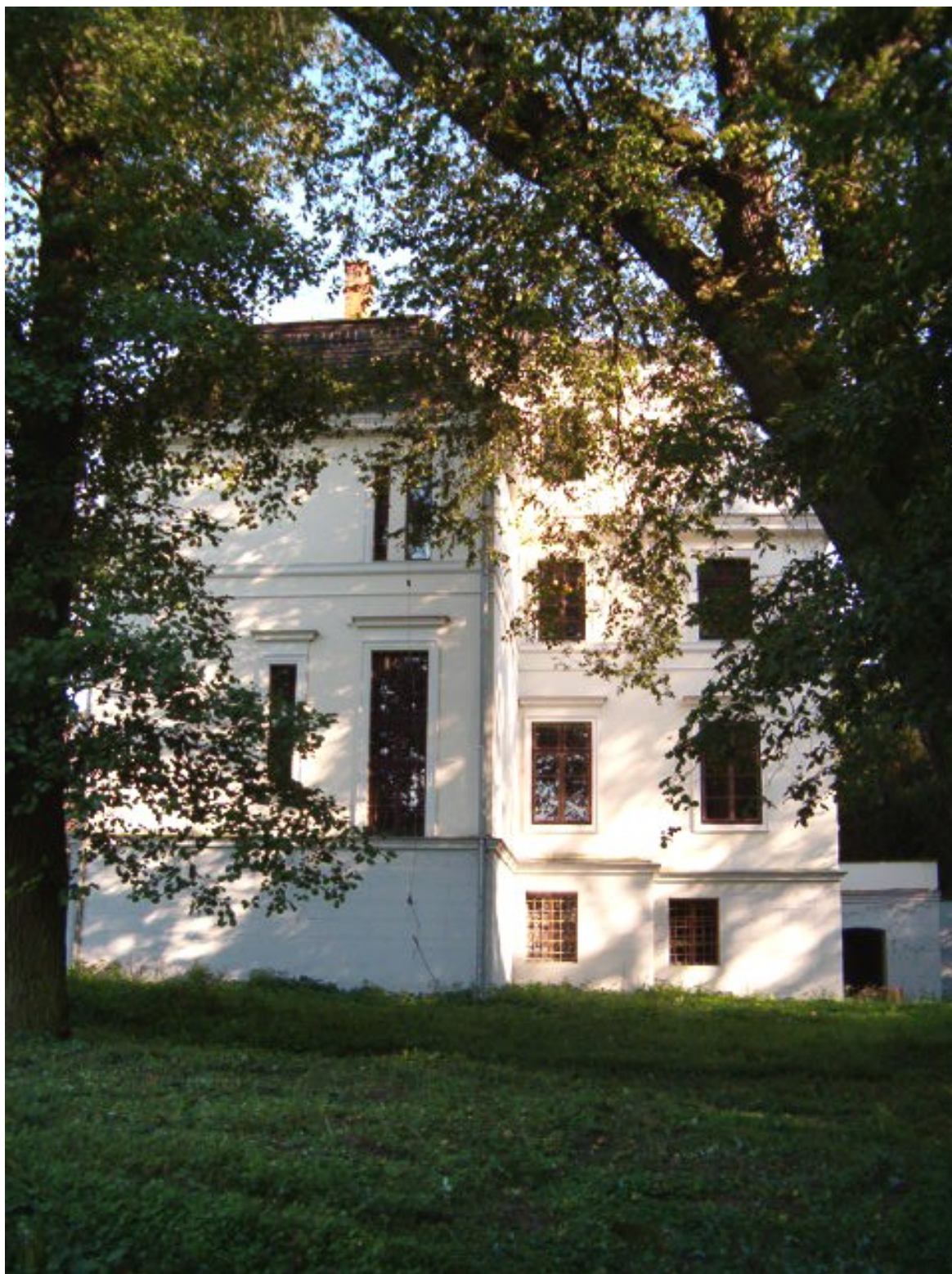
Fot. 141. Elewacja północno-zachodnia z przybudówką.
