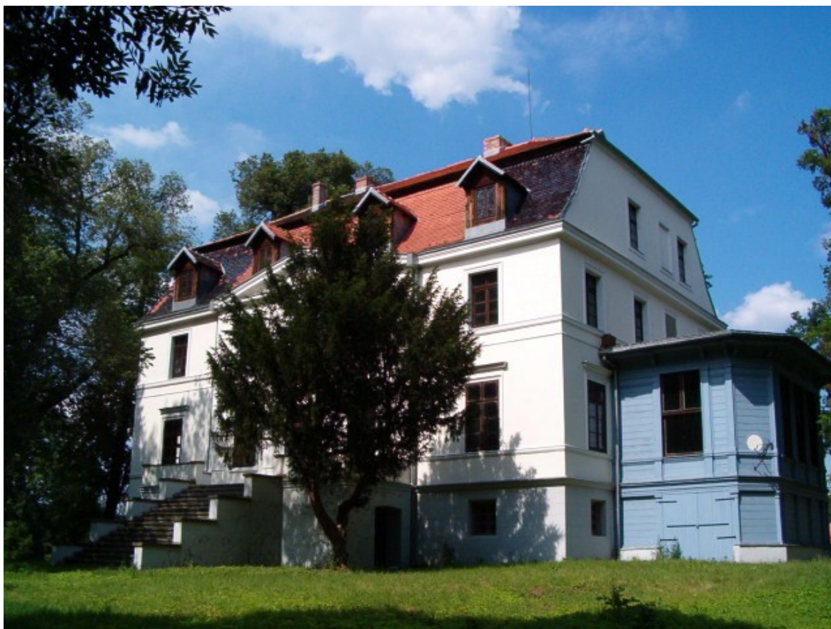
Fot. 137. Elewacja południowo-zachodnia (ogrodowa).
