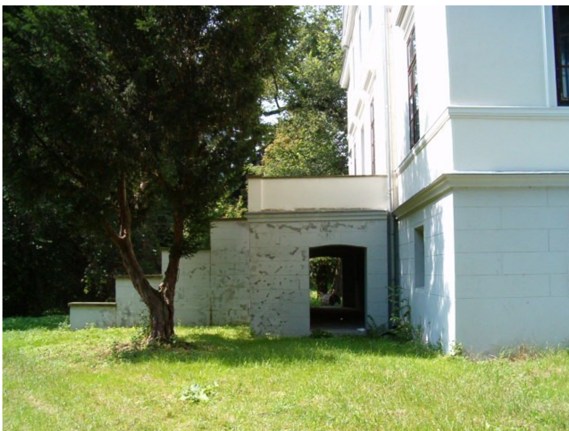
Fot. 138. Ganek przy południowo-zachodniej (ogrodowej) elewacji pałacu.
