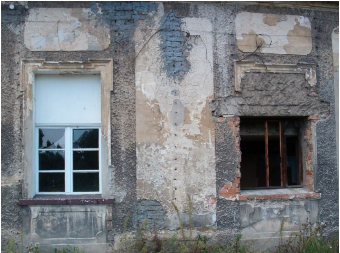
Fot. 87. Okna elewacji ogrodowej oficyny 1 – skrzydło południowe.
