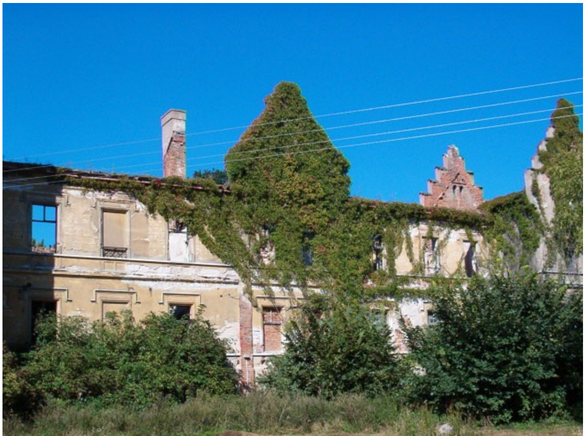
Fot. 22. Elewacja południowa korpusu głównego.
