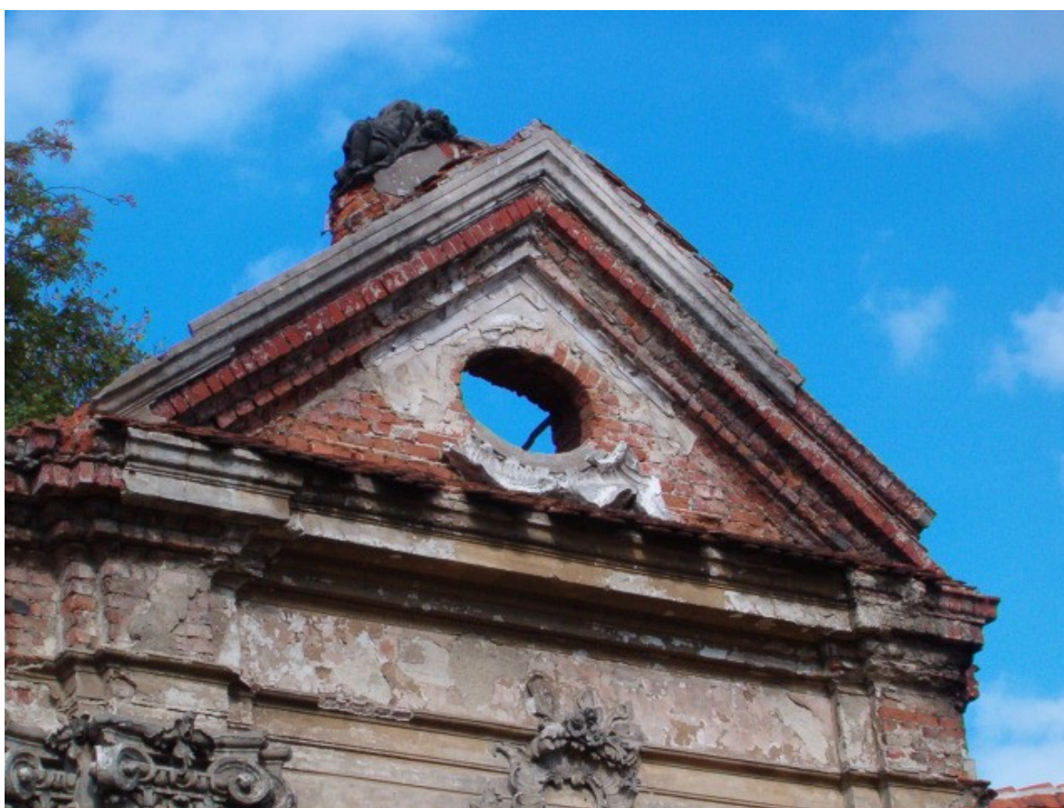
Fot. 70. Szczyt ryzalitu bocznego (południowego) elewacji frontowej.
