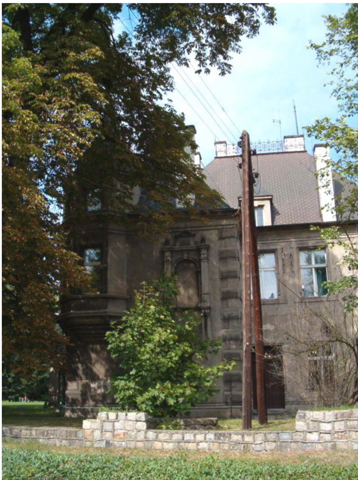
Fot. 120. Elewacja południowa (narożnik zachodni).
