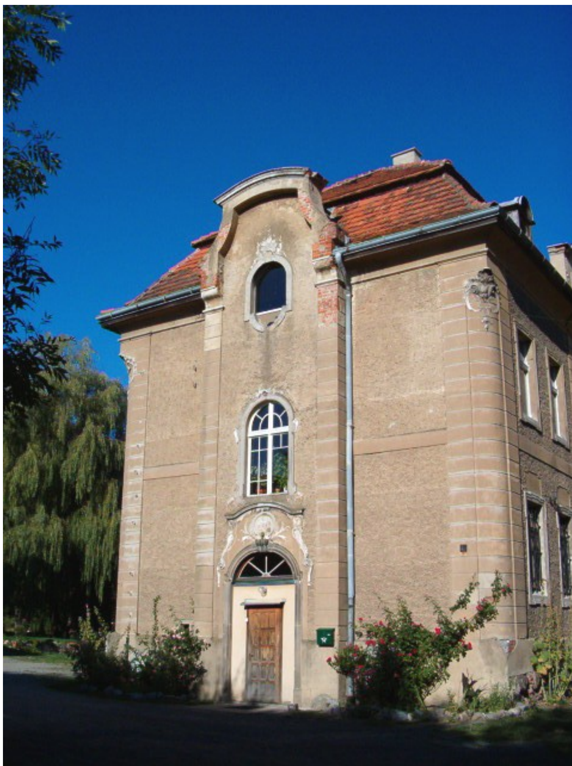
Fot. 44. Elewacja zachodnia skrzydła północnego.
