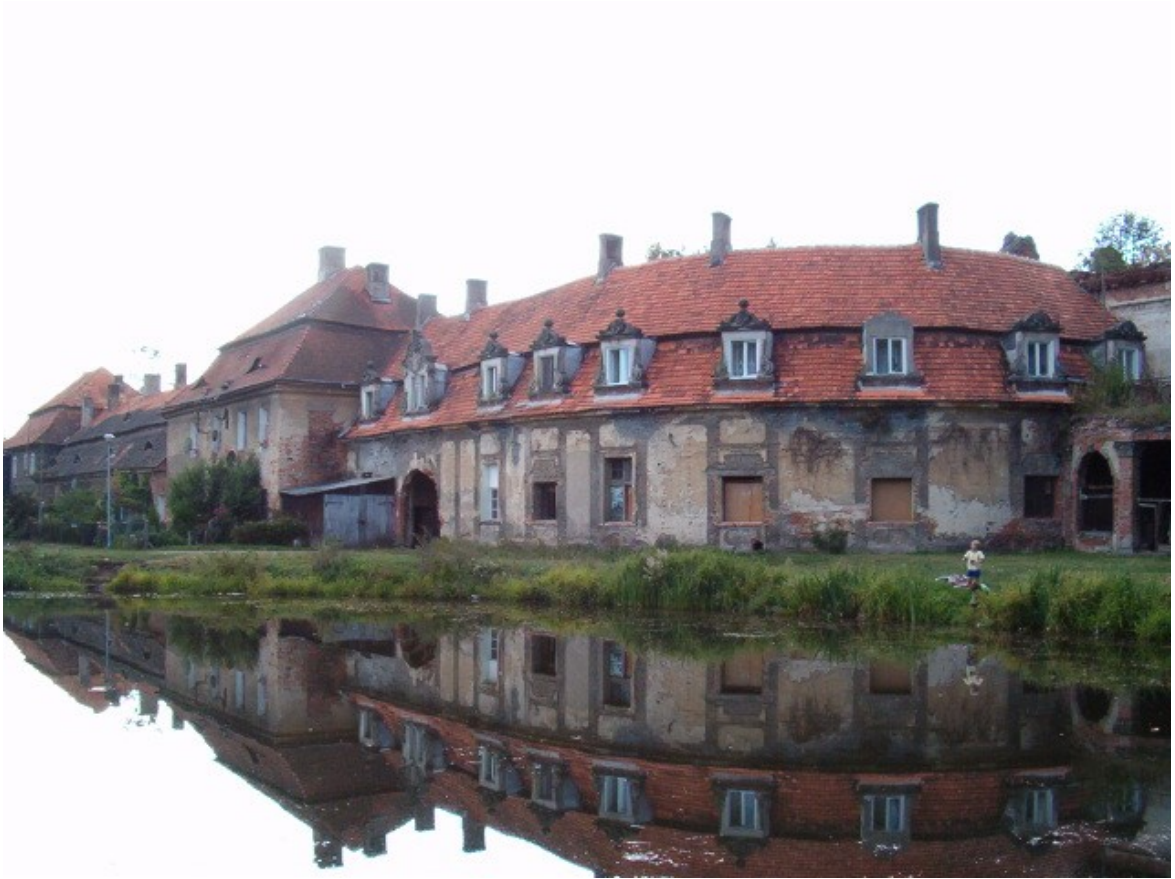
Fot. 86. Elewacja ogrodowa skrzydła południowego.
