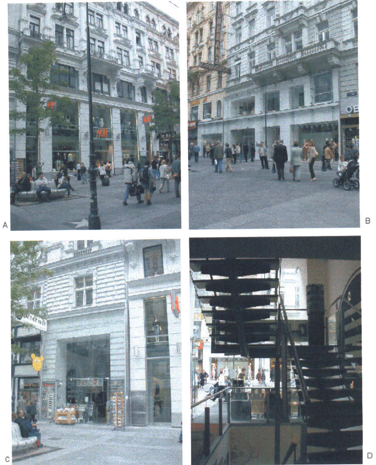
Ryc. 4.1.4. Adaptacje piwnic, parterów, oraz wyższych kondygnacji (pierwszego piętra) wiedeńskich kamienic na lokale komercyjne. A,B,C - Przykłady rozwiązywania nowych kompozycji elewacji frontowej. D - Wewnętrzna klatka schodowa łącząca piwnicę, parter i pierwsze piętro lokalu zaadaptowanego na księgarnię. Źródło: Fotografie własne autora.
