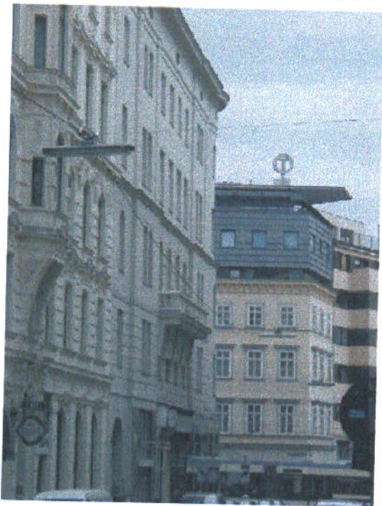
Ryc.4. 1.24. Przykłady adaptacji i nadbudów dachów płaskich wiedeńskich kamienic czynszowych. Źródło: Fotografie własne autora.
