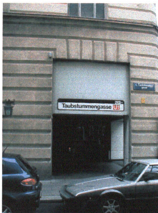
Ryc. 4.1.13. Zejście do stacji wiedeńskiego metra zlokalizowane w kamienicy czynszowej. Źródło: Fotografia własna autora.
