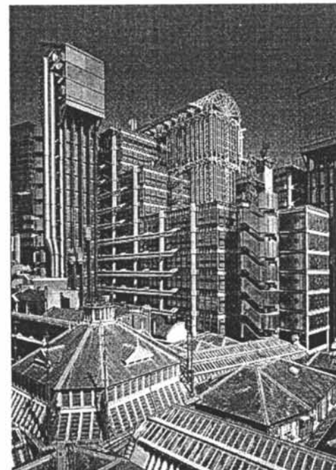
R.Rogers, budynek Towarzystwa Ubezpieczeniowego Lloydsa w Londynie (1986)
