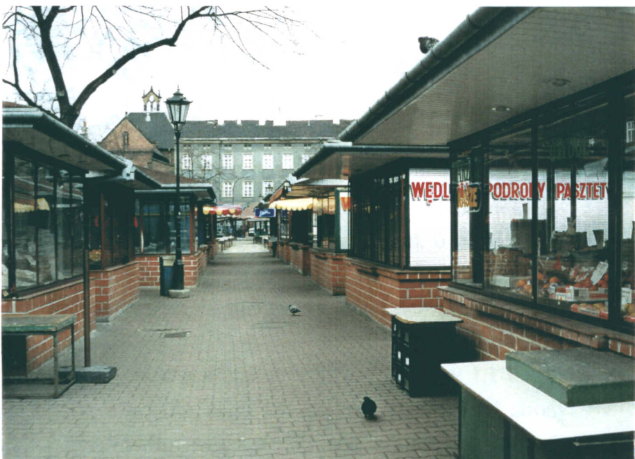
Ryc. 66. Zabudowa Starego Kleparza 1996 r. - fot. autor.
