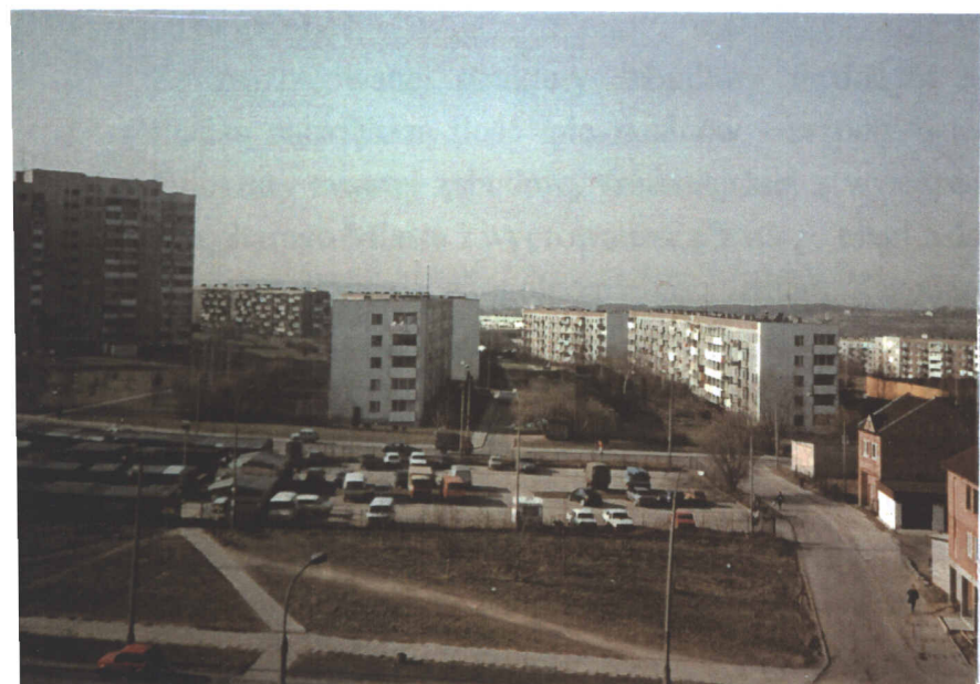
Ryc. 48. Parking przy placu "Manhattan" dzierżawiony przez administrację placu targowego fot. autor
