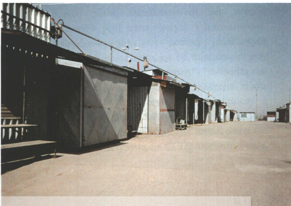
Ryc. 111. Plac "Efekt" przy ul. Botewa -"uliczka handlowa" 1996 r. - fot. autor.
