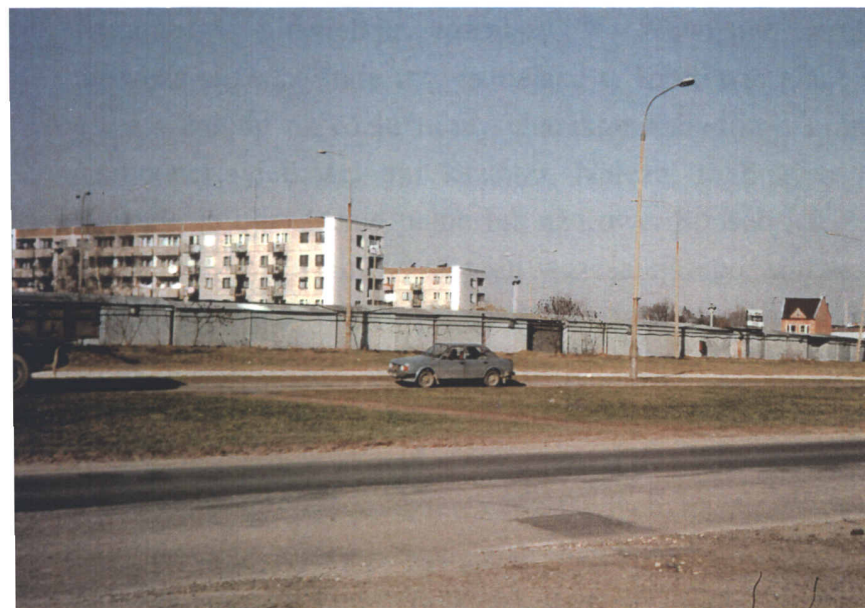
Ryc. 95. "Błaszna ściana" placu "Manhattan" widoczna od strony ul. Beskidzkiej 1997 r. fot. autor
