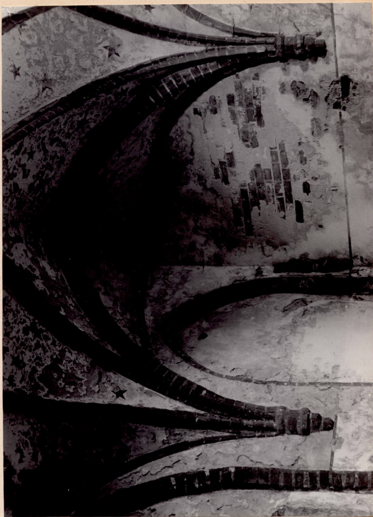
Il.95. Nowo, fragment sklepienia krypty w kościele pofranciszkańskim /początek w.XIV/. Nad wspornikiem widoczne relikty pierwotnych żebier. Fot. J.T.Frażlik 1953.
