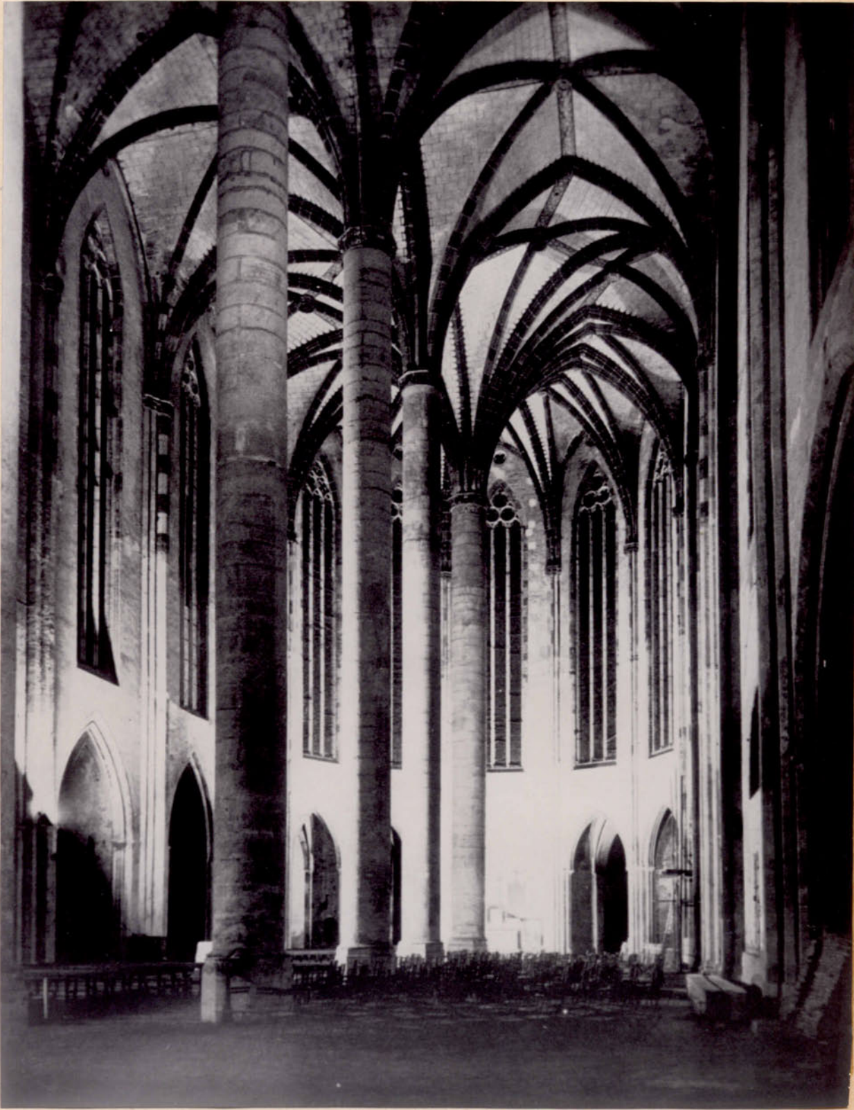
Il. 89. Tuluza, kościół dominikanów, wnętrze /1245-1292/.
