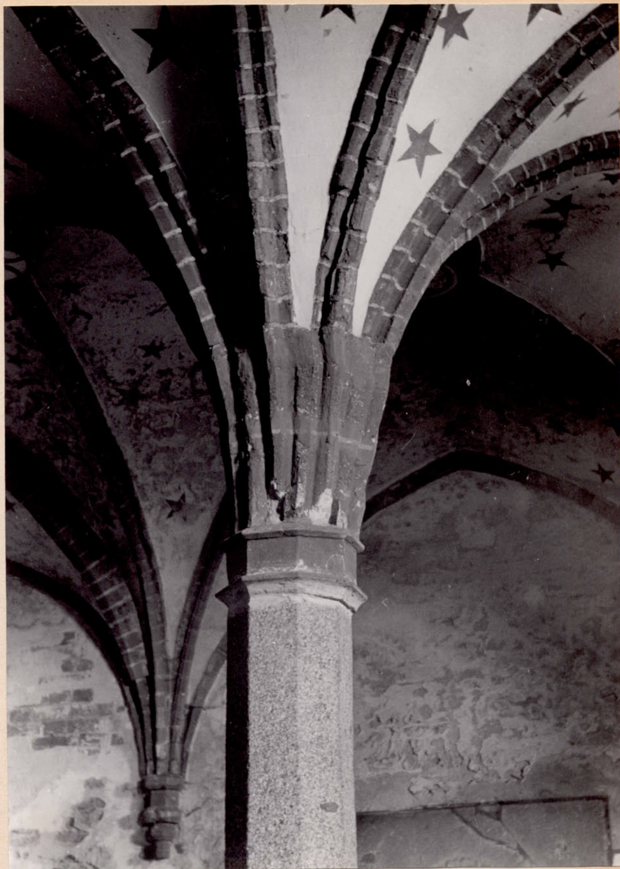
Il.94. Nowe, fragment sklepienia krypty w kościele pofranciszkańskim /początek w.XIV/.- Nad głowicą, ośmiobocznego filara widoczna pierwotna nasada sklepienia z fragmentami nieistniejących żeber jarzmowych, dzielących dawniej sklepienie na osiem klasycznych przęseł trójkątnych.- Fot. J.T.Frazik 1953.
