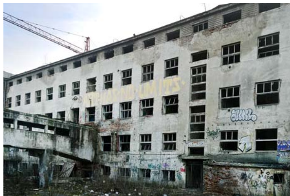
Ryc. 7. Elewacja tylna budynku biurowego – część północna (fot. J. Dąbrowski)
