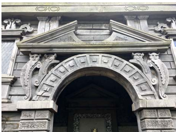
Ryc. 14. Dekoracyjny luk nad wejściem do Pałacu Oberona wykonany z jednego kawałka drewna
