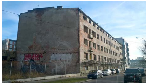
Ryc. 4. Elewacja frontowa budynku biurowego – stan obecny (fot. J. Dąbrowski)
