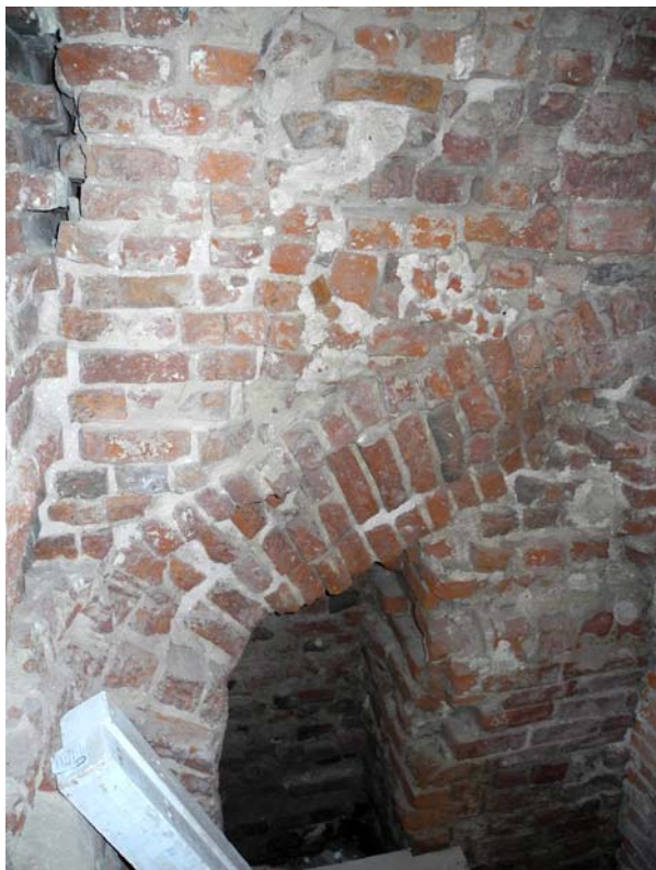
Ryc. 22. Wieża Klesza na Zamku Wysokim w Malborku. Piwnica, pomieszczenie nr 02. Narożnik południowo-wschodni. Widok na ścianę południową z szerokim, skutym łukiem, tworzącym pierwotnie sklepienie kolebkowe. Partia środkowa muru nieregularna, wtórnie wypełniona, co mogło się łączyć z jej pęknięciem. Przestrzeń poniżej sklepienia została obmurowana w momencie rozbudowy kościoła (fot. M. Prarat, 2015)
