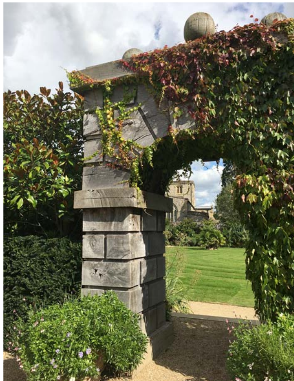
Ryc. 7. Drewniana brama prowadząca do ogrodów użytkowych Fig. 7. Wooden gate leading to utility gardens
