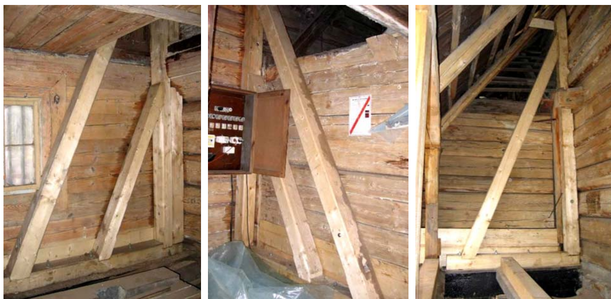
Ryc. 17. Wykonane wzmocnienie ścian kościoła pw. św. Michała Archanioła w Żernicy: a) rama w zakrystii, b) rama w przedsionku zakrystii, c) rama w składziku Fig. 17. Realized strengthening of the walls in Żernica: a) in the sacristy, b) in the vestibule, c) in store room
