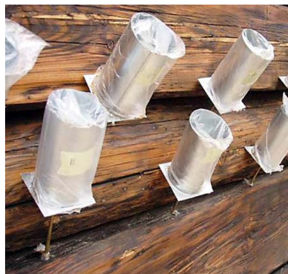
Ryc. 20. Widok i szczegół ścian kościoła pw. św. Michała Archanioła w Żernicy podczas impregnacji grawitacyjnej Fig. 20. View and detail of the walls of the St. Michael the Archangel church in Żernica during the gravity impregnation
