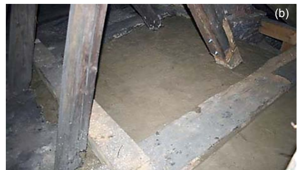
Ryc. 2. Zaprojektowana (a) i wykonana (b) naprawa krokwi i belki więzarowej: 1 – istniejąca belka podłużna, 2 – śruby stalowe, 3 – stalowe pierścienie łącznikowe, 4 – uszkodzona belka więzarowa, 5 – wstawka drewniana, 6 – stalowe śruby
