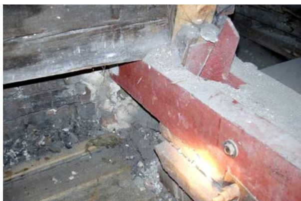
Ryc. 15. Wzmocnienia stref oparcia zbutwiałych belek nośnych elementami stalowymi w kościele pw. Podwyższenia Krzyża Świętego w Sławkowie (XIII w.)
