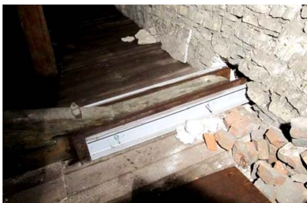
Ryc. 15. Wzmocnienia stref oparcia zbutwiałych belek nośnych elementami stalowymi w kościele pw. Podwyższenia Krzyża Świętego w Sławkowie (XIII w.)
