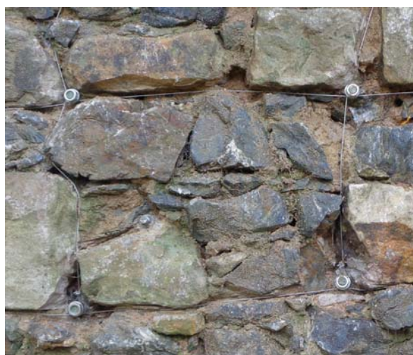
Ryc. 4. Wzmocnienie ściany kamiennej na zamku we Wleniu Fig. 4. Strengthening the stone wall in the castle in Wien
