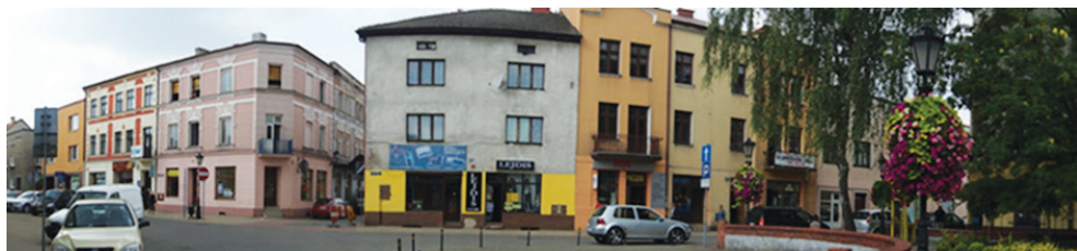
Il. 9. Oświęcim. Zdewastowana kamienica narożna przy ulicy Klasztornej oraz Mały Rynek, pustostan (fot. K. Paprzyca) 18
