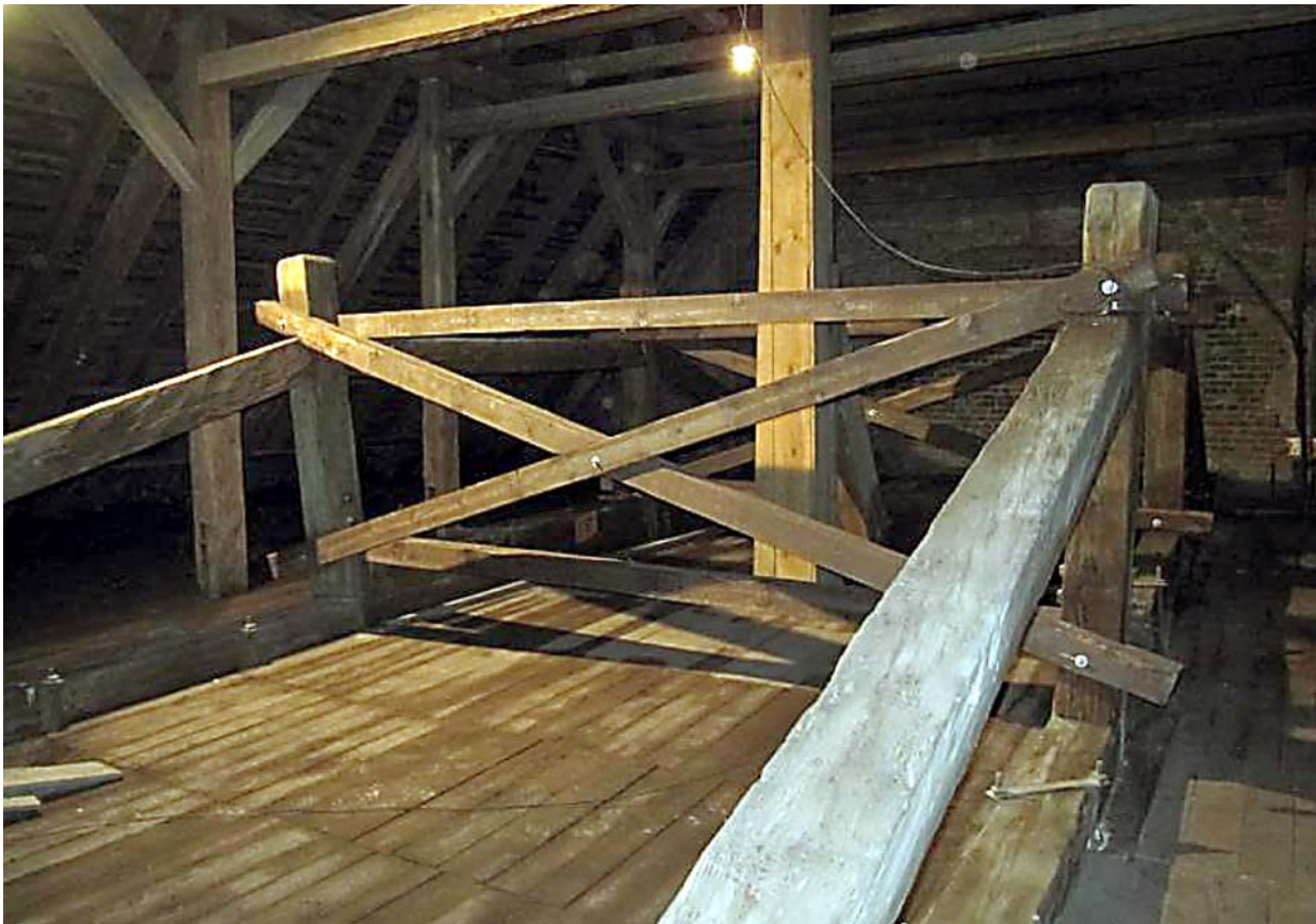
Ryc. 18. Wykonane stężenie wieszarów stropowych nawy kościoła pw. Podwyższenia Krzyża Świętego w Sławkowie Fig. 18. Strengthening of load-bearing trapezoidal girders in the Holy Cross church in Sławkowie
