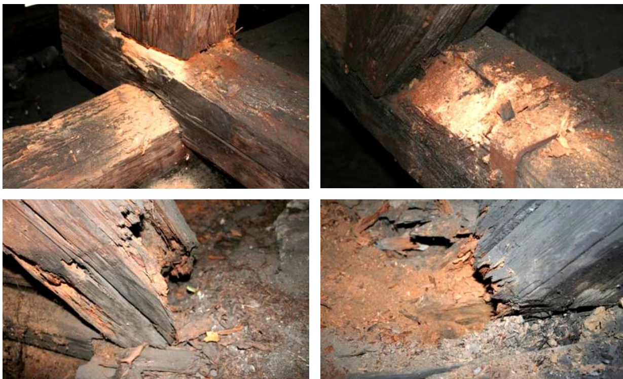
Ryc. 1. Uszkodzenie elementów więźby dachowej przez korozję biologiczną (kościół pw. św. Bartłomieja z XVII w.)
