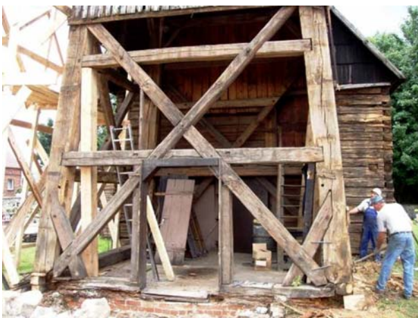
Ryc. 8. Otynkowane mury fundamentowe wraz z obróbką blacharską – rozwiązanie zgodne ze sztuką budowlaną, lecz sprzeczne z kanonami sztuki konserwatorskiej (kościół pw. Najświętszej Marii Panny w Szalszy z XVII w.)
