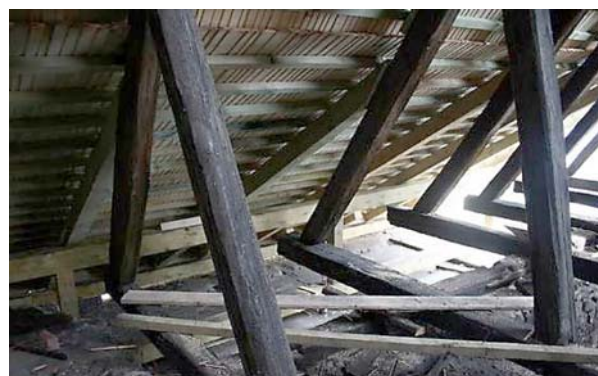
Ryc. 3. Namurnice i przypustnice oraz pokrycie dachu w trakcie remontu w kościele pw. św. Bartłomieja w Gliwicach
