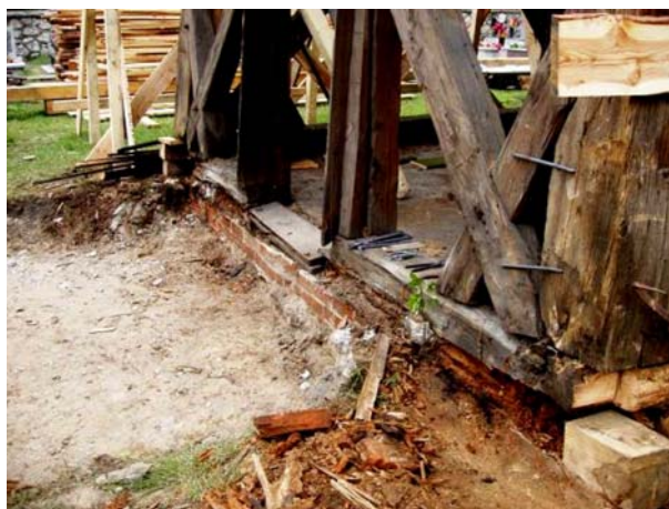
Ryc. 8. Otynkowane mury fundamentowe wraz z obróbką blacharską – rozwiązanie zgodne ze sztuką budowlaną, lecz sprzeczne z kanonami sztuki konserwatorskiej (kościół pw. Najświętszej Marii Panny w Szalszy z XVII w.)
