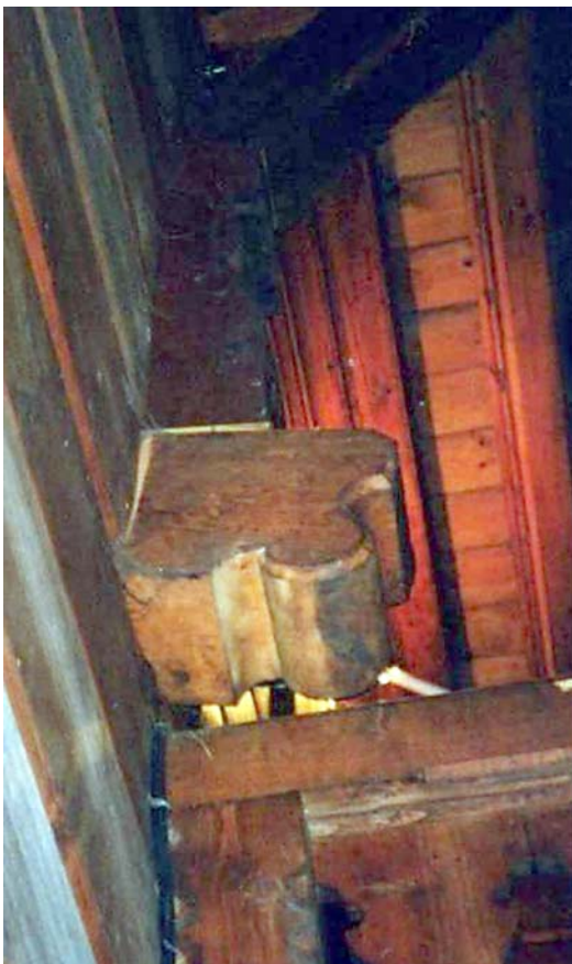
Ryc. 19. Naprawa uszkodzonego wspornika pod zastrzał więzby dachowej: a) widok obróconego wspornika, b) sposób naprawy Fig. 19. Repair of the support of the pillars of braces of main trusses: a) rotated view of the bracket, b) repair method
