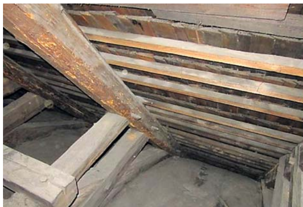
Ryc. 4. Uszkodzenia spowodowane działaniem owadów (kościół pw. św. Mikołaja w Borowej Wsi koło Gliwic z początku XVIII w.)
