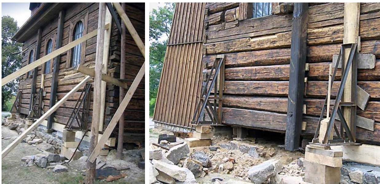
Ryc. 7. Wymiana belki podwalinowej – kościół w Żernicy
