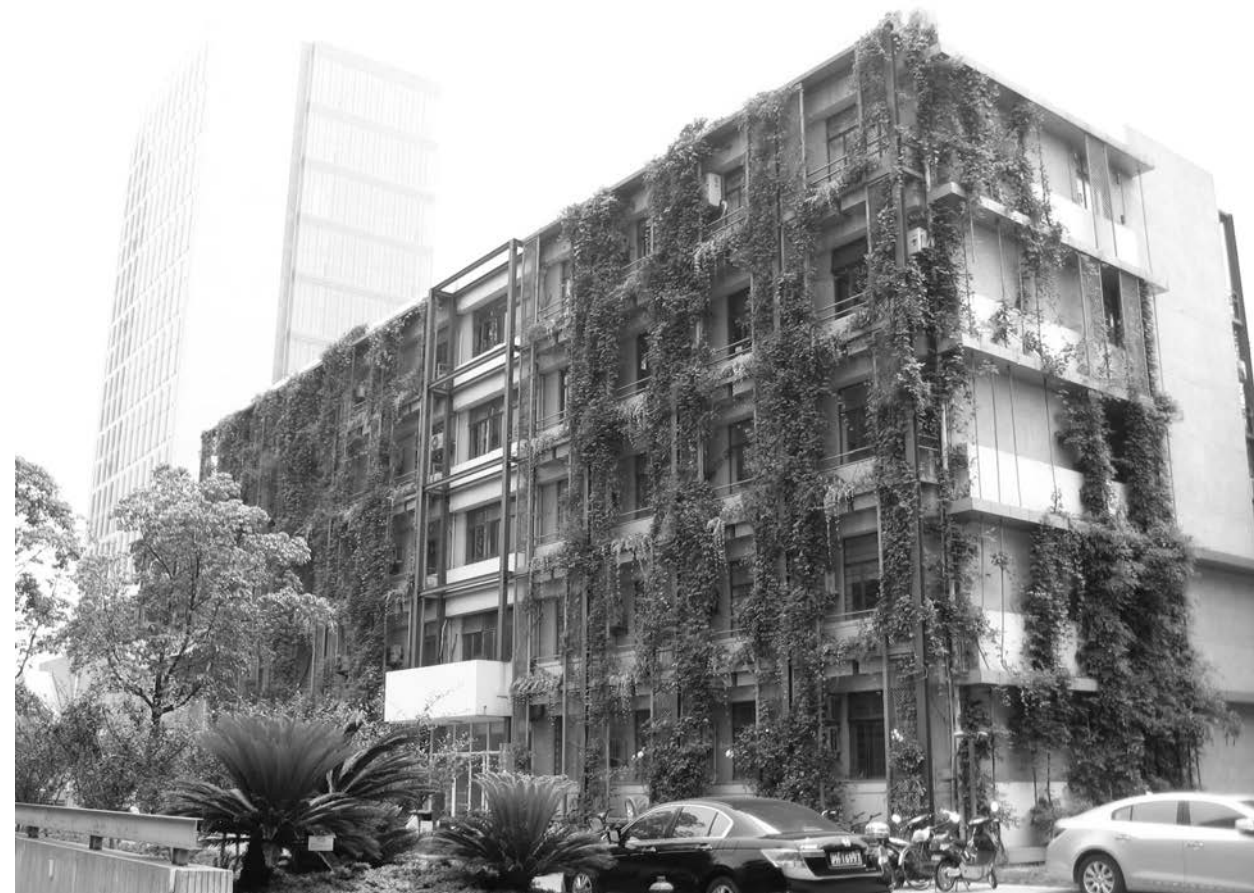
II. 6. Zazieleniona w tradycyjny sposób fasada jednego z budynków uniwersytetu Tongji. Szanghaj, Chiny. Fot.: R. Mikielawicz, 2010 III. 6. A façade of one of Tongji University buildings greened in an old-fashioned way. Shanghai, China. Photo: R. Mikielawicz, 2010
