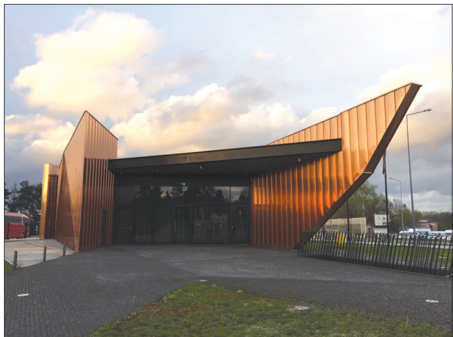
II. 6. Muzeum Ognia w Żorach. Przykład architektury dominującej dzięki zastosowaniu zdecydowanych odcieni na elewacjach. Wykorzystano odbłaskowe i kolorystyczne właściwości miedzi, symbolizujące ogień. Autorzy: Barbara i Oskar Grąbczewscy (fot. K. Ludwin, 2017)
