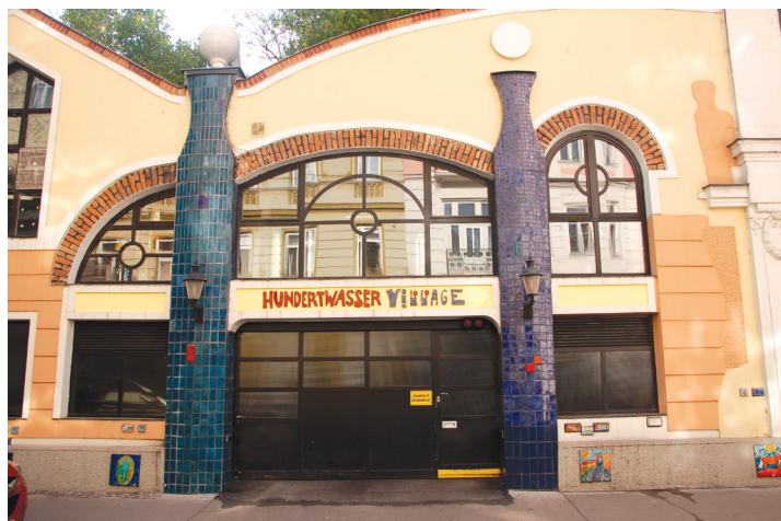
II. 3. Garaż Kalke, zaadaptowany na przestrzeń społeczną Hundertwasser Village, widok od ulicy Untere Weissgerberstrasse (fot. M. Bednarz)
