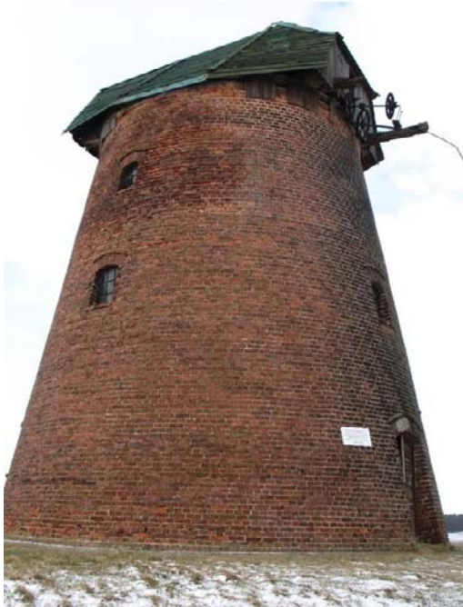
Ryc. 1. Łąkorz, wiatrak „holender”, widok ogólny od strony południowo-wschodniej, stan obecny. Fot. J. Kielar, luty 2011
