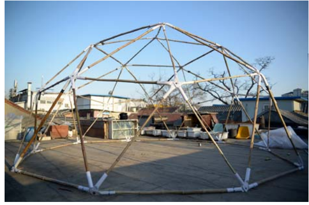
Ryc. 15. Instalacja cieplarni na dachu Si He Yuan w hutongu Da Shi Lar, przeprowadzona w ramach BJDW. Autor: Adam Chałupski, 2013
