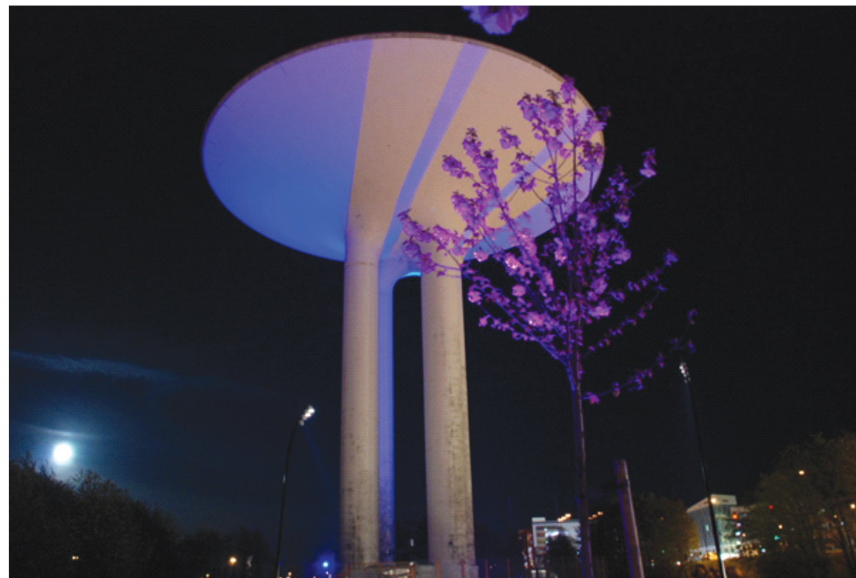
II. 2. Wieża ciśnień Hyllie, Malmoe, Szwecja, fot. M. Kowalski / Hyllie water tower, Malmoe, Sweden, Pict. M. Kowalski
