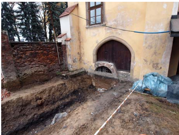
Ryc. 7. Wschodnia elewacja przeoratu (fragment); zamurowany wschodni wylot kanału z czołem wtórnie podwyższonego sklepienia kolebkowego, usytuowanego powyżej dna pomieszczenia sutereny
