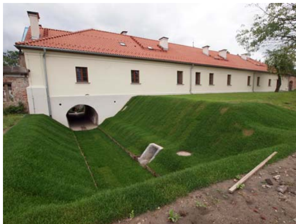
Ryc. 8. Wschodnia elewacja budynku barokowego z odnowionym kanałem i zrekonstruowanym końcowym odcinkiem koryta młynówki
