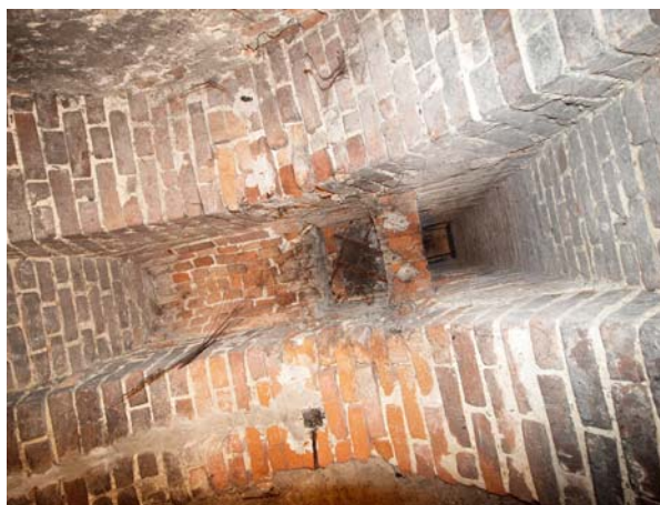
Ryc. 6. Arkady wsporcze latryn nad kanałem pod przeoratem, z dwoma wylotami nieczystości z klozetów usytuowanych na różnych wysokościach
