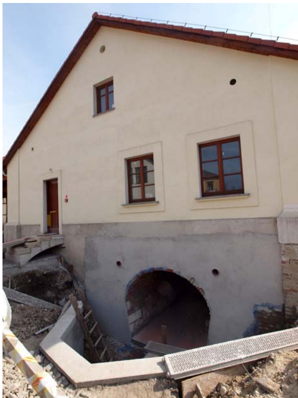
Ryc. 17. Zachodnia elewacja budynku barokowego z włotem kanału i ostrogą zrekonstruowanego mostku na korycie młynówki
