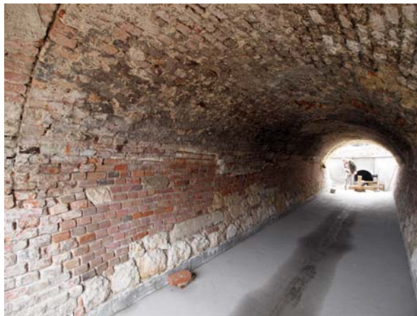
Ryc. 13. Kanał pod budynkiem barokowym po restytucji ścian podłużnych
