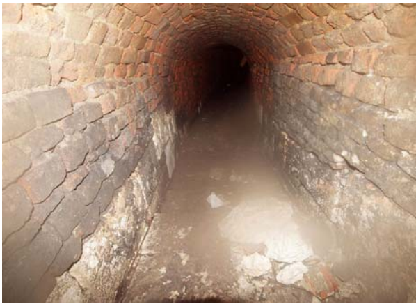
Ryc. 14. Wnętrze jednego z kanałów blokowych Krakowa Fig. 14. Interior of one of block canals in Krakow
