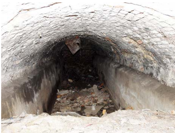
Ryc. 9. Wnętrze kanału wodnego pod budynkiem barokowym przed rozpoczęciem prac
