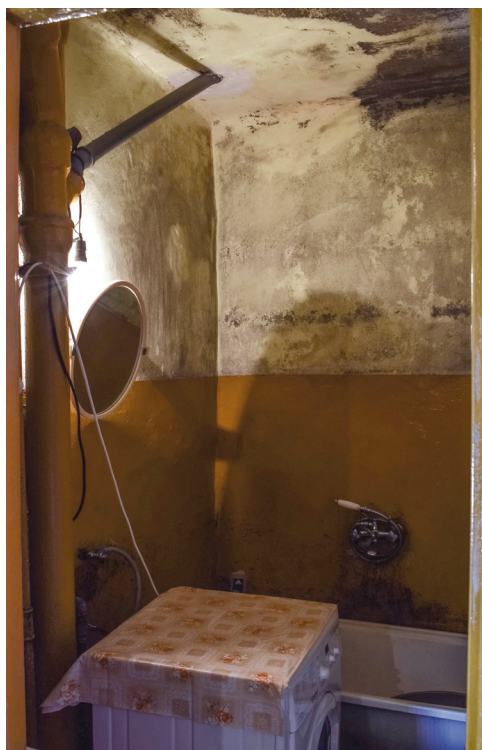
II. 12. łazienka – przed remontem. Bilcza (fot. L. Jańczy)
