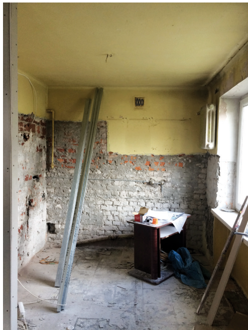
II. 5. Prace remontowe (fot. M. Wijas)
