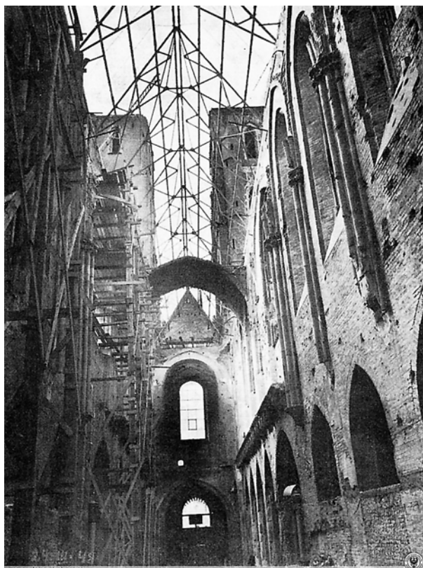
Ryc. 5. Nawa główna ze stalowym rusztem więźby, 1948 (źródło: http://dolny-slask.org.pl/4604458,foto.html dostęp: 2016-10-10)
