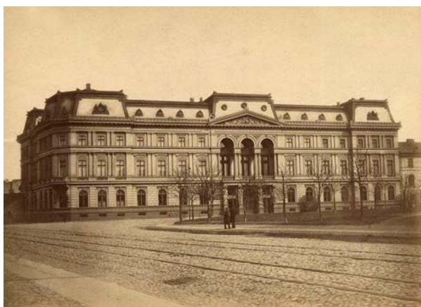
Ryc. 11. Pałac Kronenberga. Warszawa. F. Hitzig, 1867–1871 Fig. 11. Kronenberg Palace. Warsaw. F. Hitzig, 1867–1871
