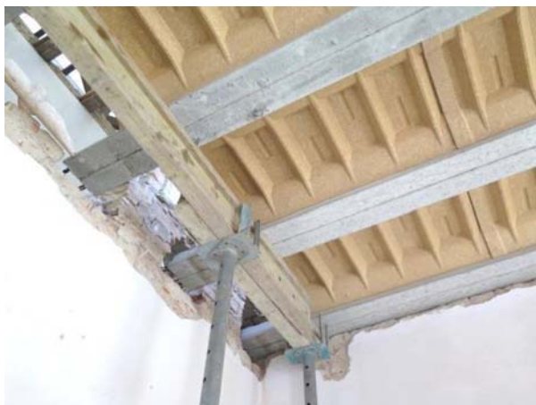
Podparcie belek na czas montażu
