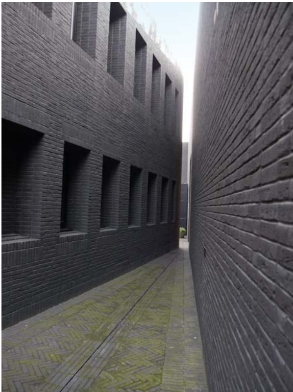
Ryc. 5. Wewnętrzne wąskie przejścia przypominają ulice średnio-wiecznych miast, fot. autor
