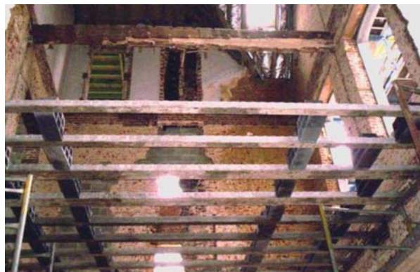
Montaż bezpodporowy
