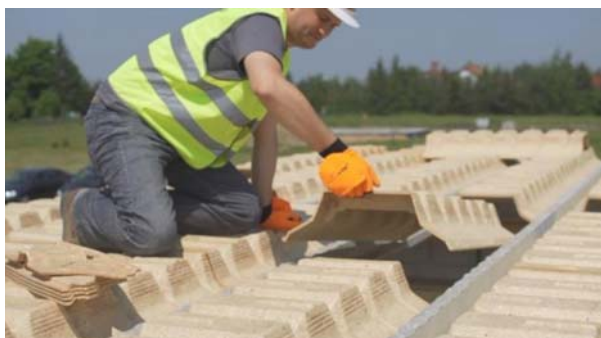
Układanie paneli Rectolight
