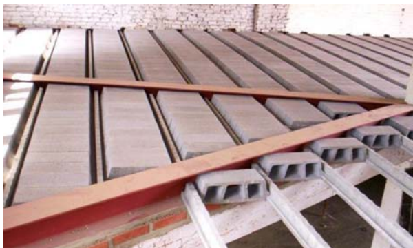
Połączenie systemu z belkami stalowymi
