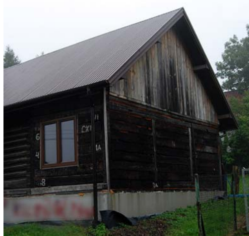
Ryc. 2. Dom jednorodzinny w Ochojnie 41, gm. Świątniki Górne – relokacja fragmentu budynku w miejsce zniszczonej części – zbliżenie – Ł. Wesółowski, 2016
