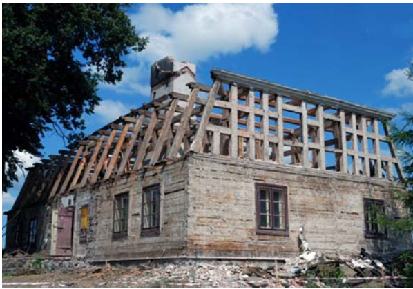
Ryc. 5. Dwór szlachecki w Uniszkach Zawadzkich – demontaż konstrukcji – http://mwmskansen.pl/wp-content/uploads/2011/12/7.-dw%C3%B3r-w-Uniszkach-Zawadzkich-trakcie-prac-rozbi%C3%B3rkowych.jpg , dostęp 08.2016
