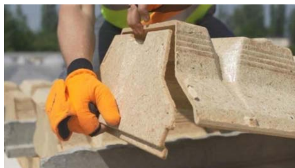
Montaż dekli
