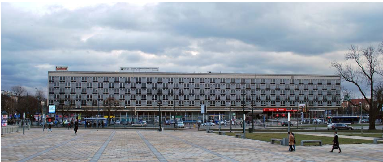
Ryc. 2. Hotel Cracovia – widok głównej fasady (fot. Zygmunt Put Zetpe0202 – Praca własna) Źródło: https://pl.wikipedia.org/wiki/Plik:Former_Cracovia_Hotel_(1960_by_arch._Witold_Cęckiewicz),_1_Marshal_Ferdinand_Foch_Av,_Kraków,_Poland.jpg#/media/File:Former_Cracovia_Hotel_(1960_by_arch._Witold_Cęckiewicz),_1_Marshal_Ferdinand_Foch_Av,_Kraków,_Poland.jpg ; dostęp 2016–10–19
