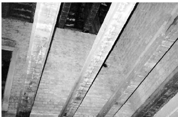
Ryc. 4. Odślonięte belki stropu drewnianego nad salą I piętra Fig. 4. Uncovered timber floor beams over 1 st floor
