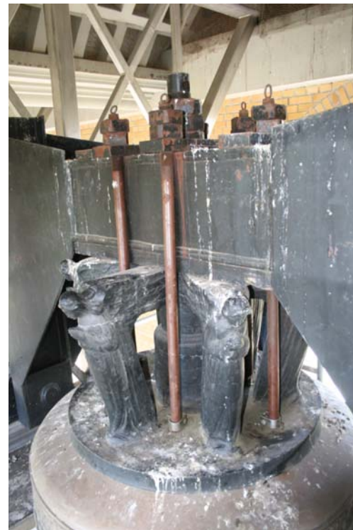
Ryc. 6. Pierwotny sposób mocowania dzwonu Józef Fig. 6. Original method of attaching Józef bell
