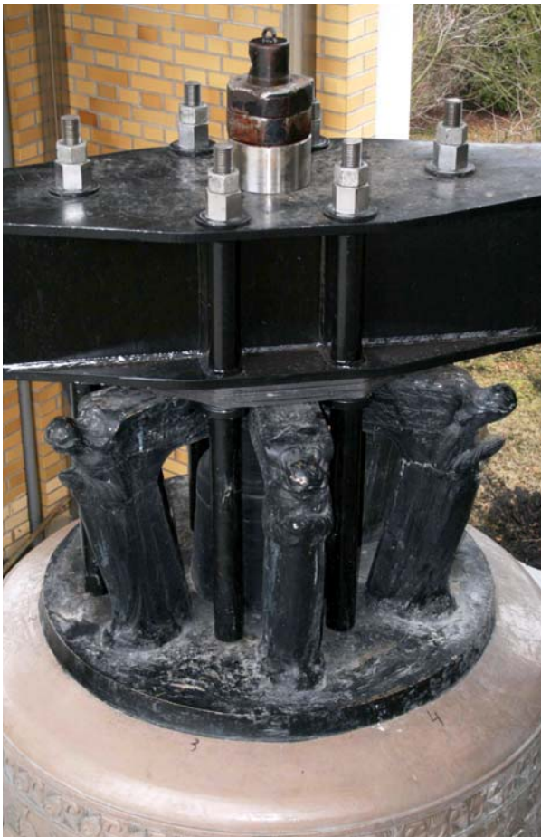
Ryc. 31. Detal połączenia nowego jarzma z dzwonem – widok z góry
