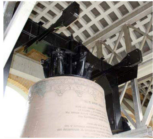
Ryc. 36. Dzwon Józef zawieszony na nowym jarzmie – widok z frontu dzwonnicy
