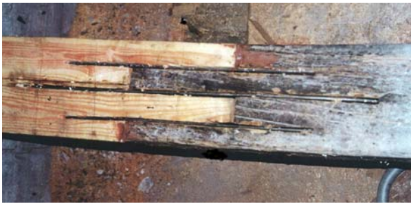
Ryc. 3. Połączenie belek na zwidłowanie wzmacnione pionowymi blachami stalowymi przygotowane do zalania żywicą epoksydową Fig. 3. Finger joint reinforced with vertical steel plates in beam ready for filling with epoxy resin
