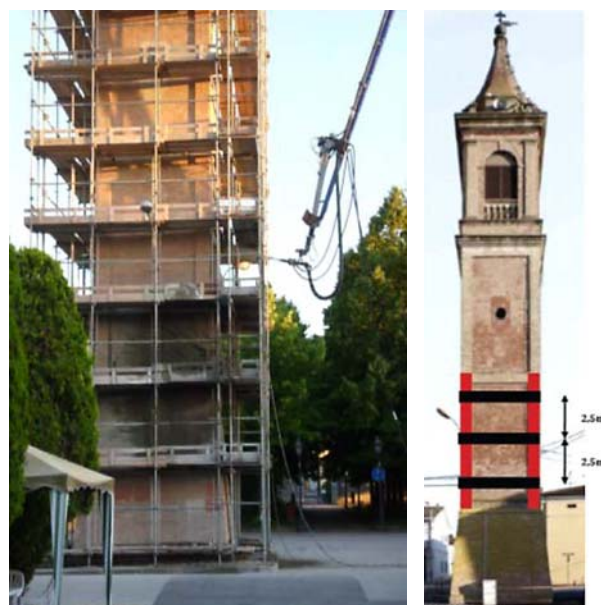
Ryc. 7. Wzmacnianie dzwownicy: a) natrysk materiału FRC, b) owinięcie materiałem FRP
