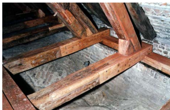
Ryc. 32. Zrekonstruowane węzły podporowe – widok z prawej Fig. 32. Restored support joints – right-side view
