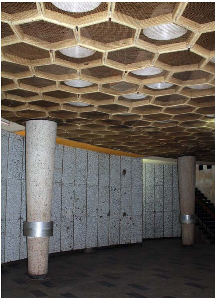
il. 10. Oryginalne, zachowane wnętrza dworca autobusowego. Fot. Edyta Banachowska, listopad 2014 / Kielce Bus Station, the current state. Phot. Edyta Banachowska, November 2014
