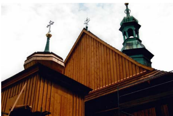
Ryc. 15. Zachodni szczyt nawy oraz fragment niskiej wieży zwieńczonej baniastą kopułą w końcowym stadium prac restauratorskich, czerwiec 2012 r. Fig. 15. Western gable of the nave and a fragment of the low tower topped with a bulbous dome during the final stage of restoration work, June 2012
