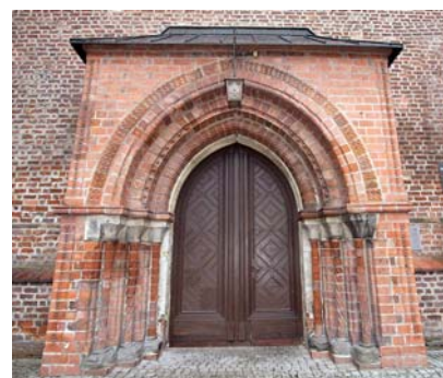
Ryc. 16. Detale architektoniczne dominikańskiej ceglanej architektury późnoromańskiej, formowane z kształtek ceramicznych: portal i fryz z kościoła w Sandomierzu; portal zachodni kościoła w Poznaniu. Fot. A. Bojęś-Białasik
