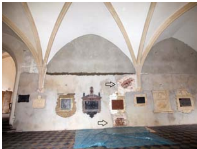
Ryc. 2. Kraków, klasztor oo. Dominikanów; fragment ściany (zachodniej) zachodniego skrzydła krużganka przy I wirydarzu w trakcie prac konserwatorskich. Strzałkami oznaczono odkryte relikty archiwolty i ościeża portalu późnoromańskiego. Fot. A. Bojęś-Białasik
