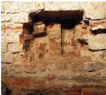
Ryc. 9. Skuty relikt lewego ościeża portalu późnoromańskiego widoczny w odkrywce wgłębnej. A. Bojęś-Białasik
