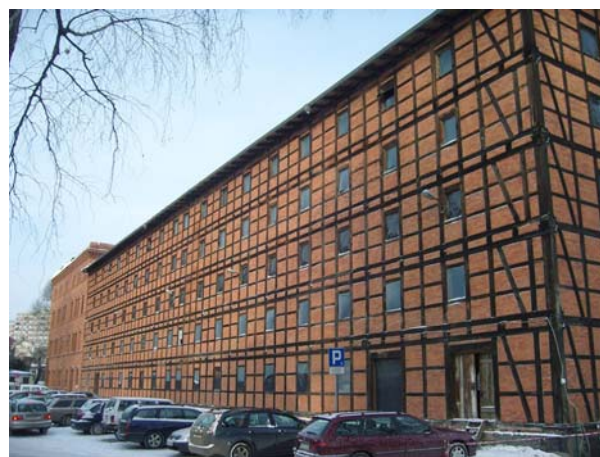
Ryc. 8. Bydgoszcz, młyn Rothera, elewacja południowa dawnego magazynu mącznego (fot. R. Sochaczewski, 2011)
