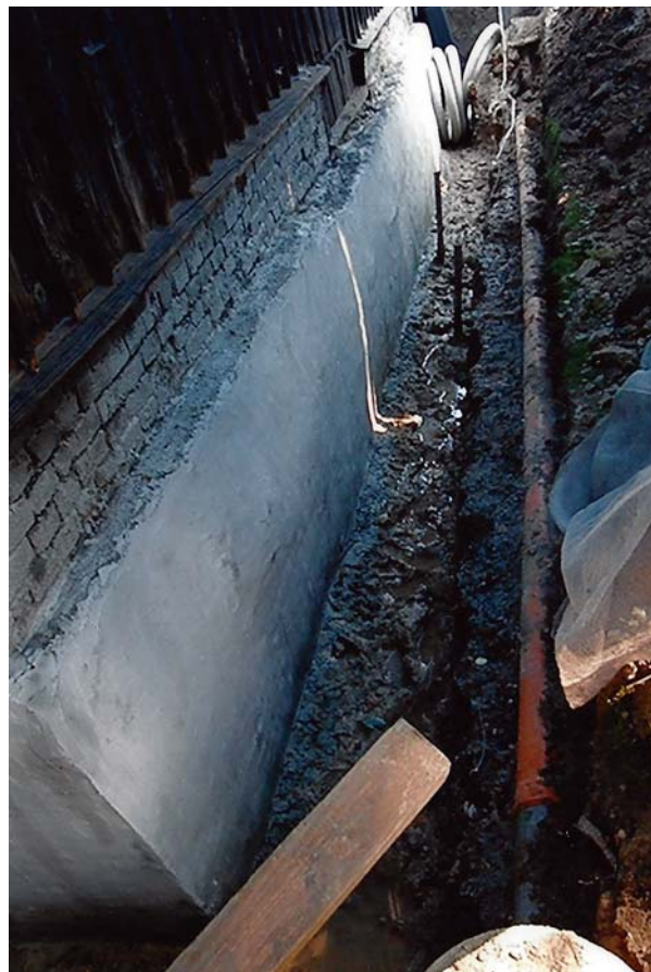
Ryc. 12. Prace przy wzmocnieniu fundamentów kościoła i zakładaniu drenażu, 2011 r.
