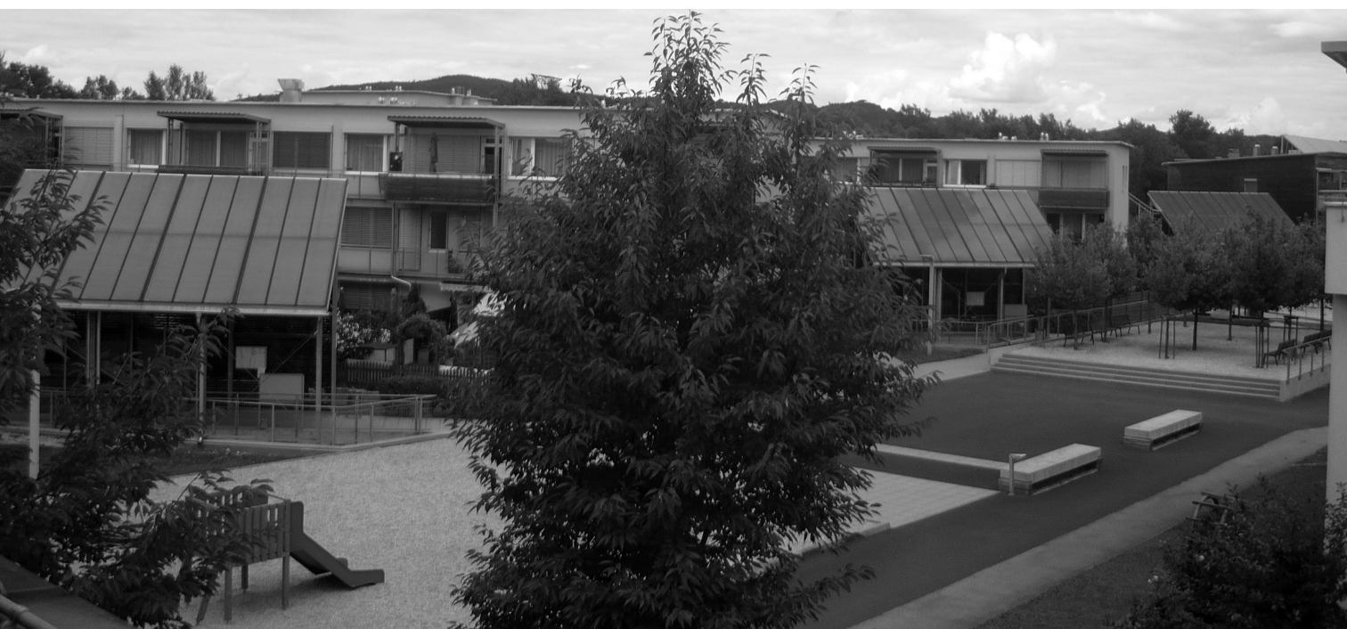
Przestrzeń społeczna. Zrównoważone osiedle mieszkaniowe Solar City. Linz, Austria / Social Space. Sustainable Housing Estate, Solar City. Linz, Austria
