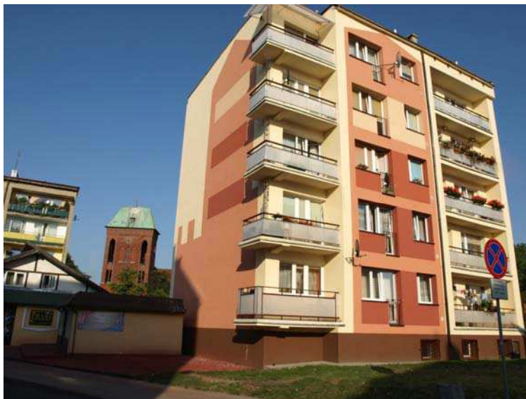
Ryc. 2. Kamień Pomorski. Wieża katedry kamieńskiej zdominowana przez „pudełkową” zabudowę powojenną. Przykład negatywnego przewartościowania w kompozycji krajobrazu miejskiego. Fot. autor
