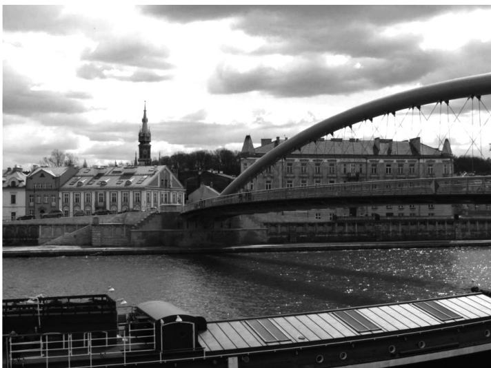
II. 4. Kładka piesza między Kazimierzem i Podgórzem przyczyniła się do ożywienia tej części nadwiślańskiego bulwaru (fot. Z. Zuziak)
