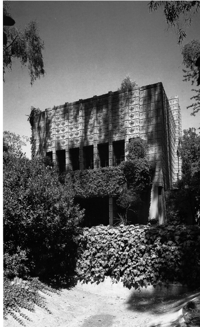
II. 5. Dom Alice Millard, „La Miniatura”, Pasadena, Kalifornia, 1923 – widok ogólny z zachodu (źródło: [1] 57)
