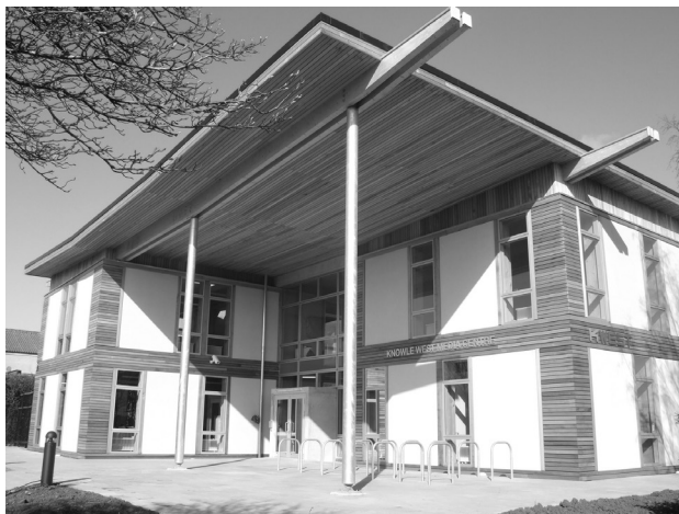
II. 2. Knowle West Media Center w Bristolu, Wielka Brytania – budynek wzniesiony z paneli ModCell® (źródło: www.modcell.com )
