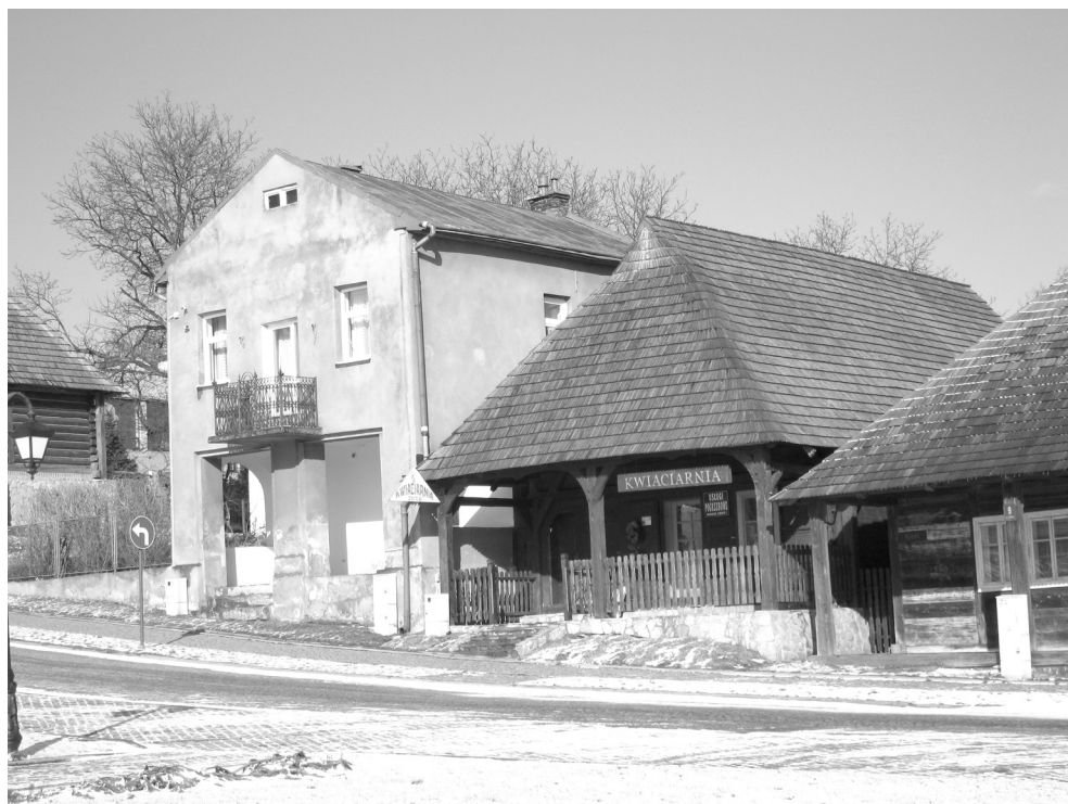
II. 4. Drewniana zabudowa w rynku w Pruchniku w otoczeniu murowanych domów odbiegających charakterem od form zabytkowych
