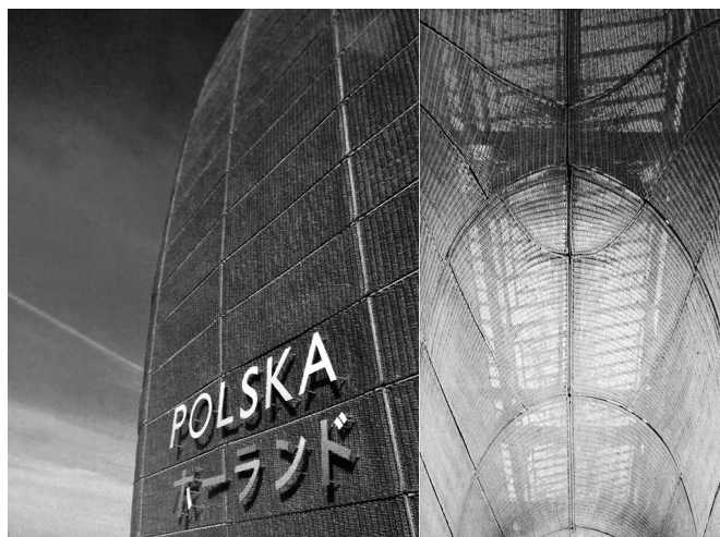
Rys. 4. Expo 2005, Aichi. Elewacja z paneli wiklinowych pawilonu polskiego. Projekt pawilonu architektki Ingarden K. i Ewy J. oraz artysta plastyk Janicki A., współpraca architektki: Urbanowicz P., Hojda P., Haduch B., Machaj S., Starzycki D., Smogulecki G., Chuchacz P., Bury B., Chowaniec R.
