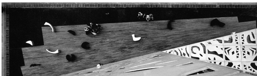
Rys. 11. Expo 2010, Szanghaj. Fragment modułowej elewacji ze sklejki z widokiem na plac przedwejściowy
